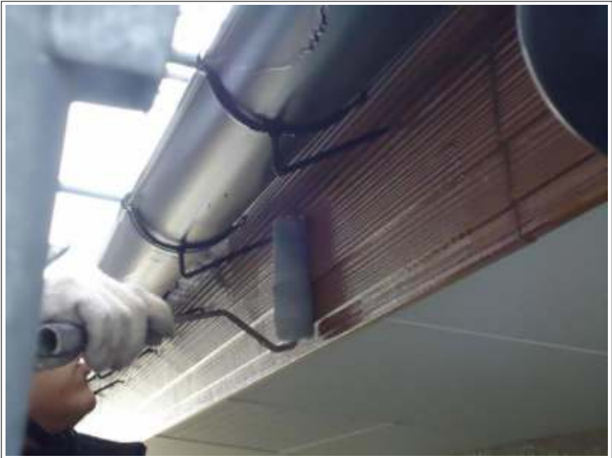
破風板塗装施工中
