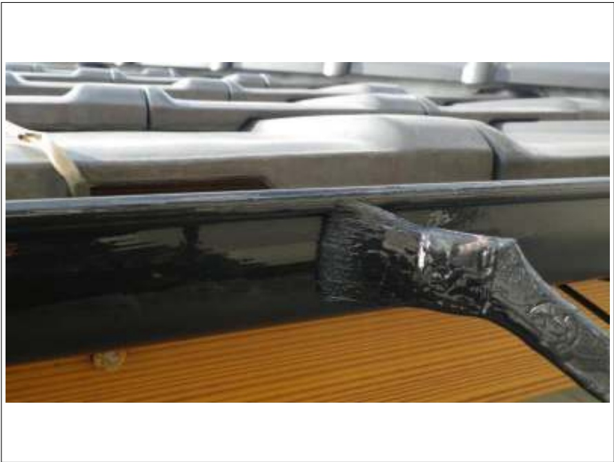
樋塗装 1 回目施工中
