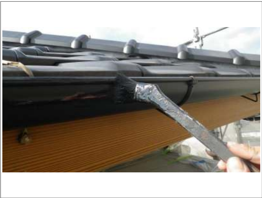
樋塗装 1 回目施工中
