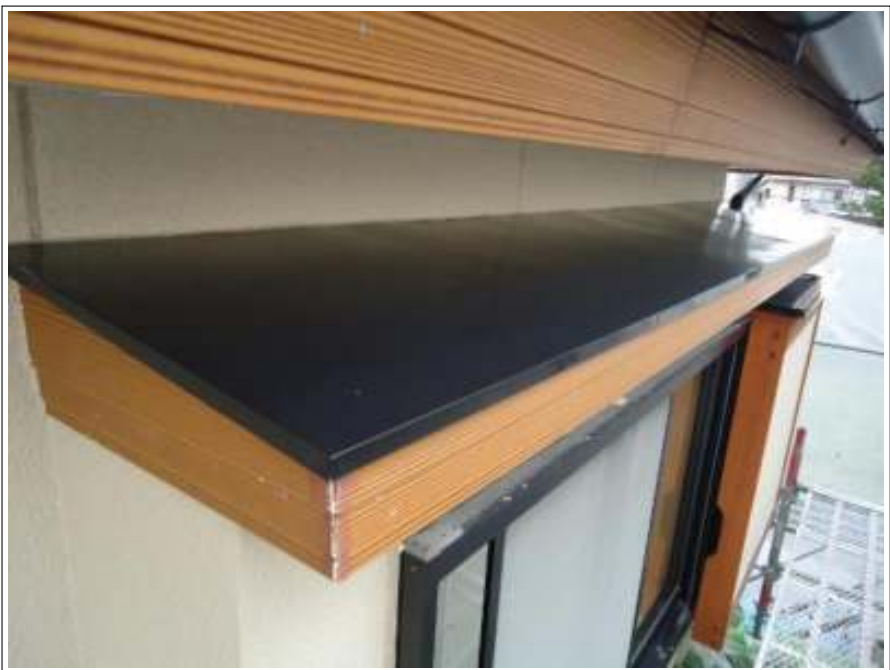
小庇塗装施工完了
