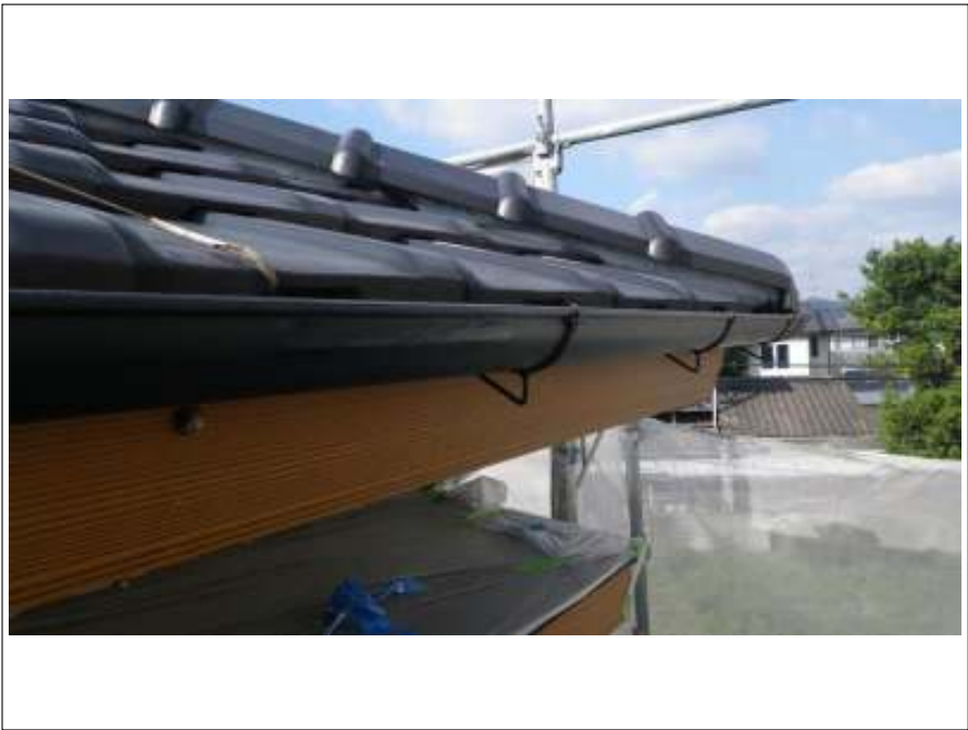
樋塗装 1 回目施工完了
