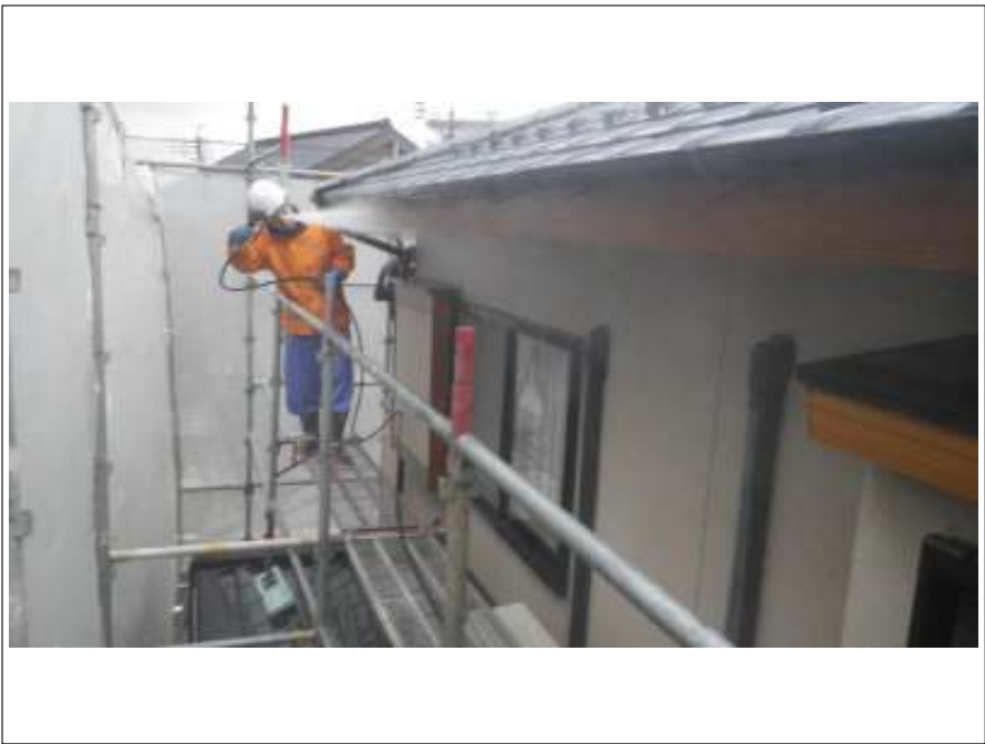
破風板高压洗净施工中
