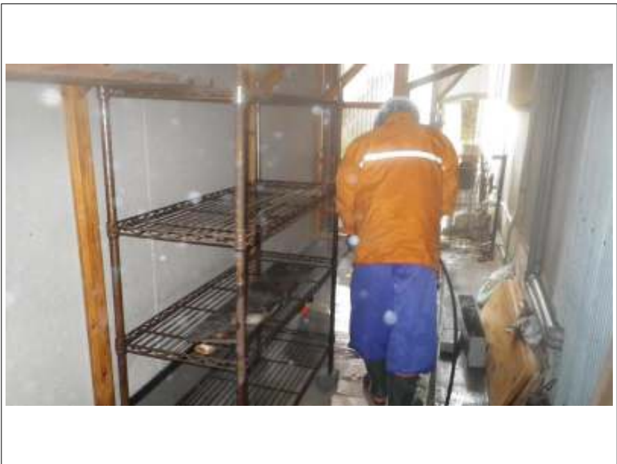
土間高圧洗浄施工中
