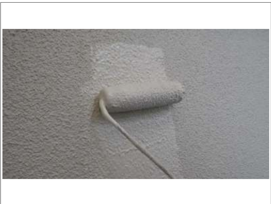
外壁塗装下塗り施工中
