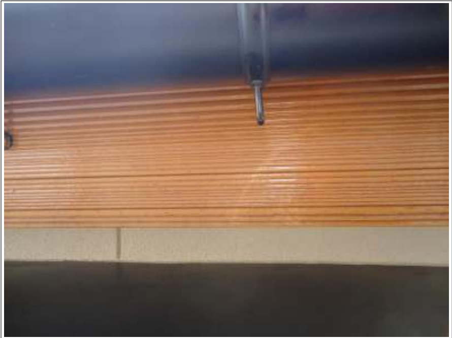
破風板塗装施工完了
