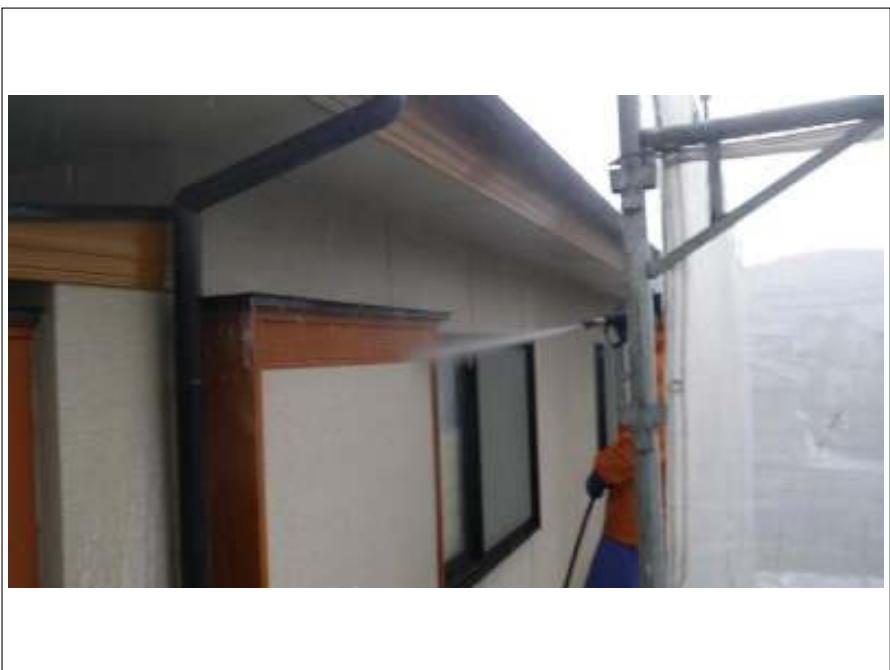
雨戸高压洗净施工中
