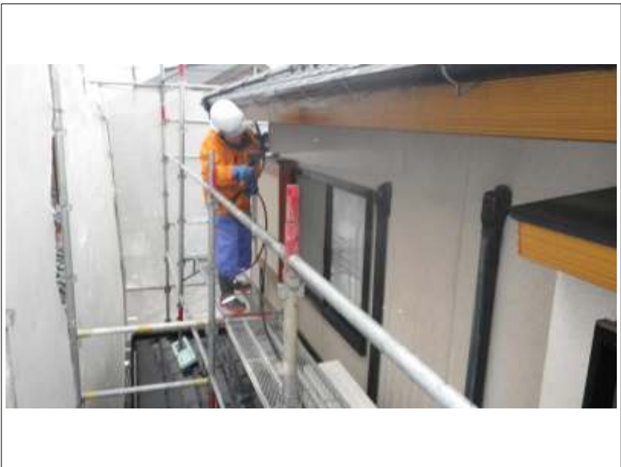
外壁高压洗净施工中
