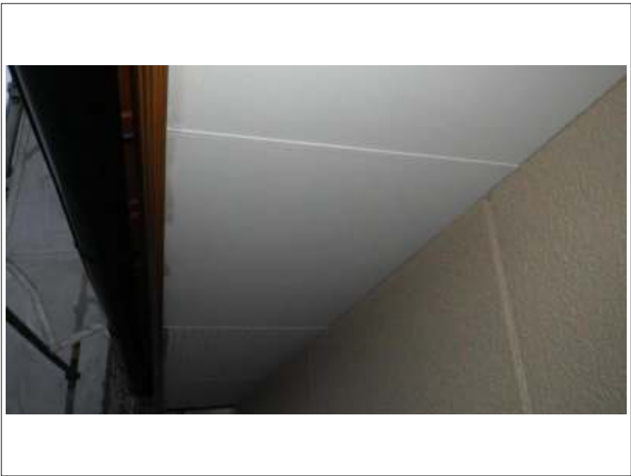
軒天塗装施工完了
