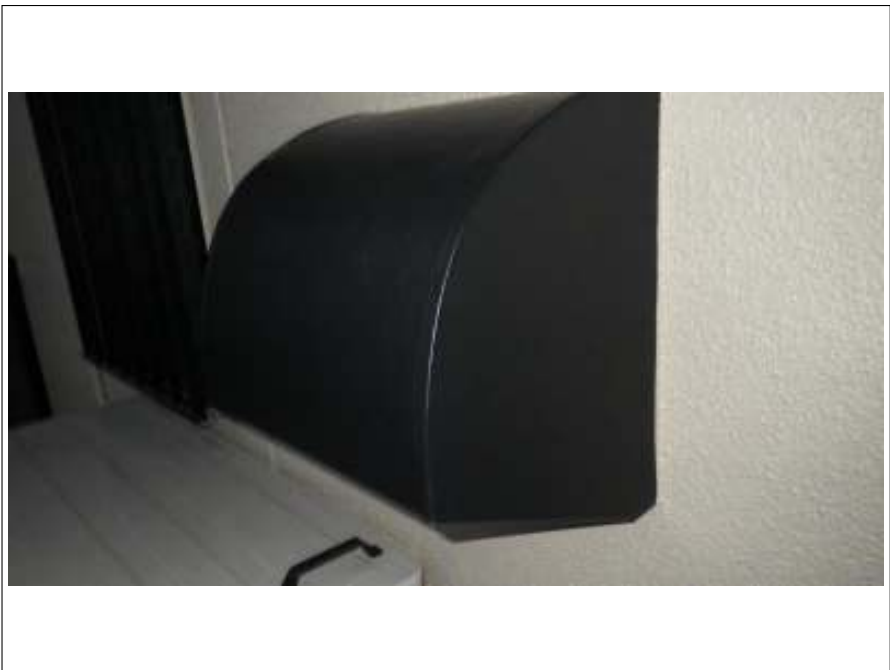
換気フード塗装施工完了
