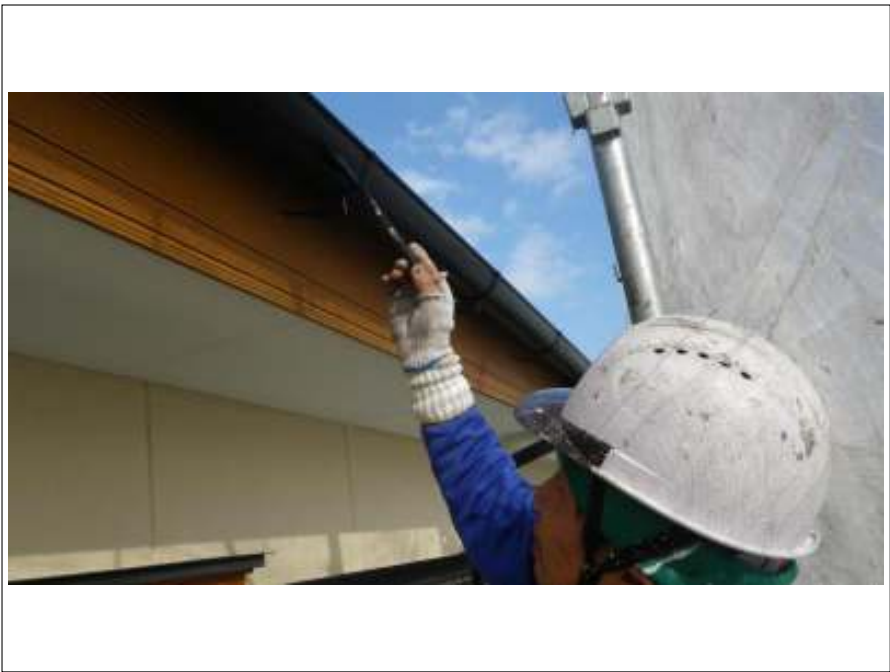
樋塗装 2 回目施工中
