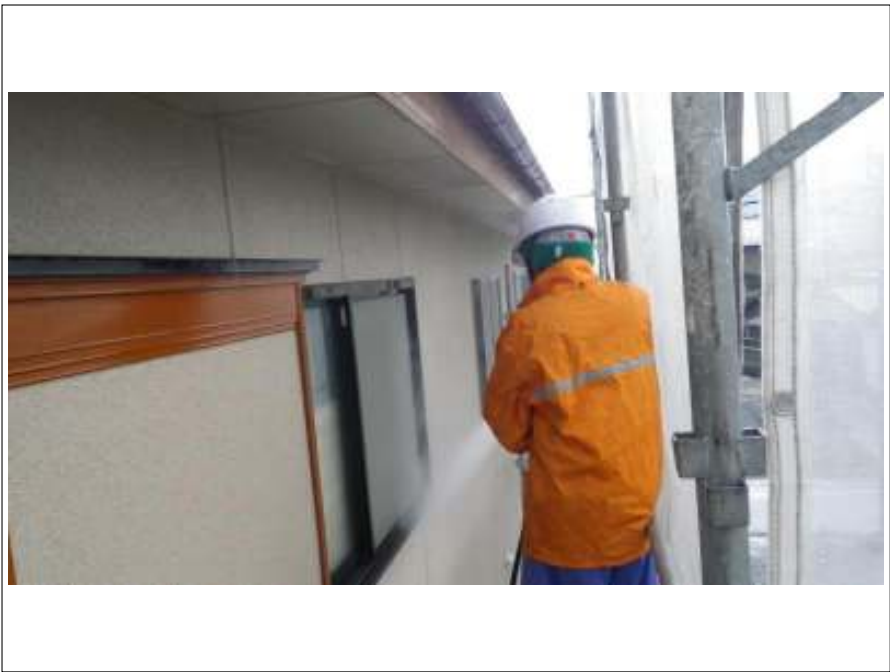
窓高圧洗浄施工中
