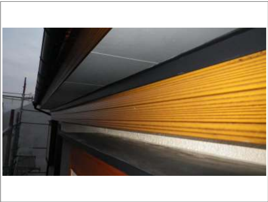
破風板塗装施工完了
