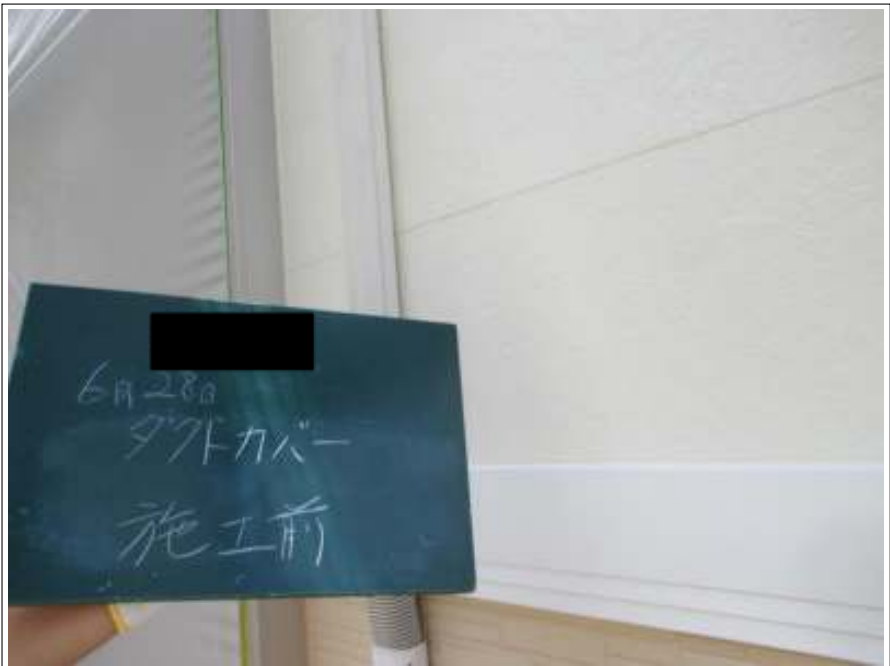
ダクトカバー 施工前
