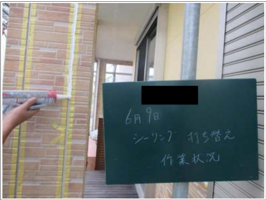
外壁 シーリング打ち替え施工中
