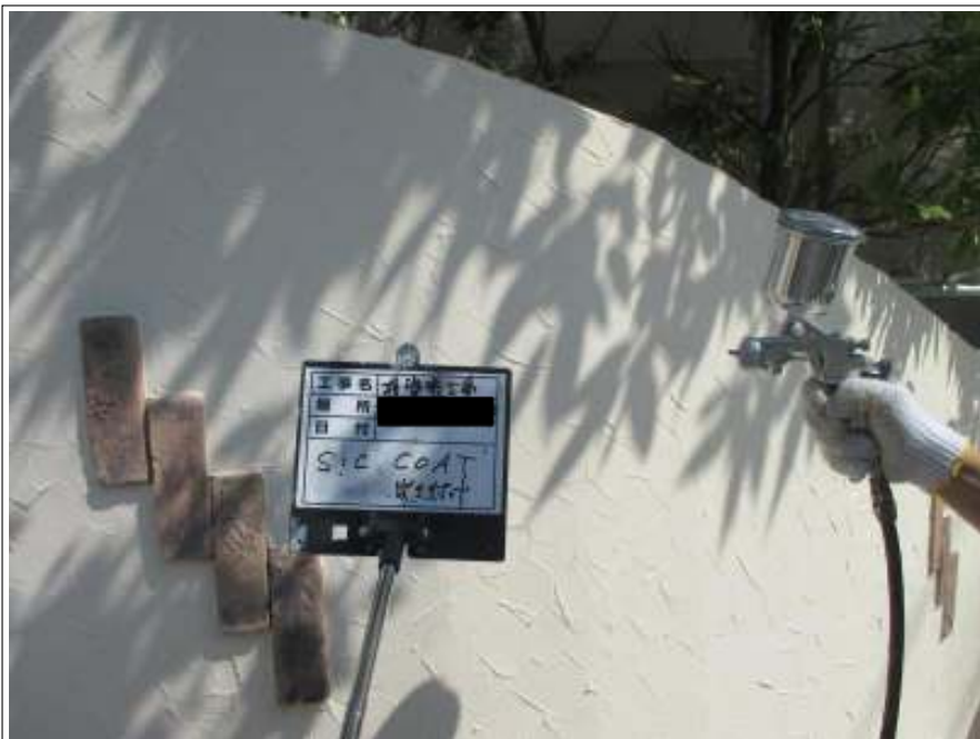
塀 シックコート吹付け
