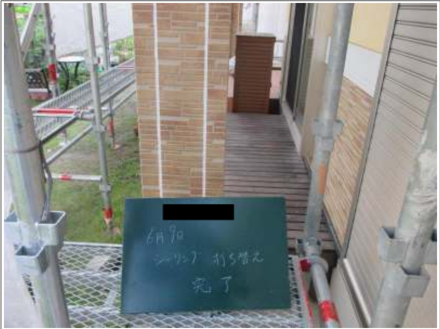
外壁 シーリング打ち替え施工完了
