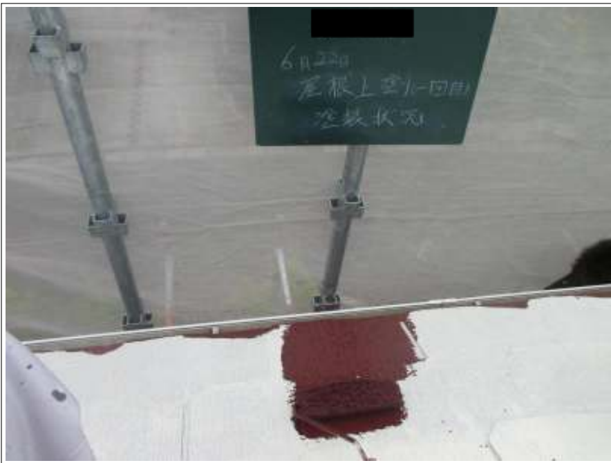
屋根 中塗り施工中
