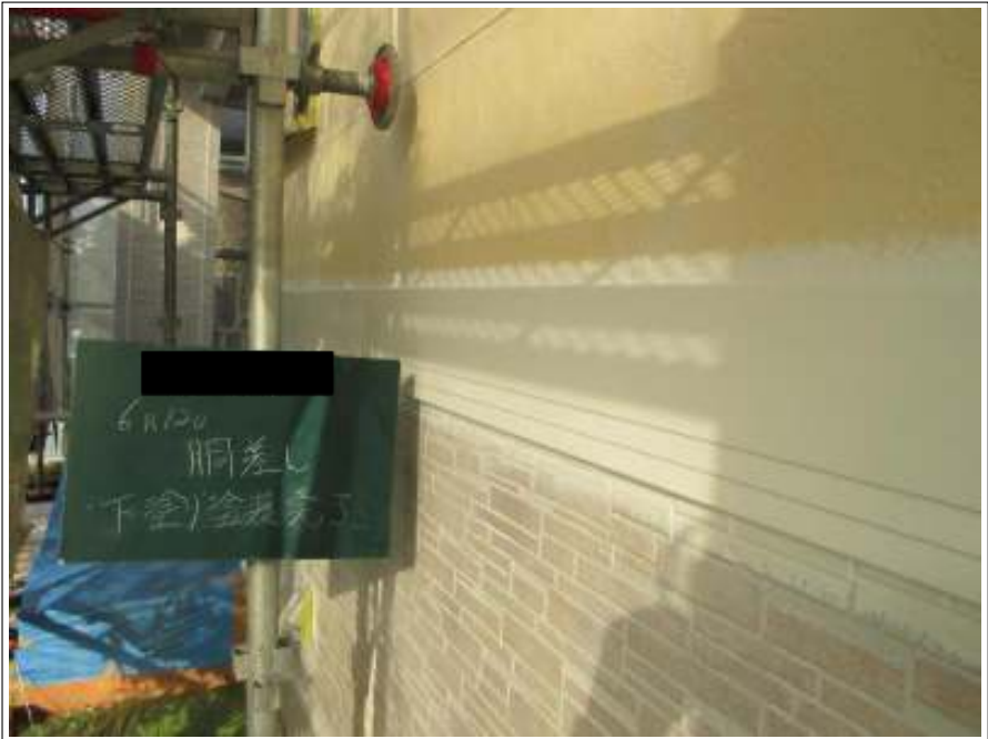
洞差し 下塗り施工完了
