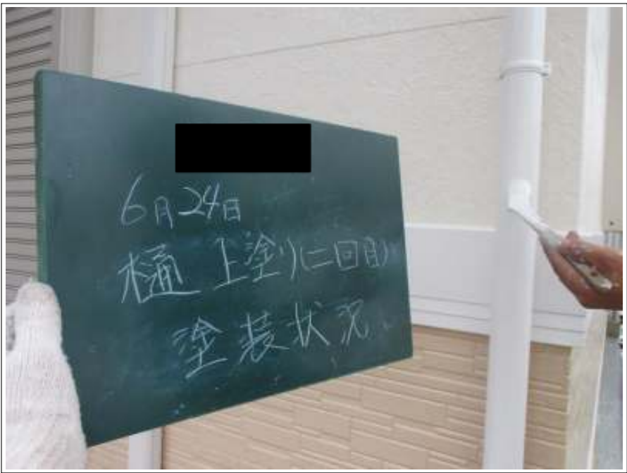
樋 上塗り施工中(2回目)
