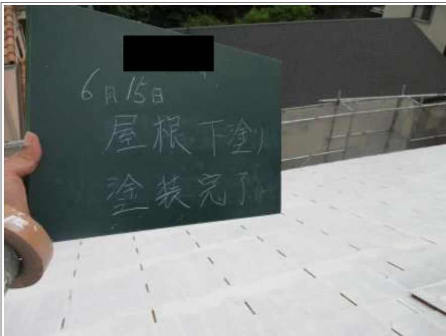
屋根 下塗り施工完了
