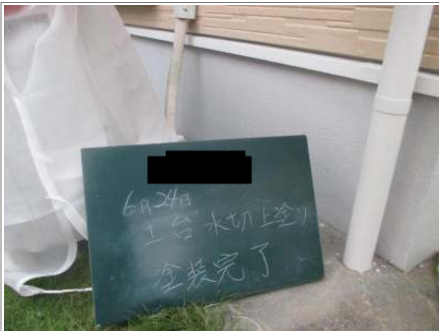
土台水切り 上塗り施工完了
