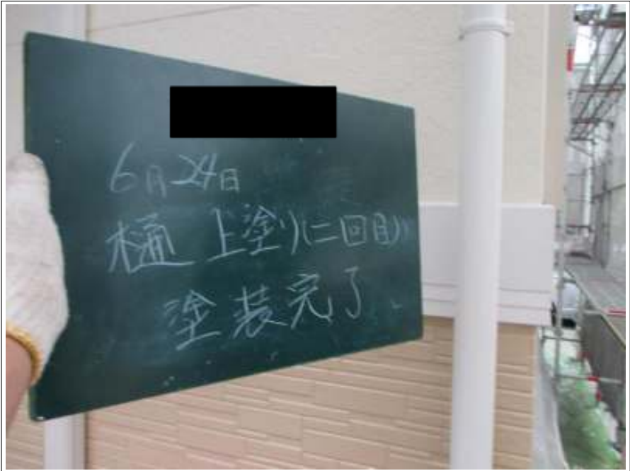
樋 上塗り施工完了(2回目)
