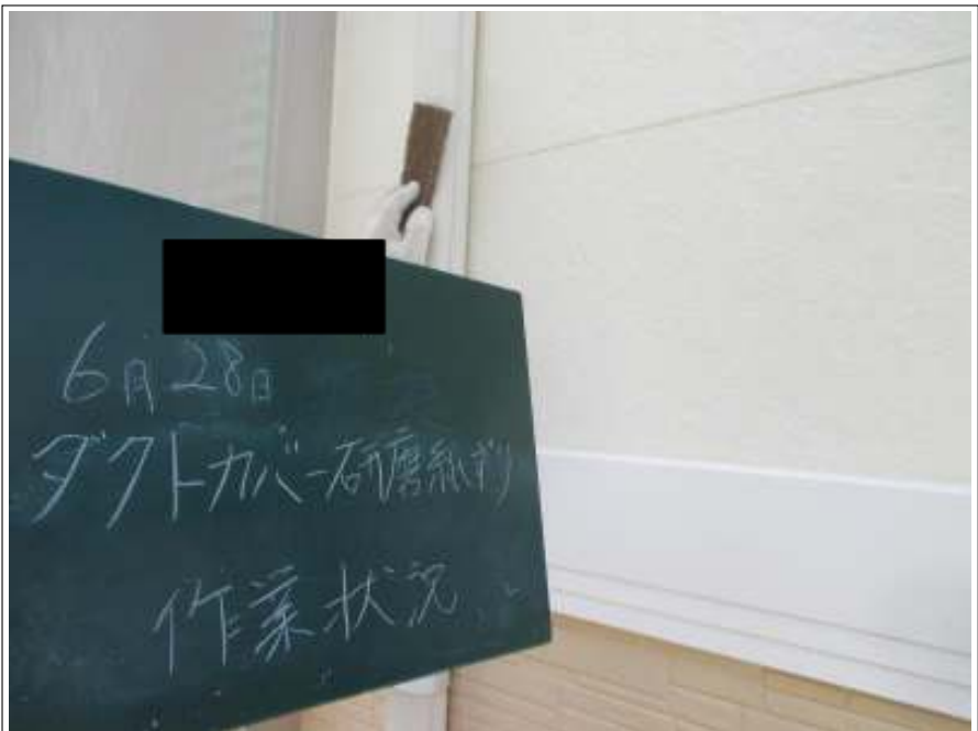
ダクトカバー 研磨紙ずり施工中
