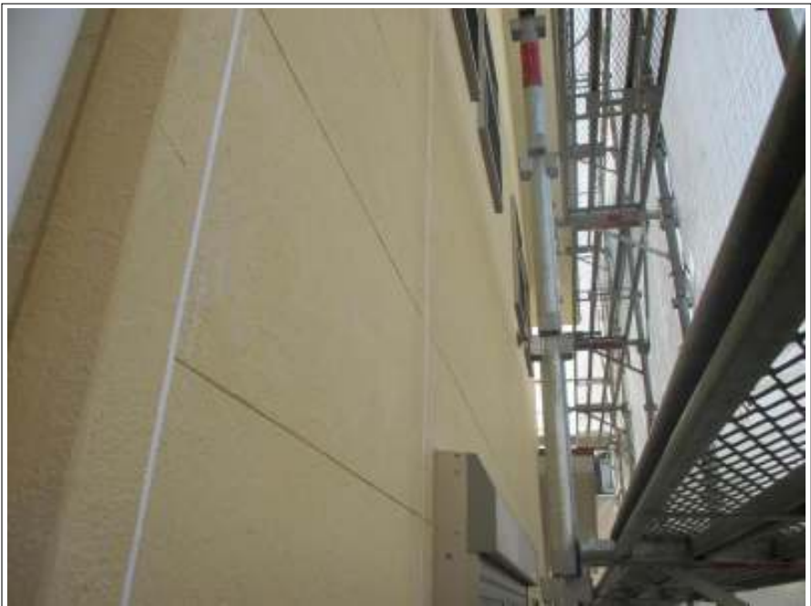
外壁 シーリング打ち替え施工完了
