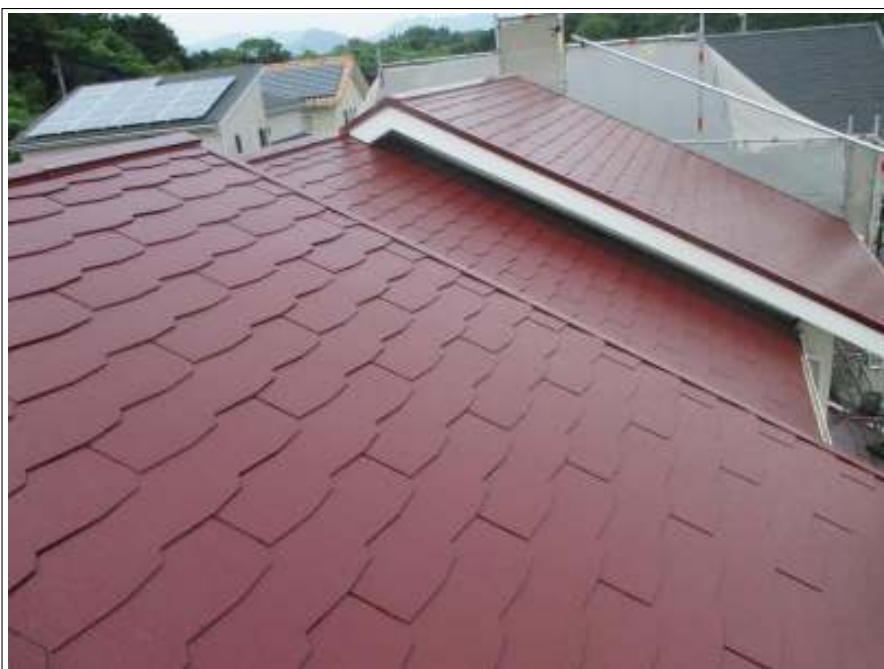
屋根 施工完了
