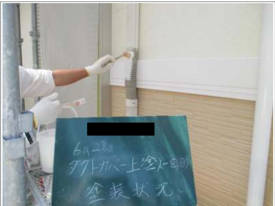
ダクトカバー 上塗り施工中(1回目)
