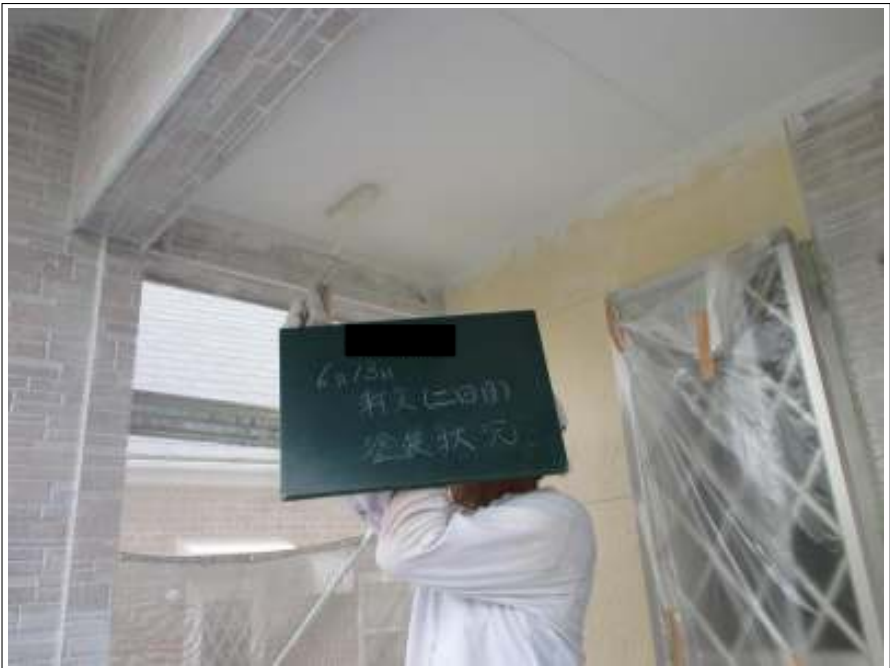
軒天 上塗り施工中(2回目)
