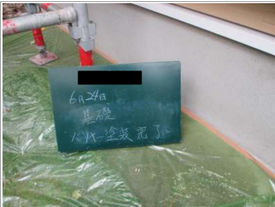
基礎 バリヤー施工完了
