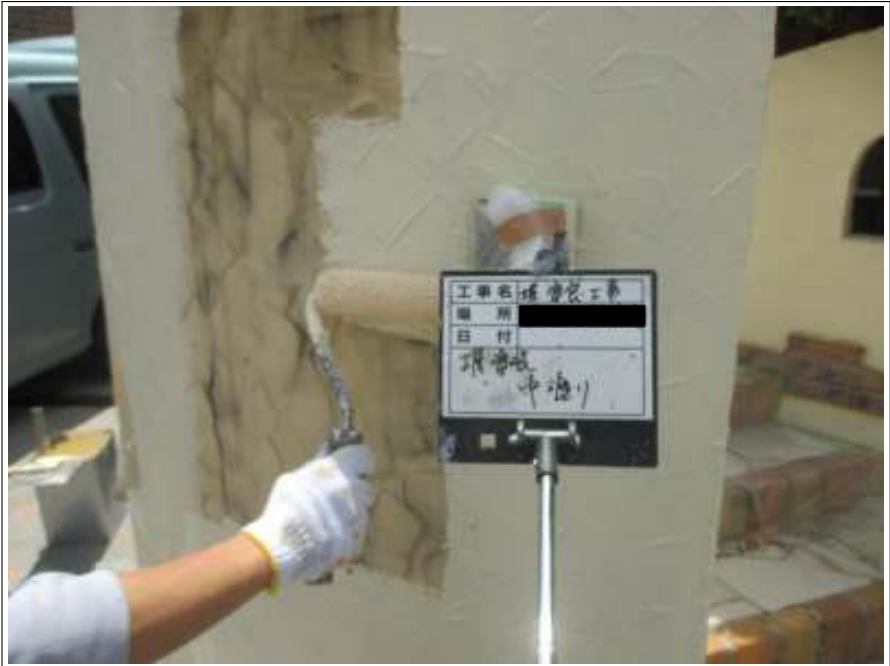
塀 中塗り施工中
