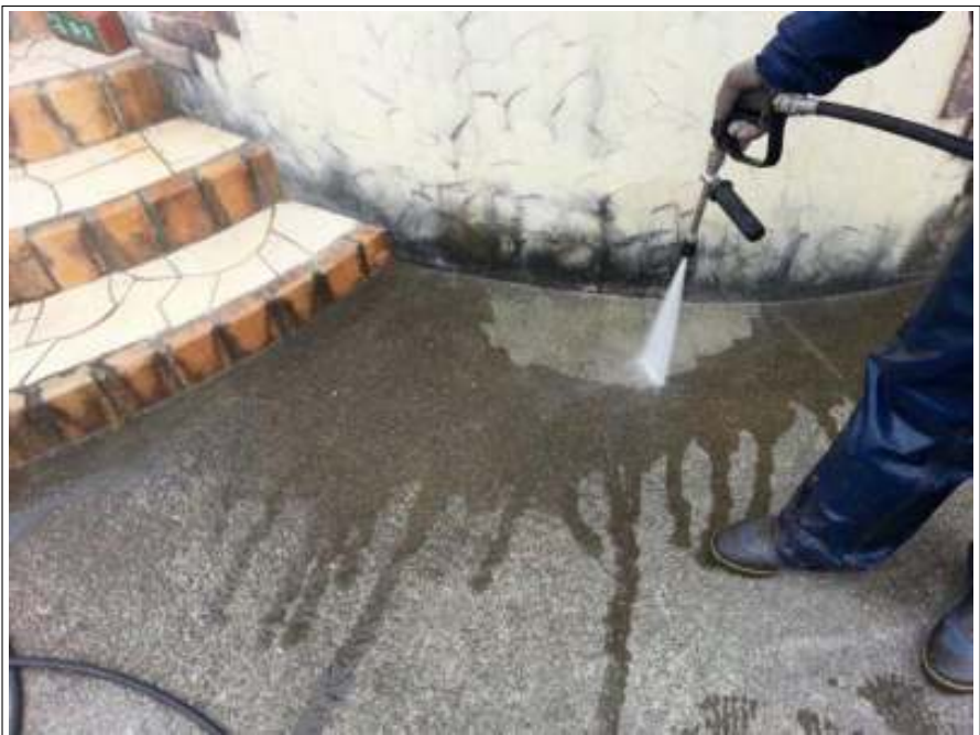
土間 高圧洗浄中
