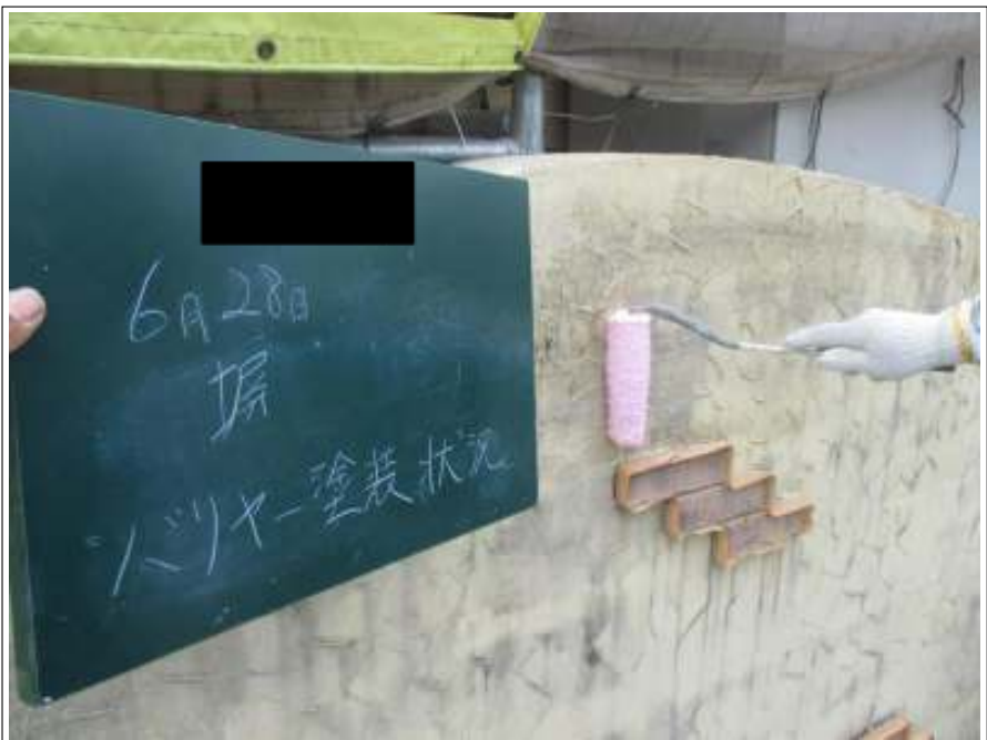
塀 バリヤー施工中
