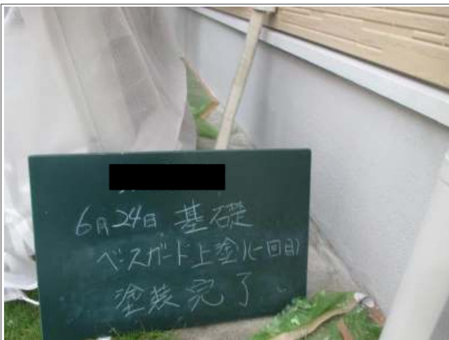
基礎 上塗り施工完了(1回目)
