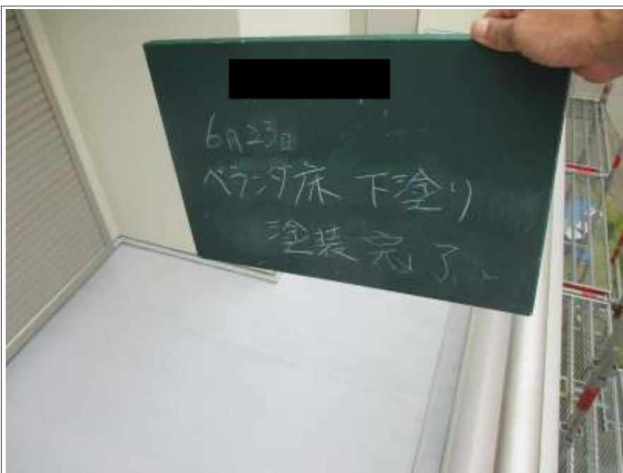
ベランダ床 下塗り施工完了
