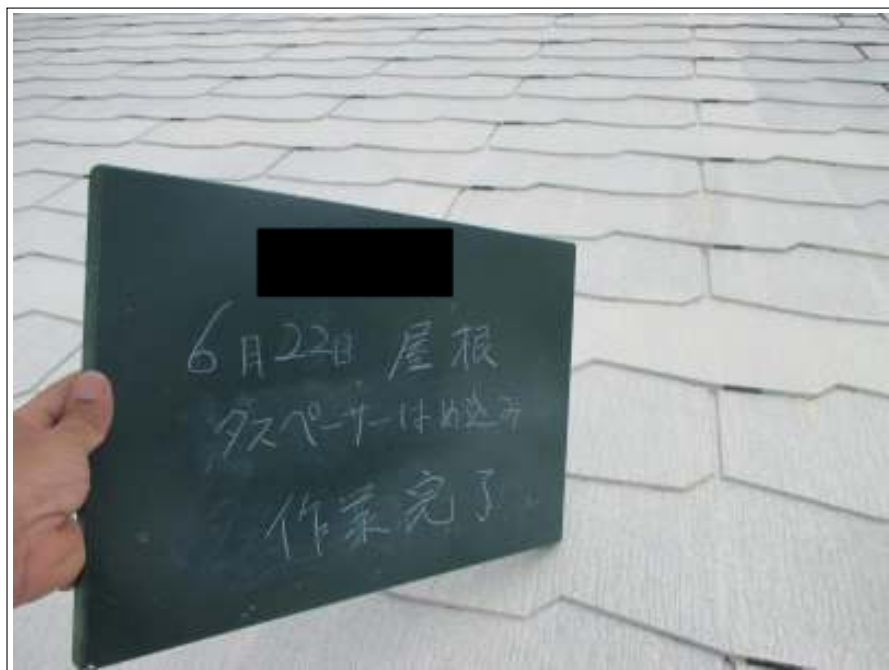
屋根 タスペーサー施工完了
