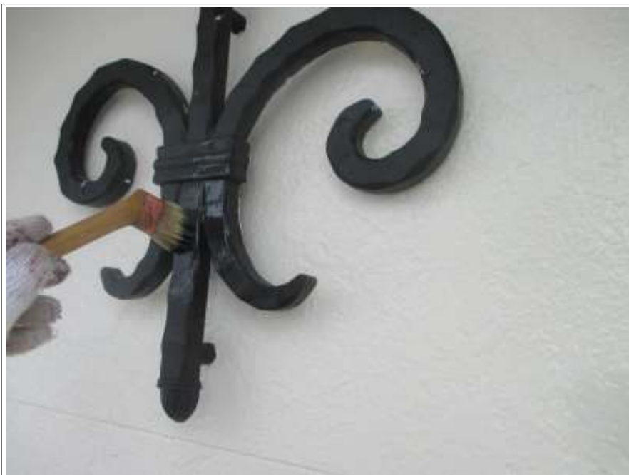
外壁アクセント 施工中
