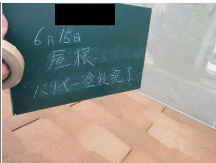
屋根 バリヤー施工完了
