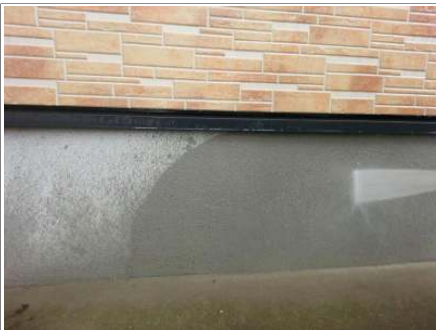
基礎 高圧洗浄中
