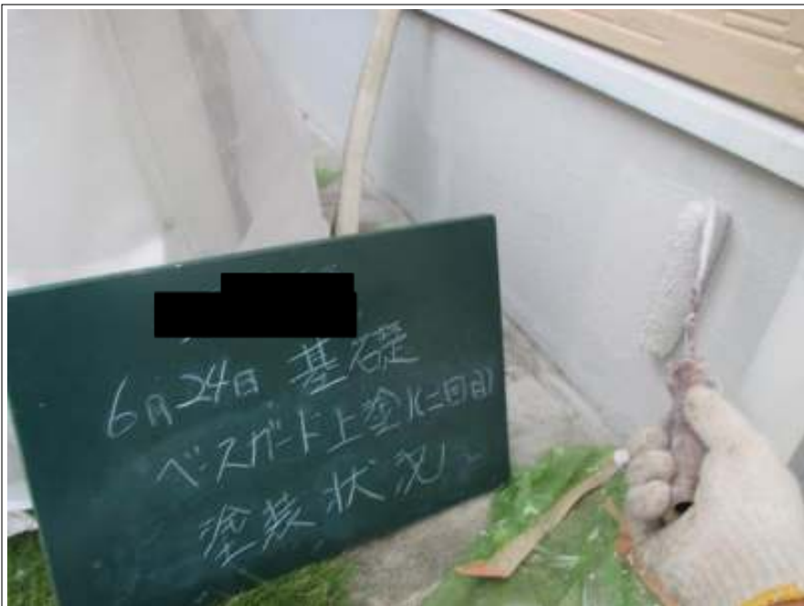
基礎 上塗り施工中(2回目)
