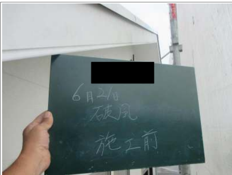
破風板 施工前
