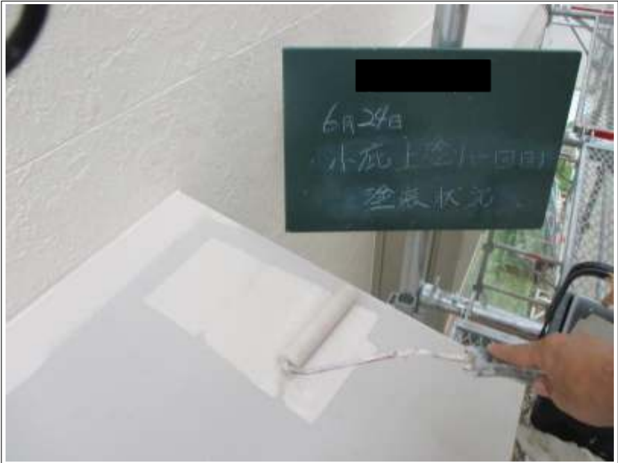
小庇 上塗り施工中(1回目)
