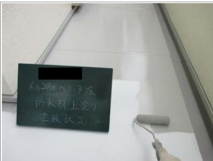
ベランダ床 上塗り施工中
