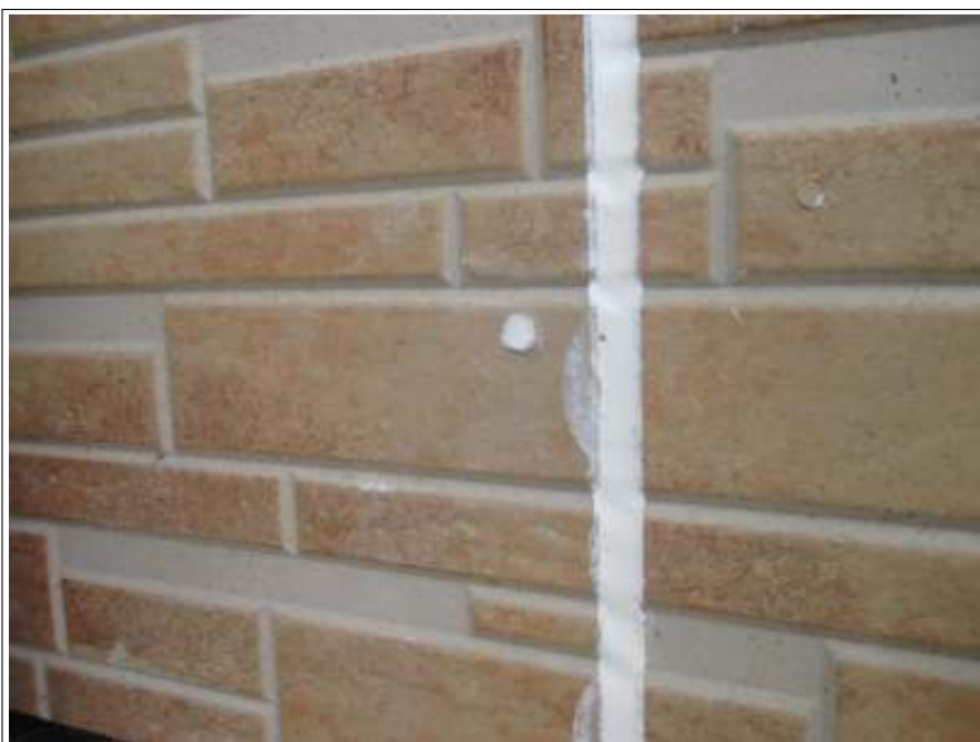
外壁 シーリング打ち替え施工完了
