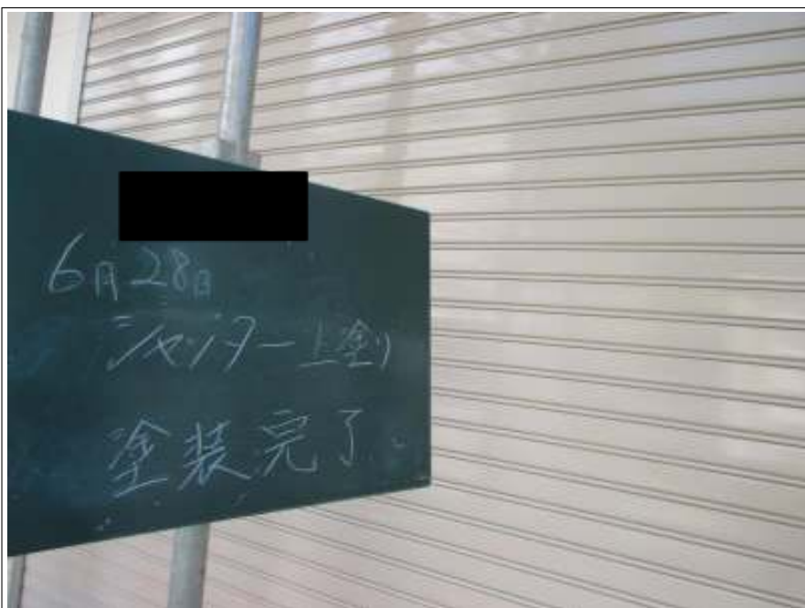
シャッター 上塗り施工完了
