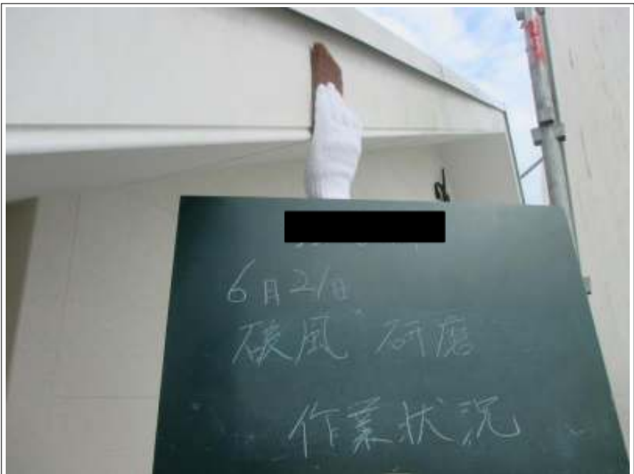
破風板 研磨紙ずり施工中
