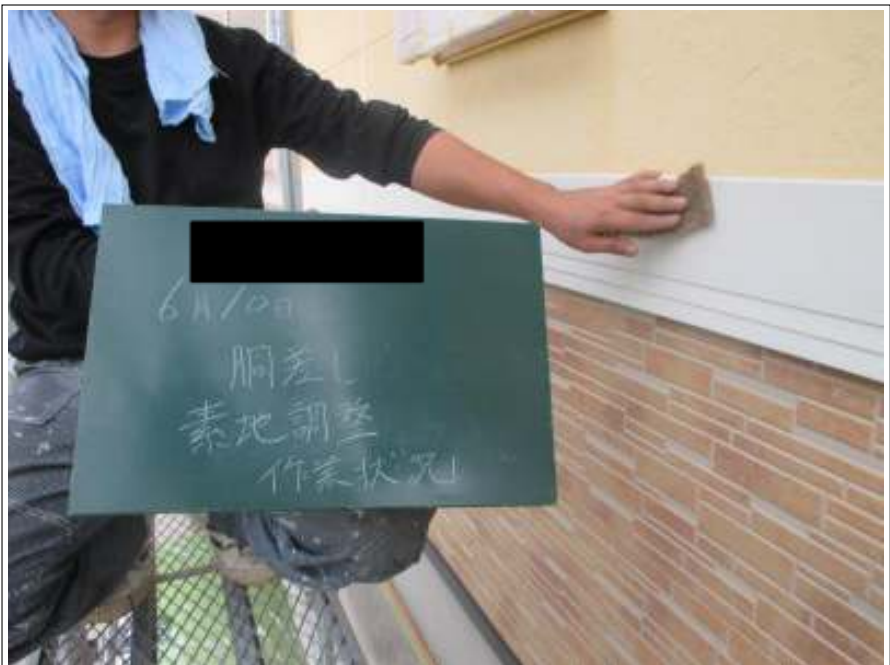
洞差し 研磨紙ずり施工中
