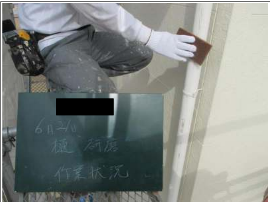
樋 研磨紙ずり施工中
