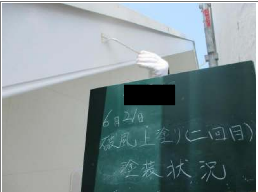
破風板 上塗り施工中(2回目)
