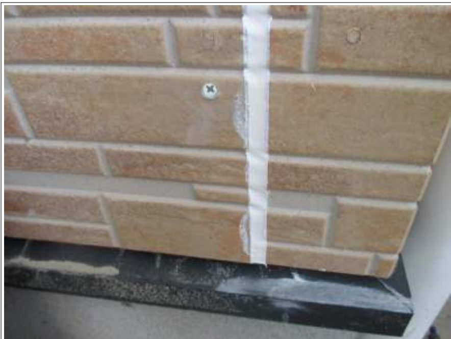
外壁 シーリング打ち替え施工完了
