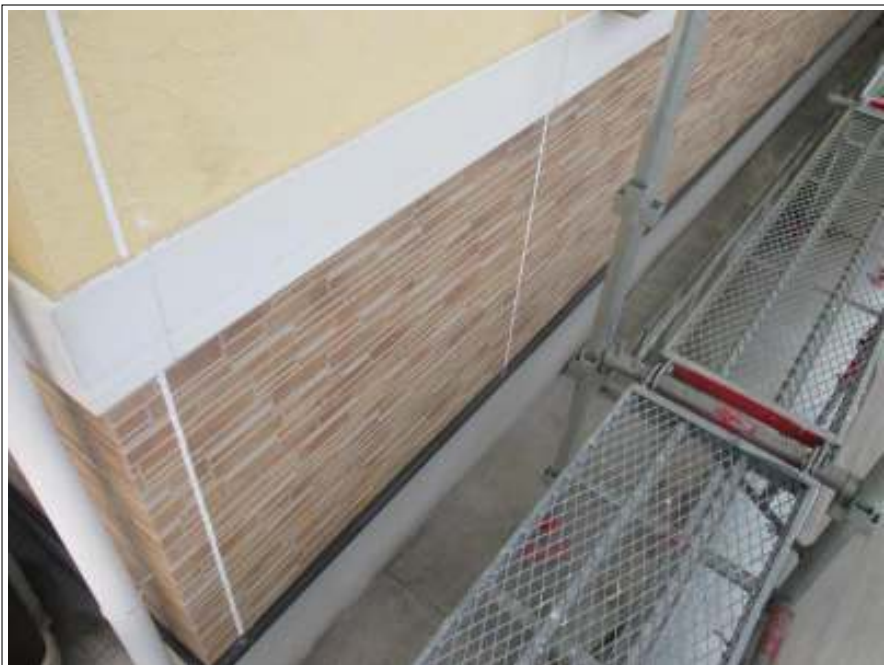
外壁 シーリング打ち替え施工完了
