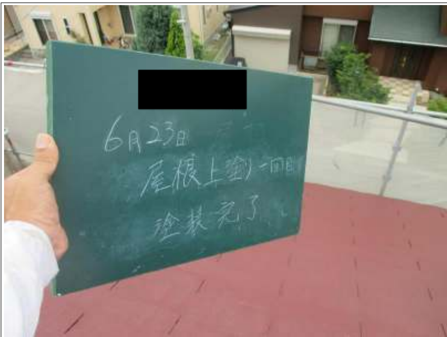
屋根 中塗り施工完了
