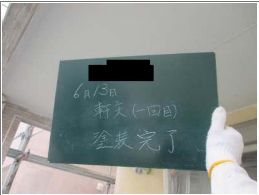
軒天 上塗り施工完了(1回目)
