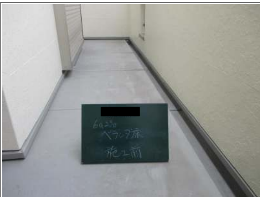
ベランダ床 施工前
