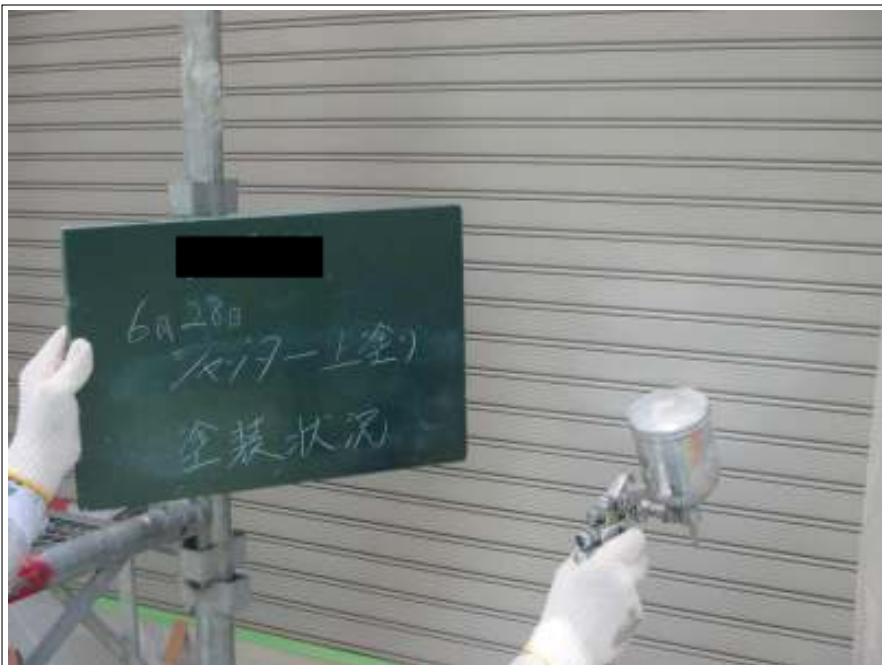
シャッター 上塗り施工中
