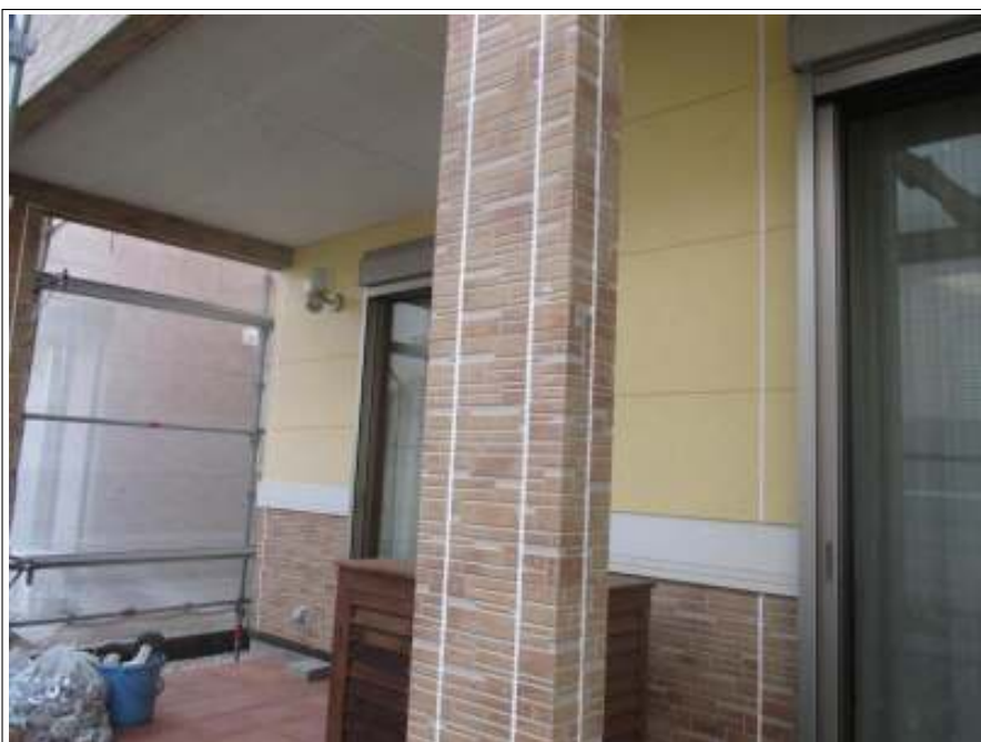
外壁 シーリング打ち替え施工完了
