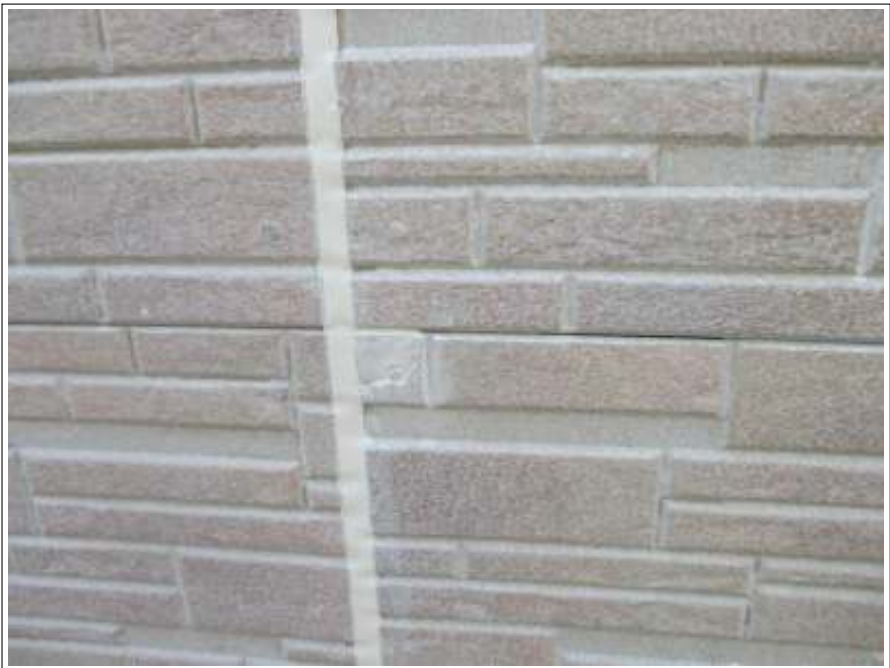
外壁 パテ補修施工完了
