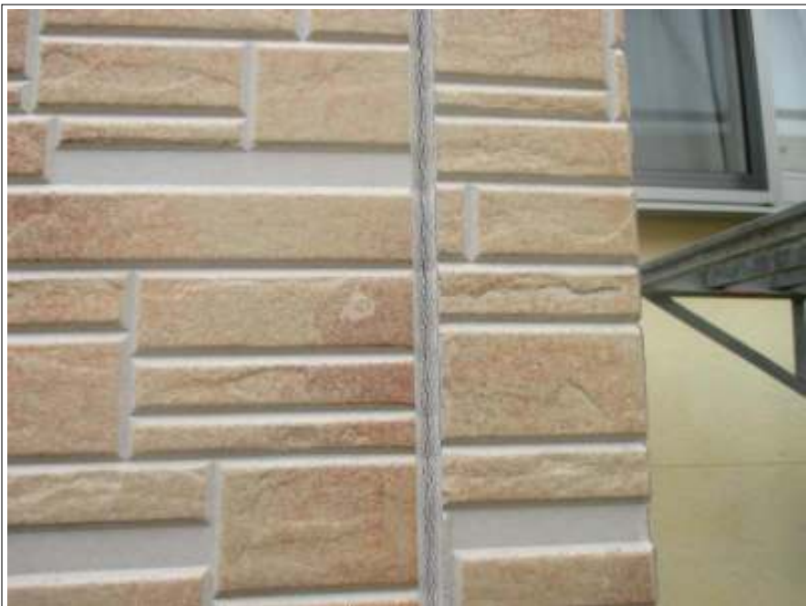
外壁 シーリング打ち替え施工前
