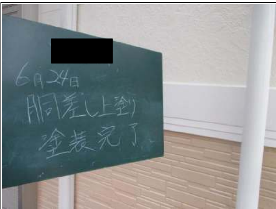
胴差し 上塗り施工完了
