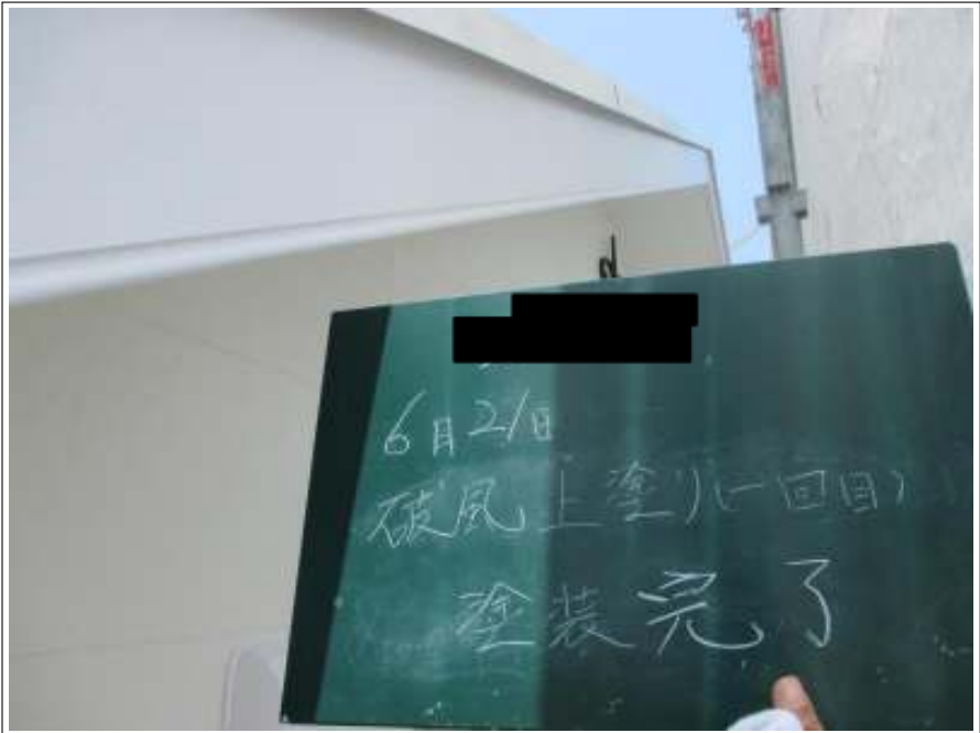
破風板 上塗り施工完了(1回目)
