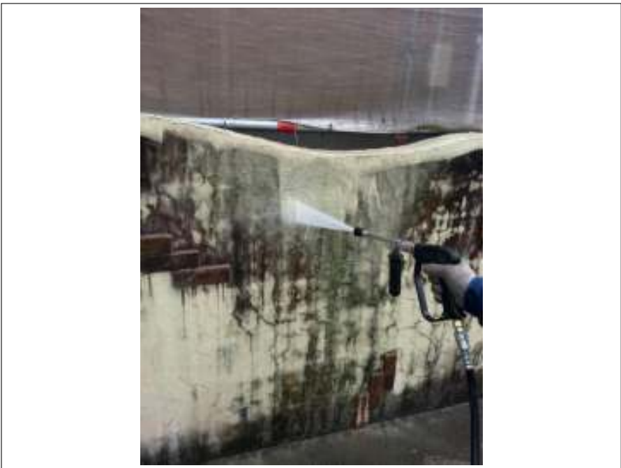
塀 高圧洗浄中
