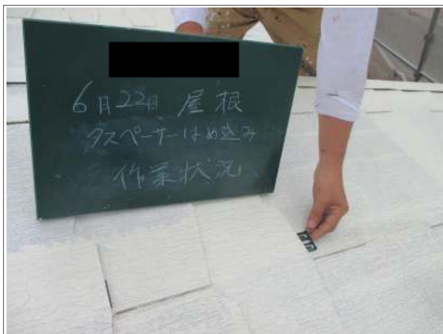
屋根 タスペーサー施工中
