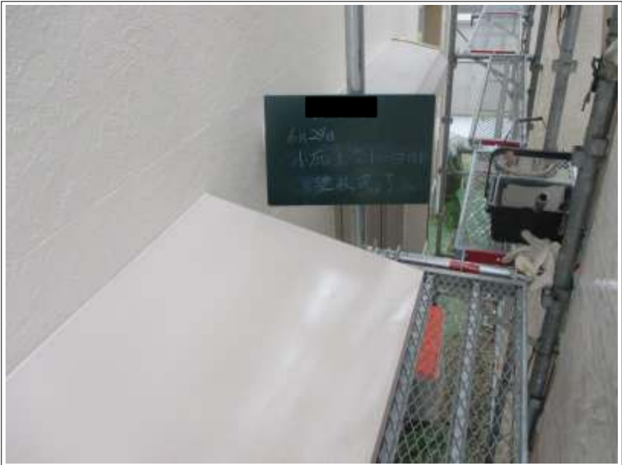
小庇 上塗り施工完了(1回目)
