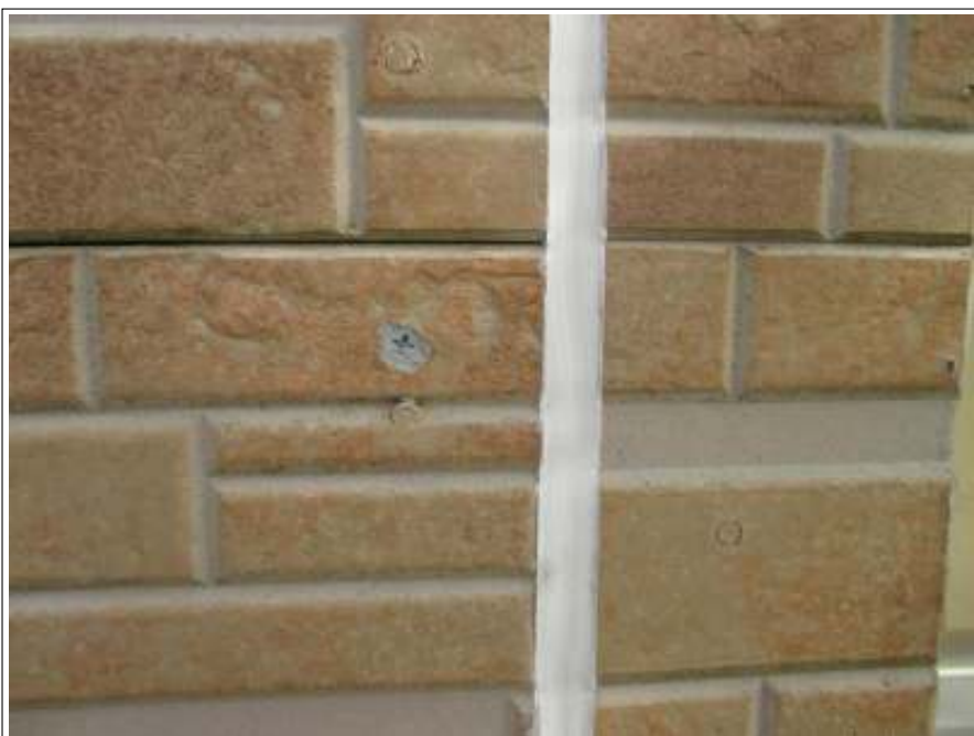
外壁 シーリング打ち替え施工完了
