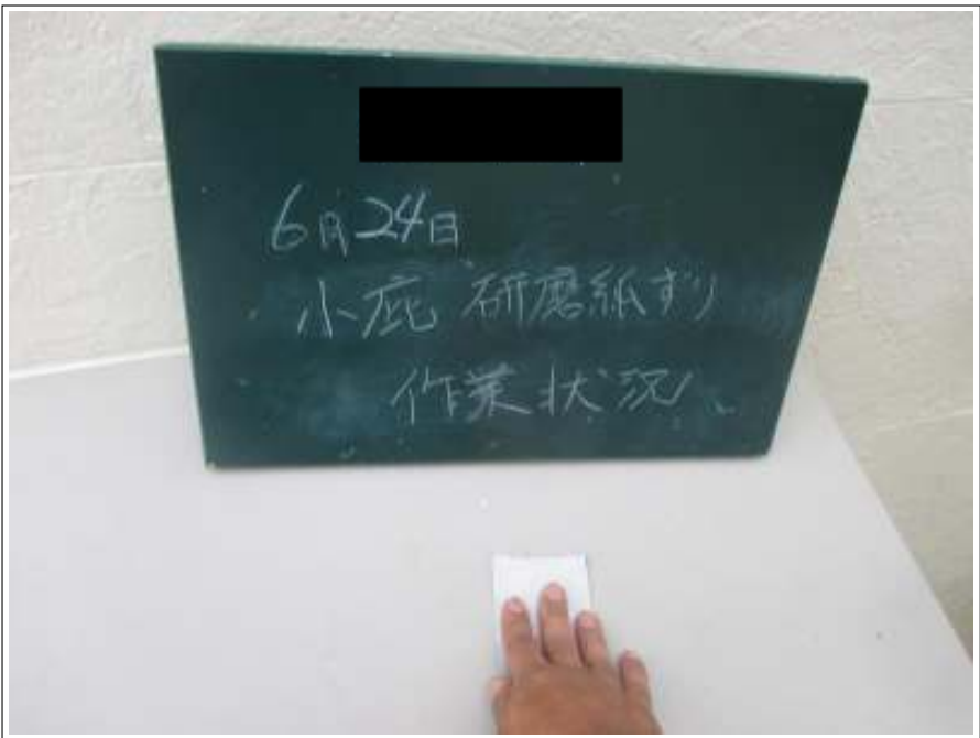
小庇 研磨紙すり施工中
