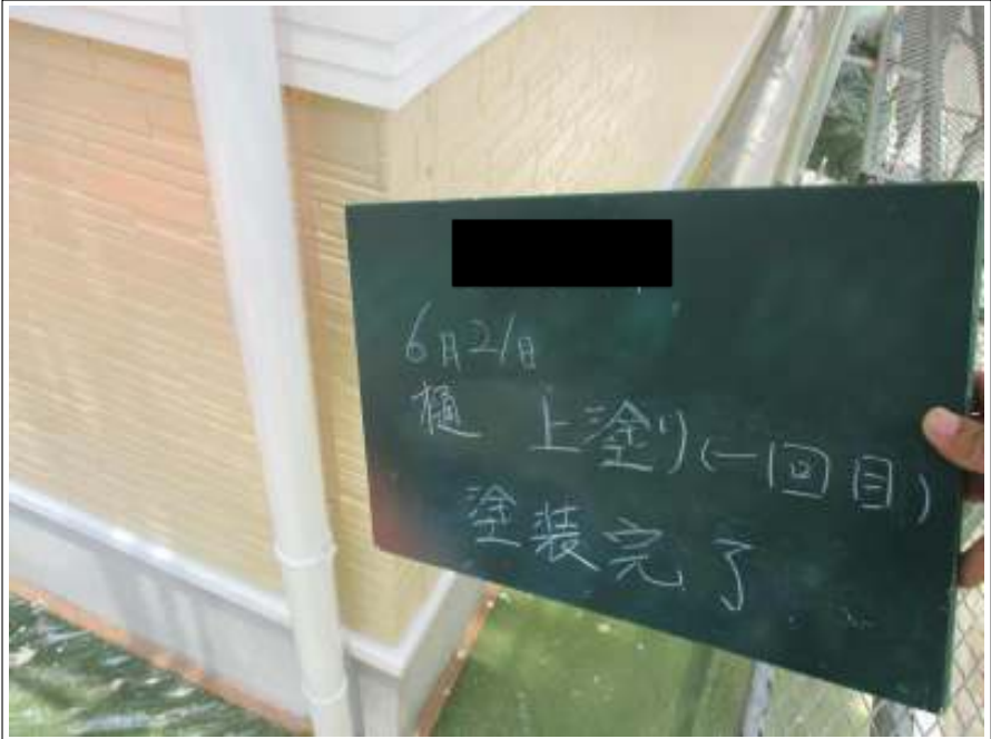
樋 上塗り施工完了(1回目)
