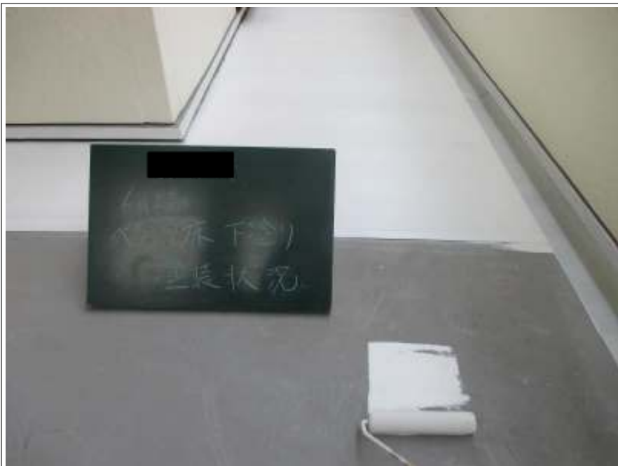
ベランダ床 下塗り施工中
