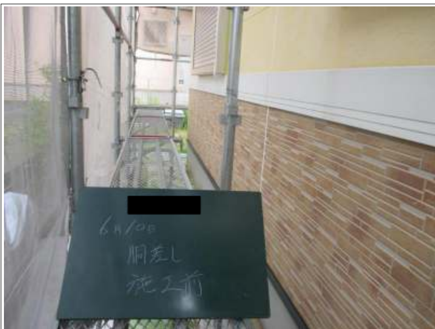
胴差し 施工前
