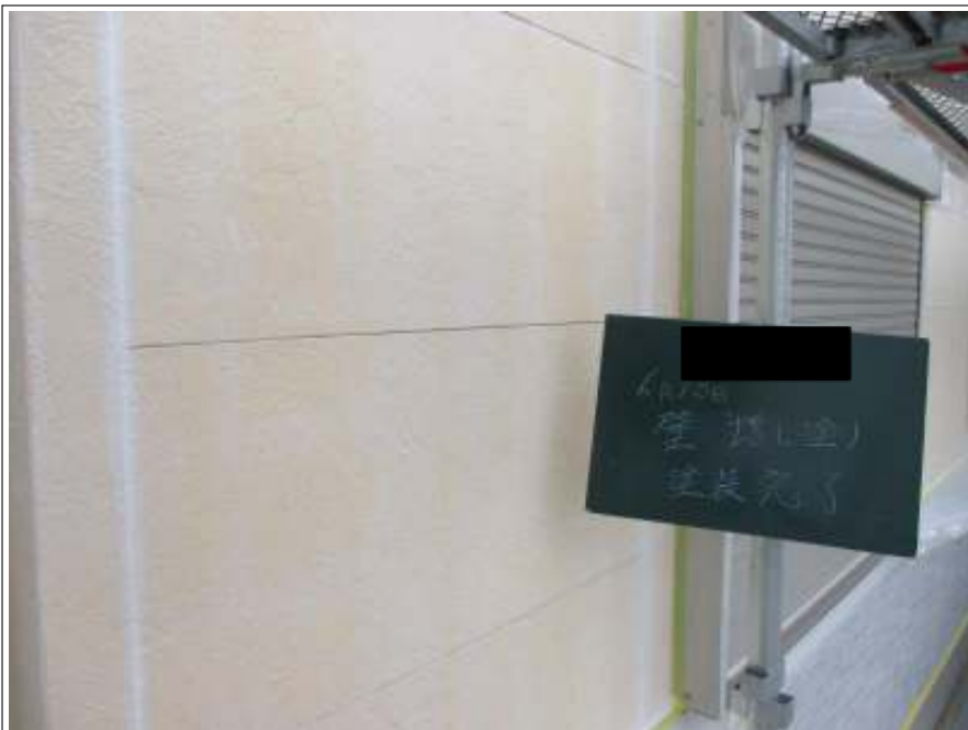
外壁 目地部増し塗り施工完了
