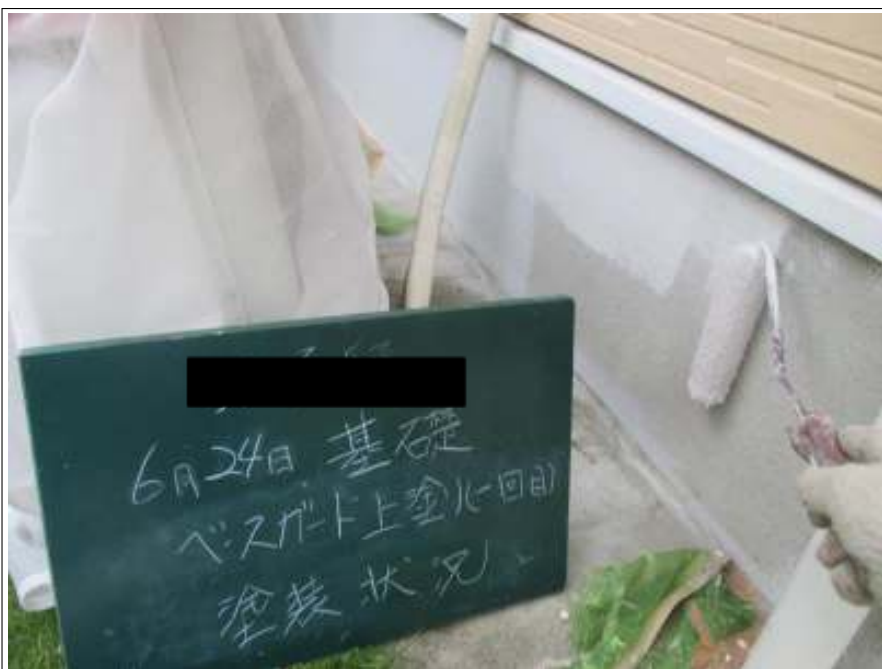
基礎 上塗り施工中(1回目)
