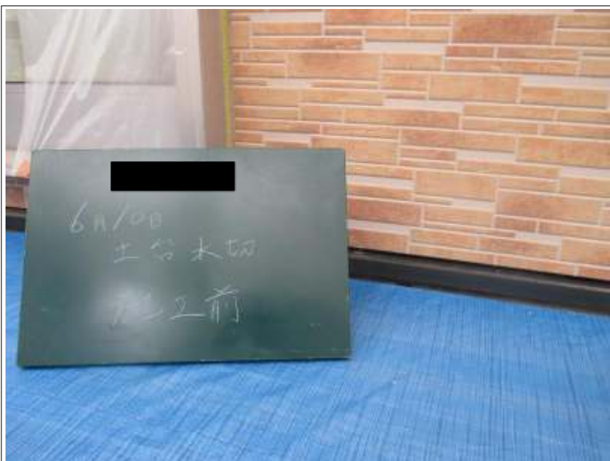
土台水切り 施工前
