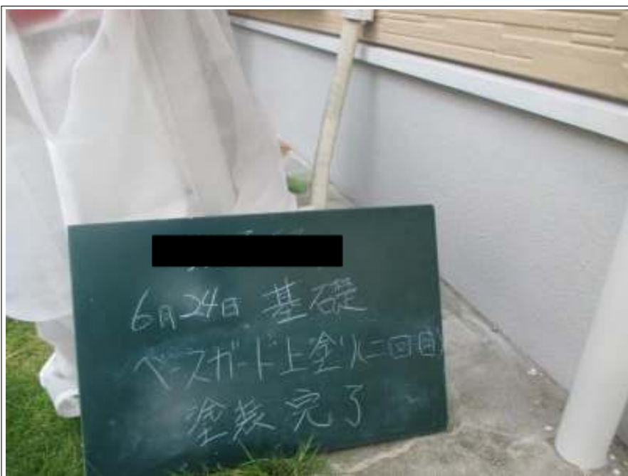
基礎 上塗り施工完了(2回目)
