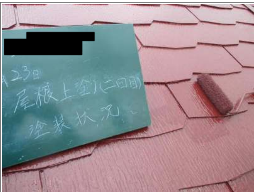
屋根 上塗り施工中
