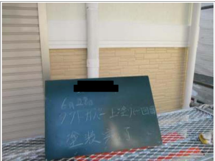
ダクトカバー 上塗り施工完了(1回目)
