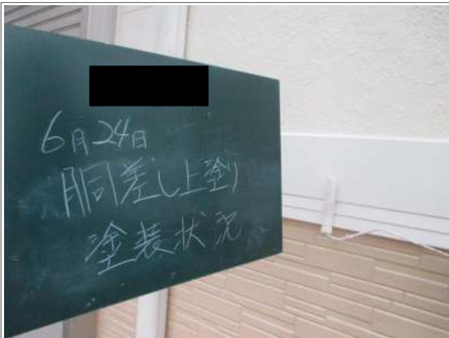
胴差し 上塗り施工中
