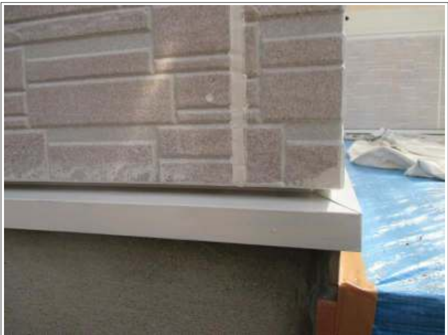
外壁 シーリング打ち替え施工完了
