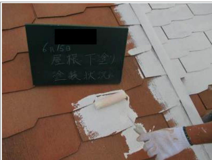
屋根 下塗り施工中
