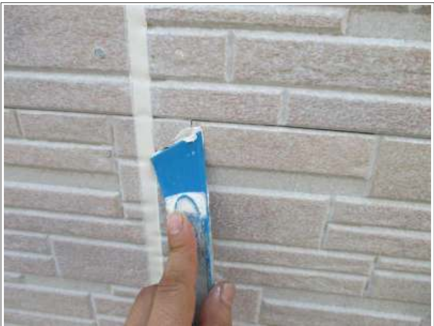
外壁 パテ補修施工中
