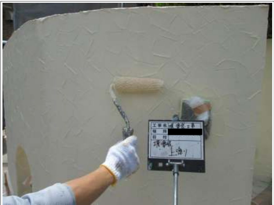
塀 上塗り施工中
