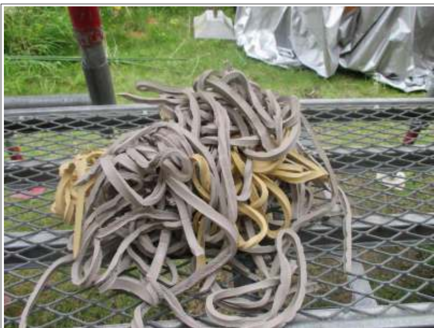
外壁 シーリング撤去完了
