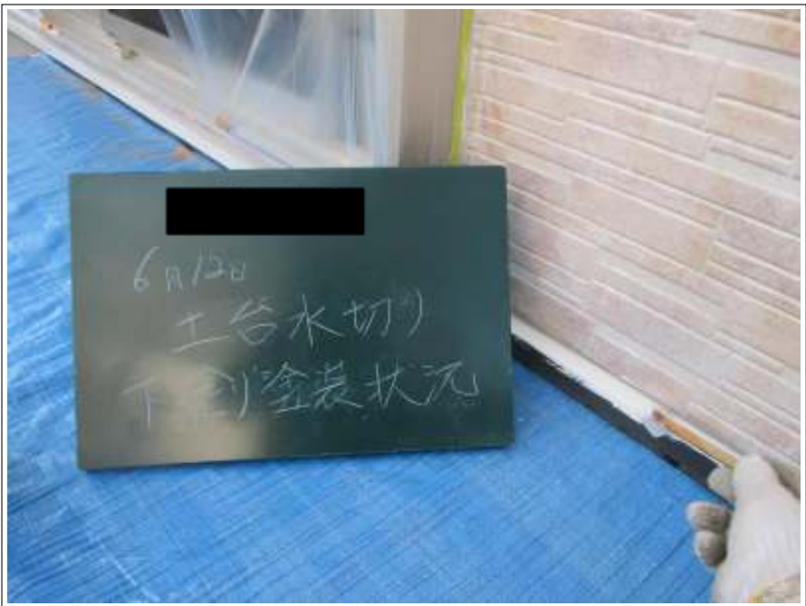
土台水切り 下塗り施工中
