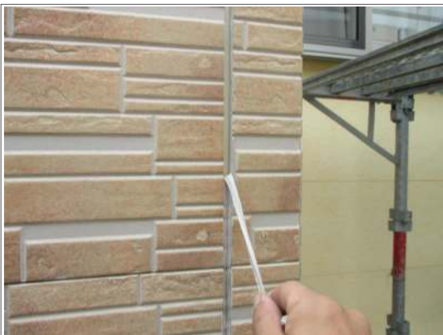
外壁 シーリング撤去施工中
