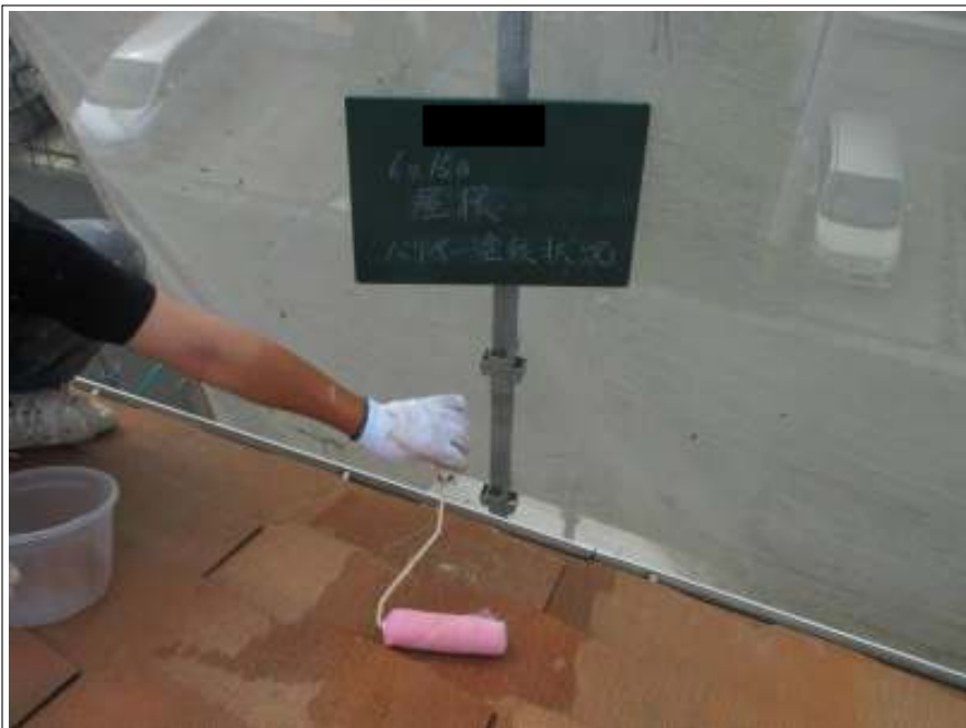
屋根 バリヤー施工中
