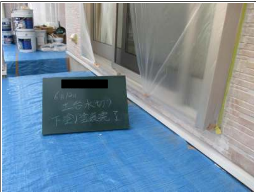
土台水切り 下塗り施工完了
