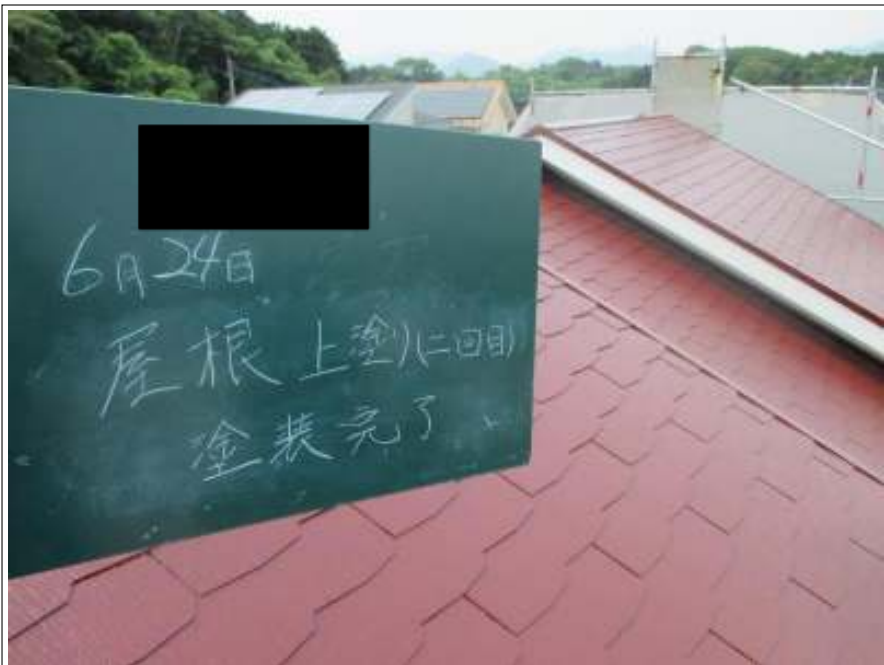
屋根 上塗り施工完了
