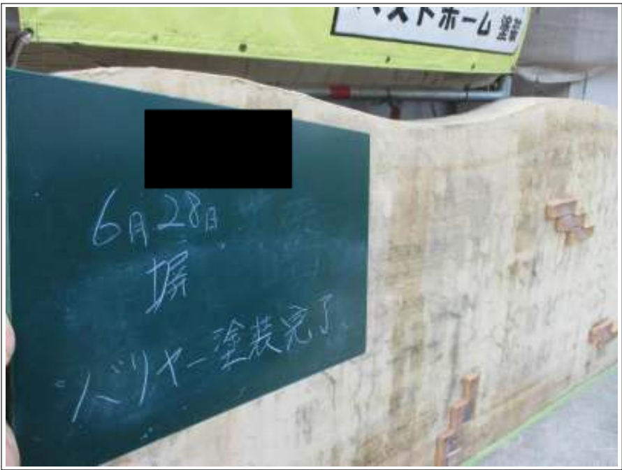
塀 バリヤー施工完了
