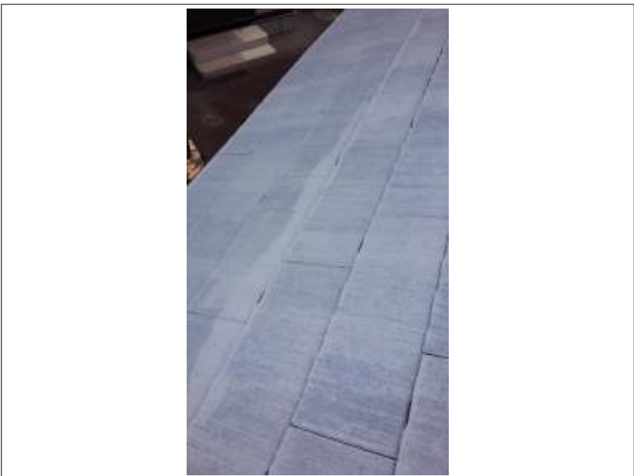
屋根 タスペーサー取付施工後
