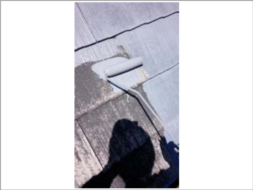
屋根 下塗り施工中
