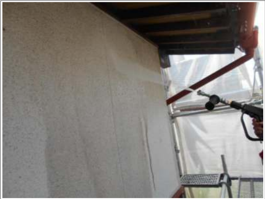
外壁 高压洗净中
