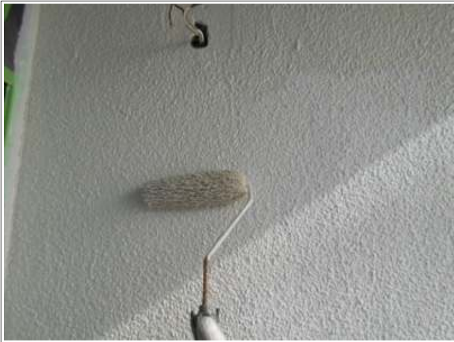
外壁 中塗り施工中
