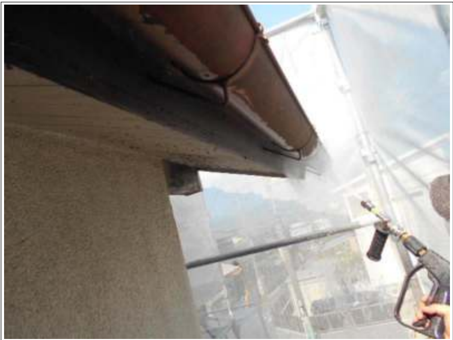
軒天 高压洗净中
