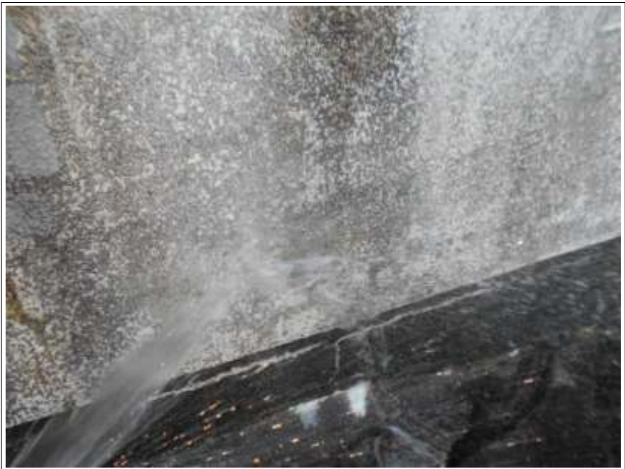
外壁 高压洗净中
