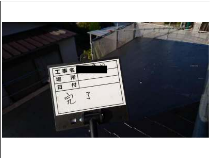
屋根 施工完了
