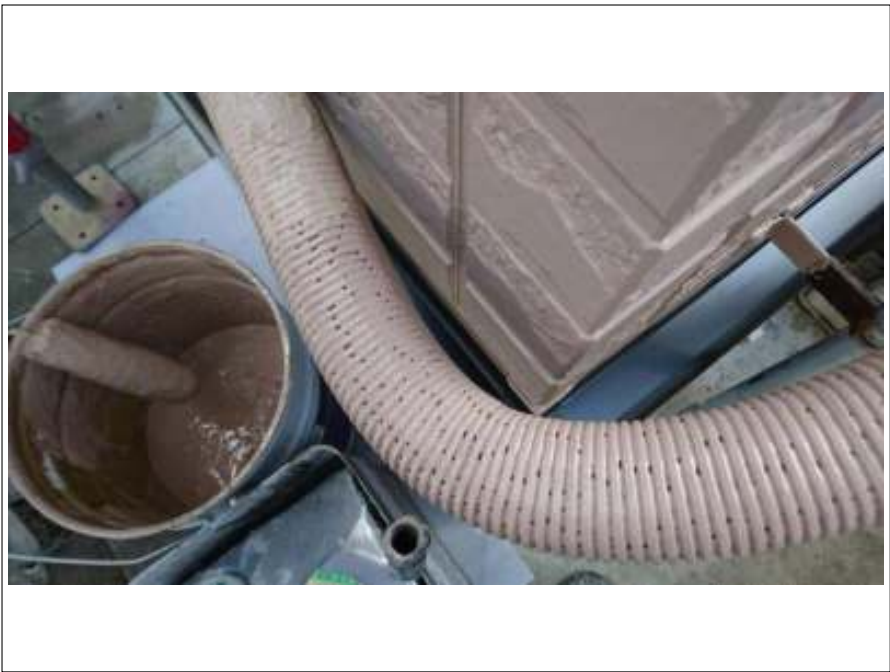
ホース 手直し施工中
