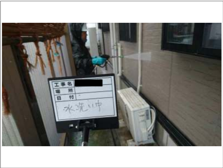
外壁 高圧洗浄中
