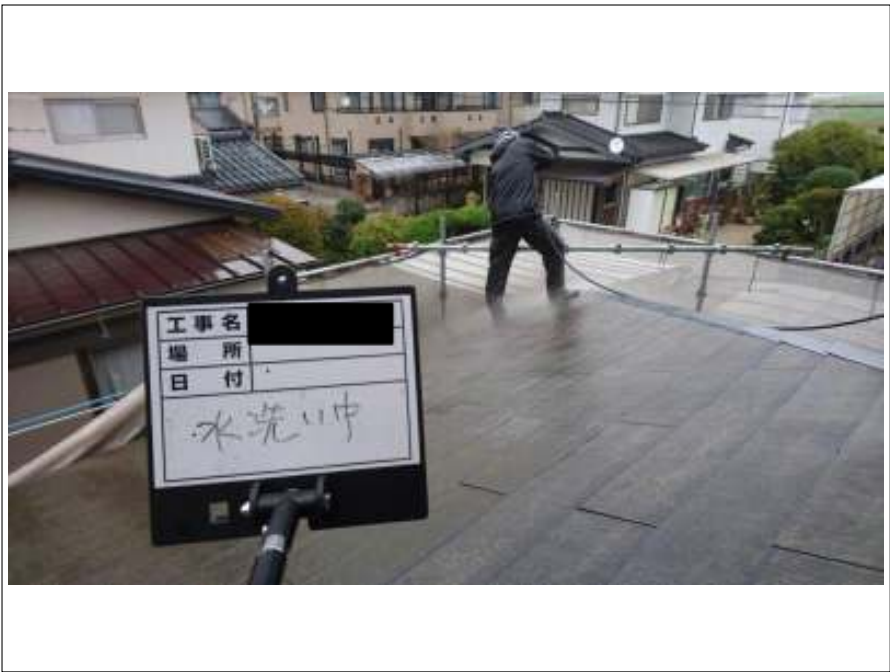
屋根 高圧洗浄中
