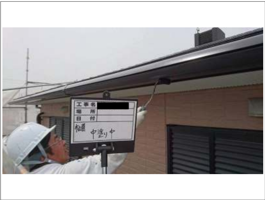
雨樋 中塗り施工中
