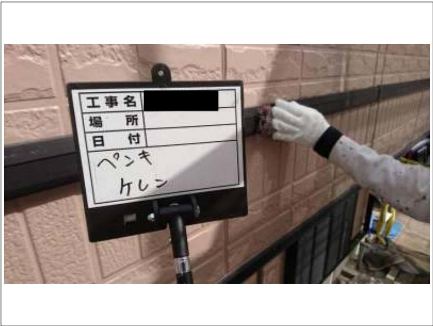
帯 ケレン施工中
