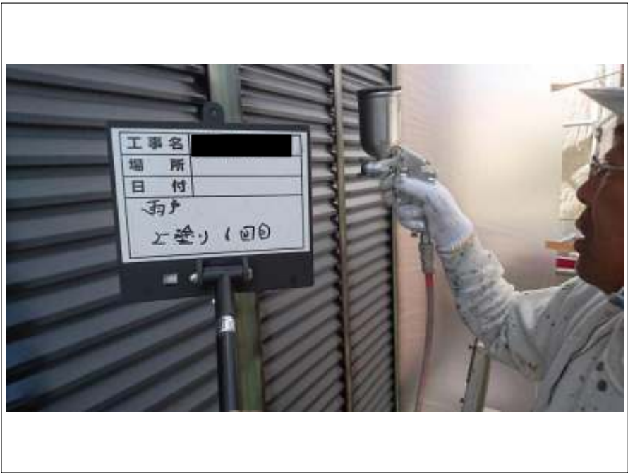
雨戸 上塗り (1回目) 施工中
