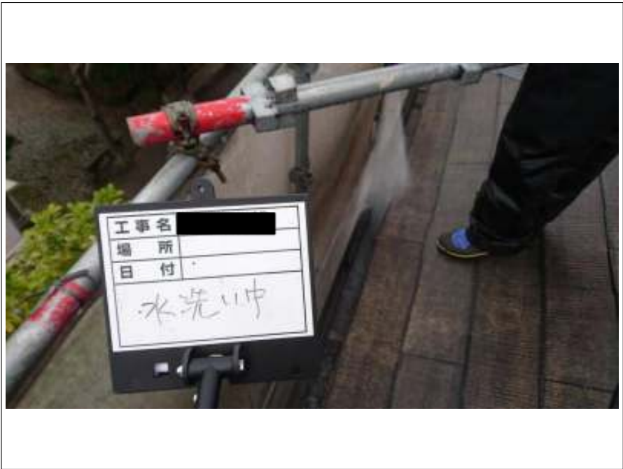
屋根 高圧洗浄中
