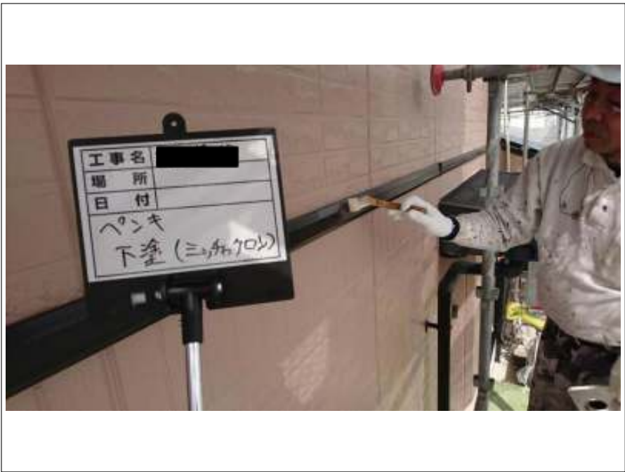
帯 下塗り施工中
