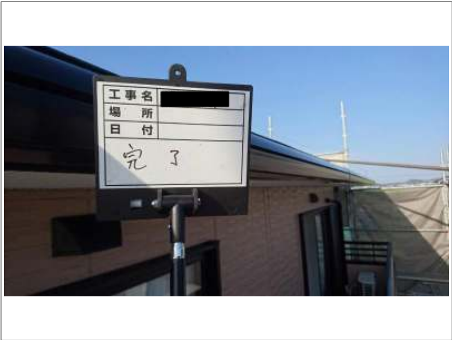
破風板・樋 施工完了
