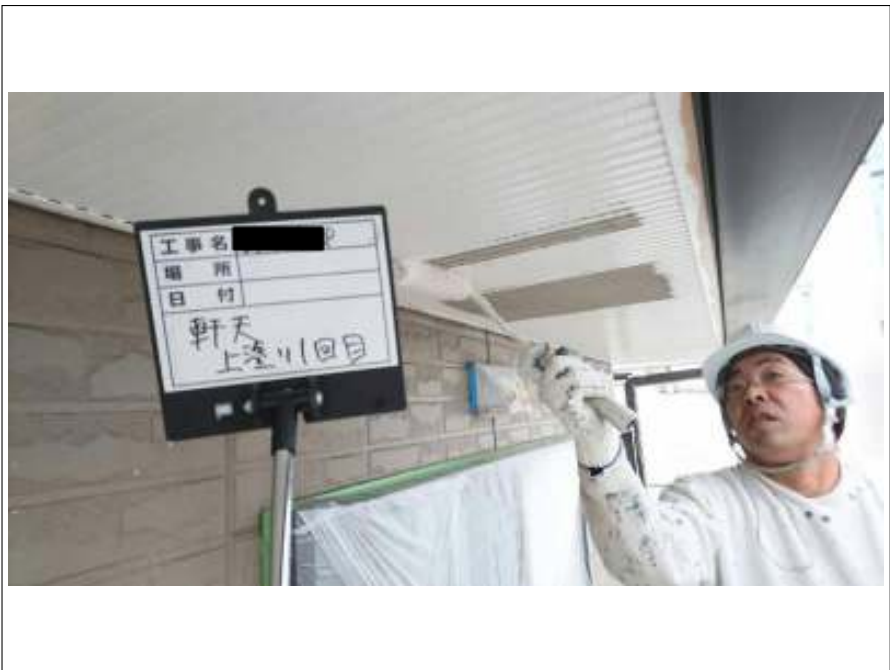
軒天 上塗り（1回目）施工中
