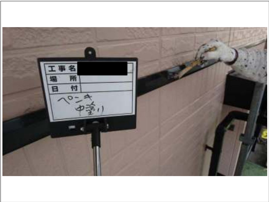
帯 中塗り施工中
