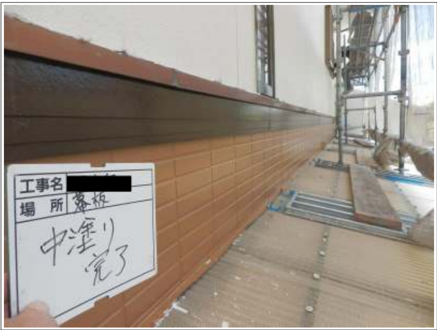
帯 中塗り施工完了
