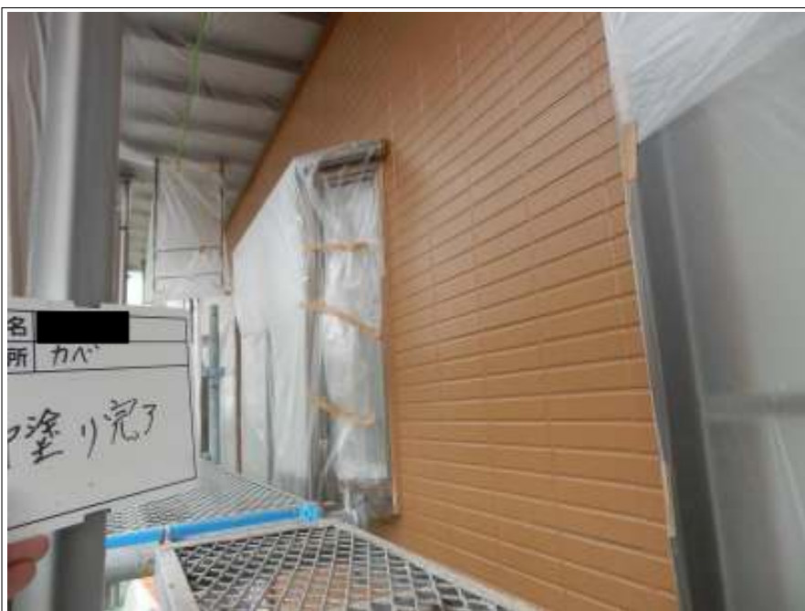
外壁（1階） 中塗り施工完了
