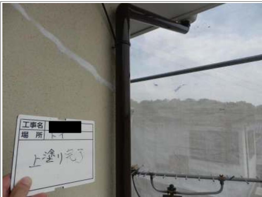
雨樋 上塗り施工完了
