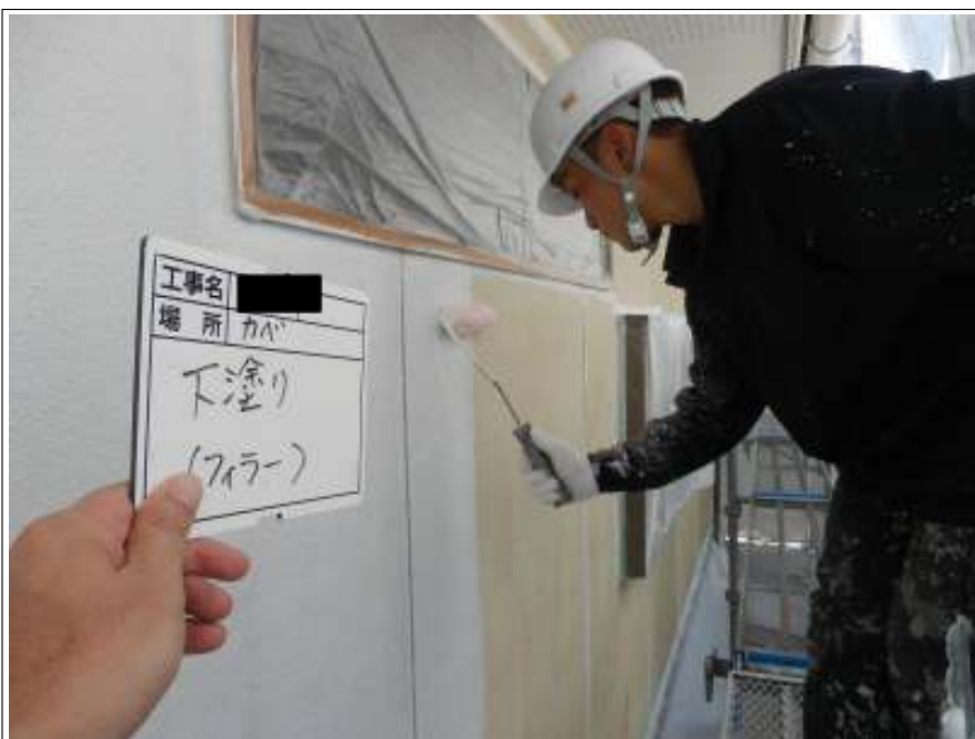
外壁（2階） 下塗り施工中
