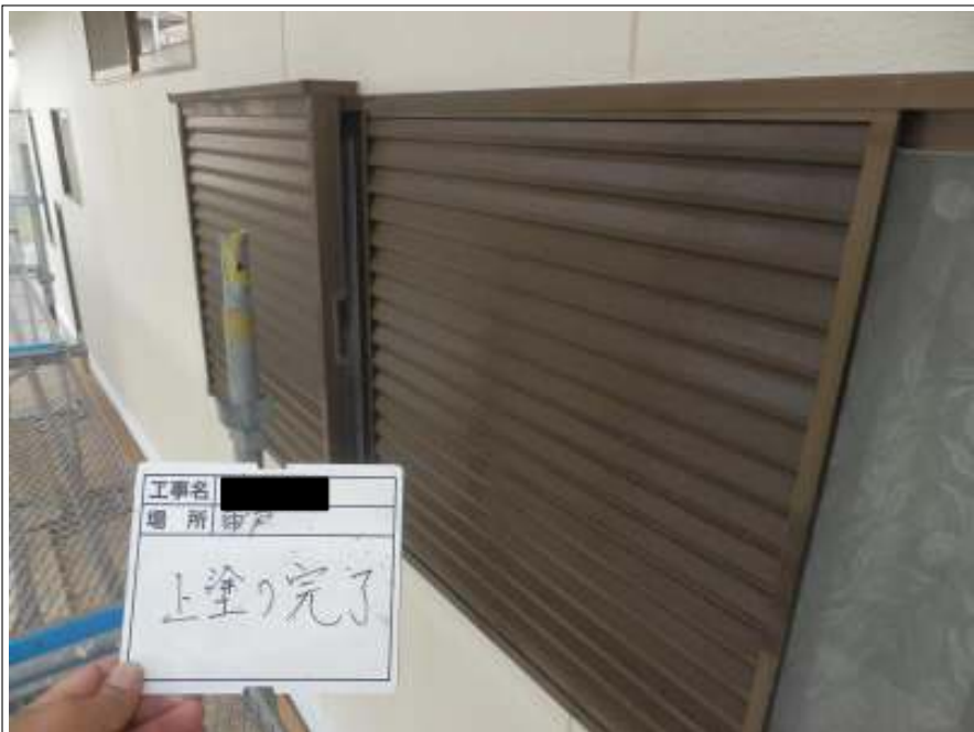
雨戸 上塗り施工完了
