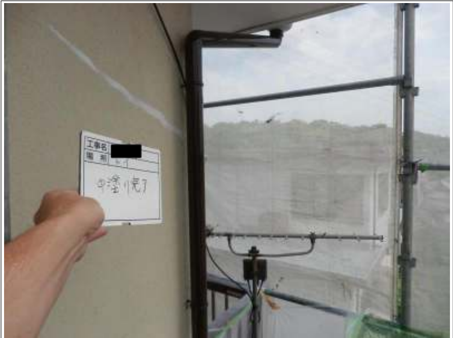
雨樋 中塗り施工完了
