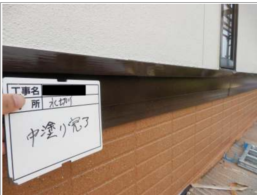
水切り 中塗り施工完了
