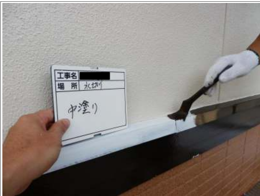
水切り 中塗り施工中
