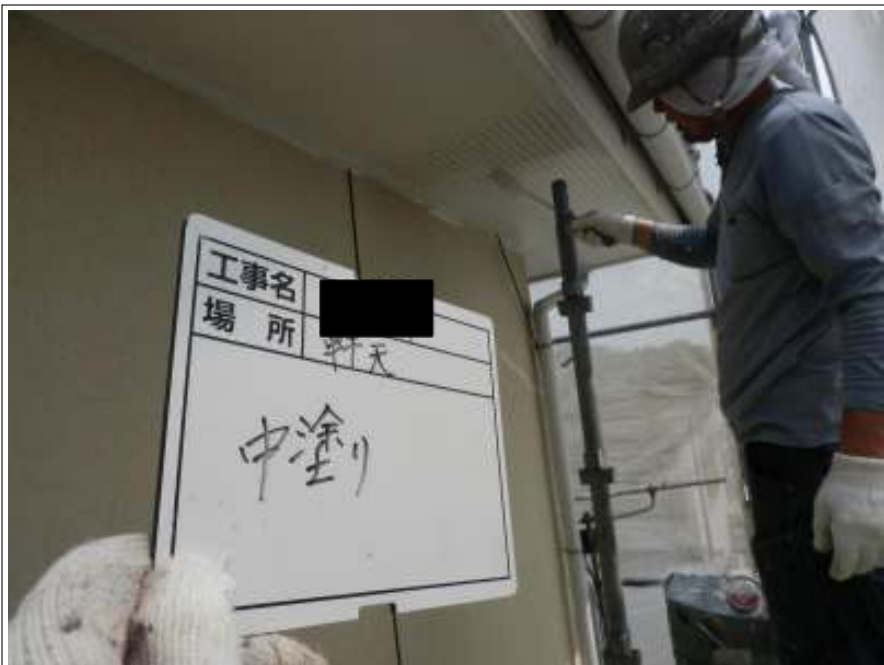
軒天 中塗り施工中
