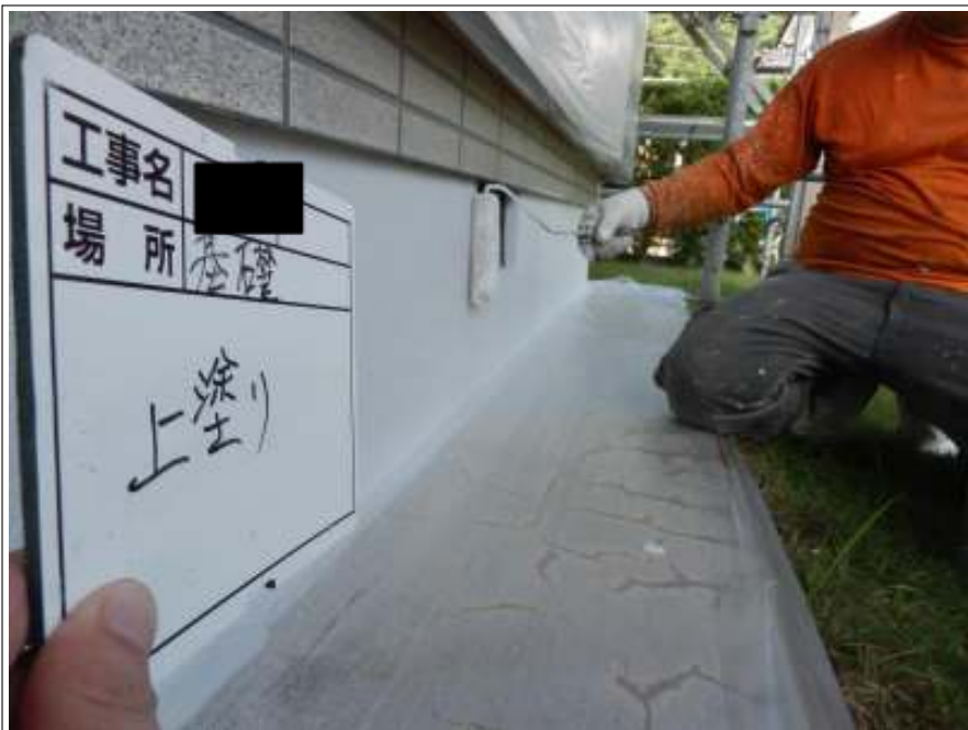
基礎 上塗り施工中
