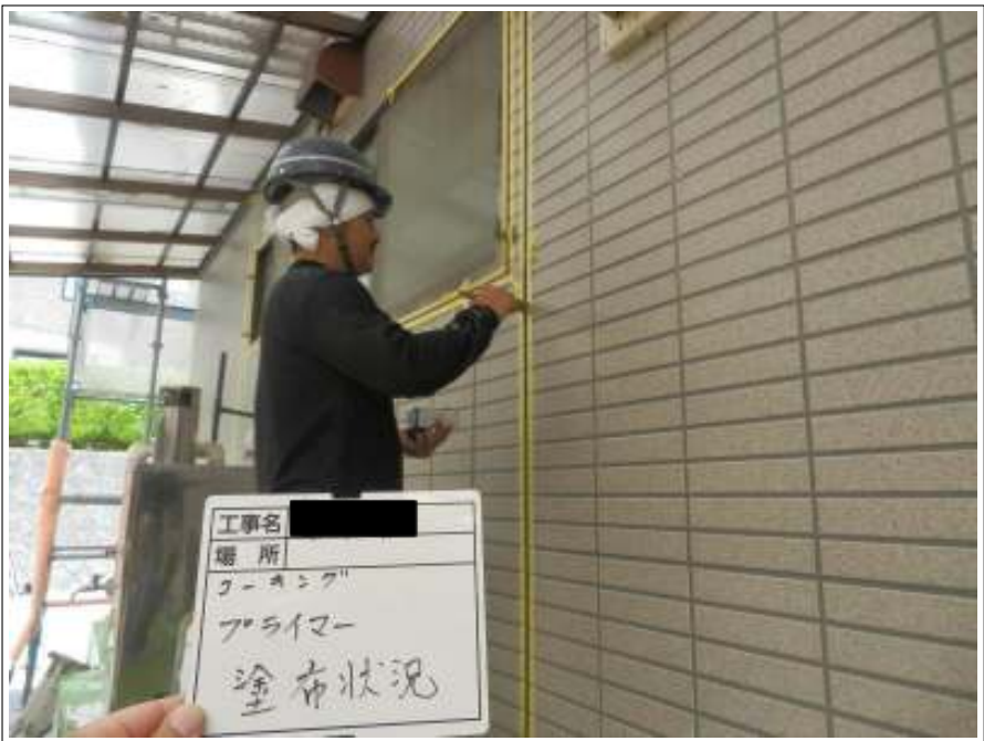
プライマー塗布
