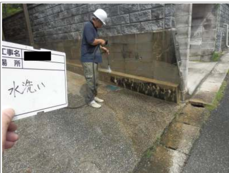
土間 高圧洗浄中
