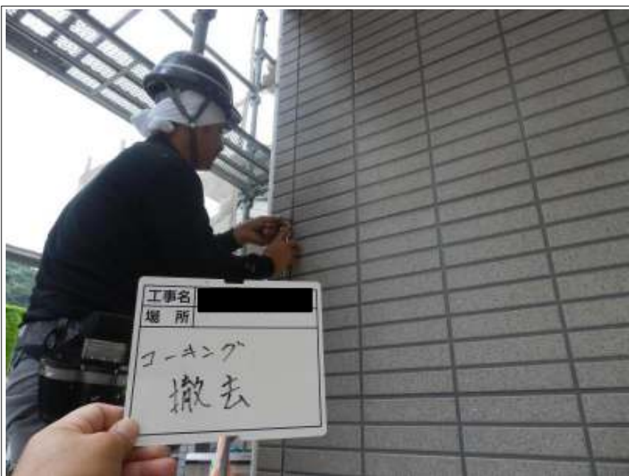
既存シーリング撤去
