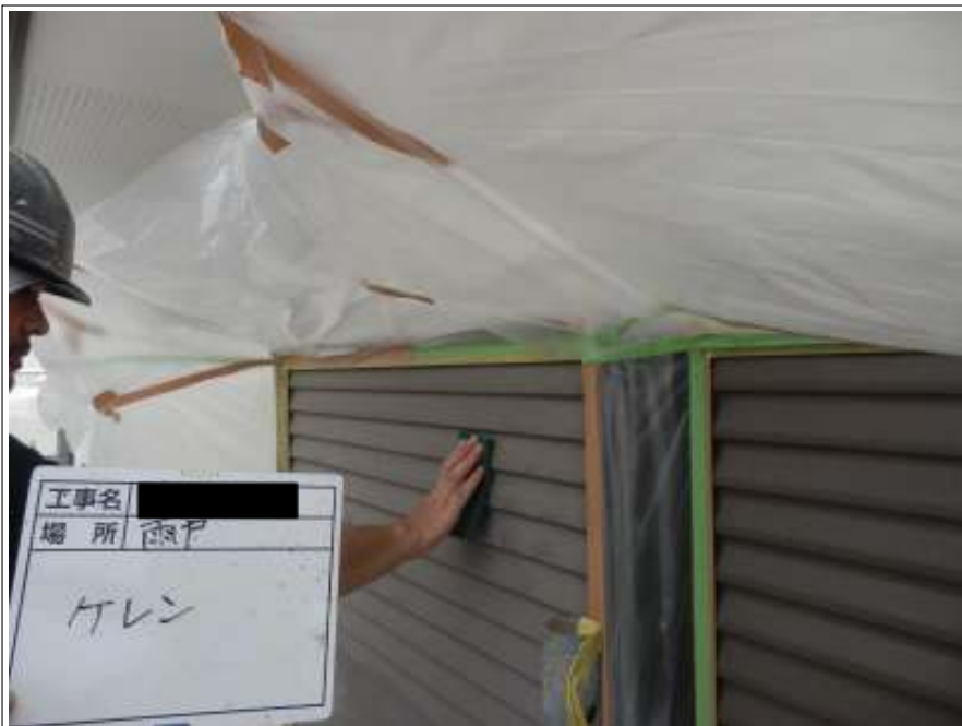
雨戸 ケレン作業
