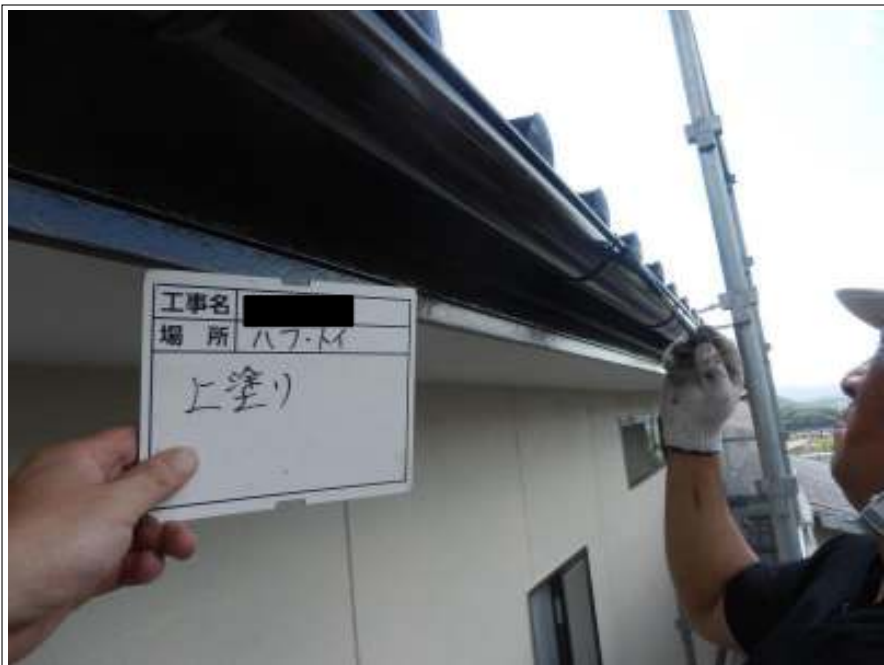
破風板 上塗り施工中
