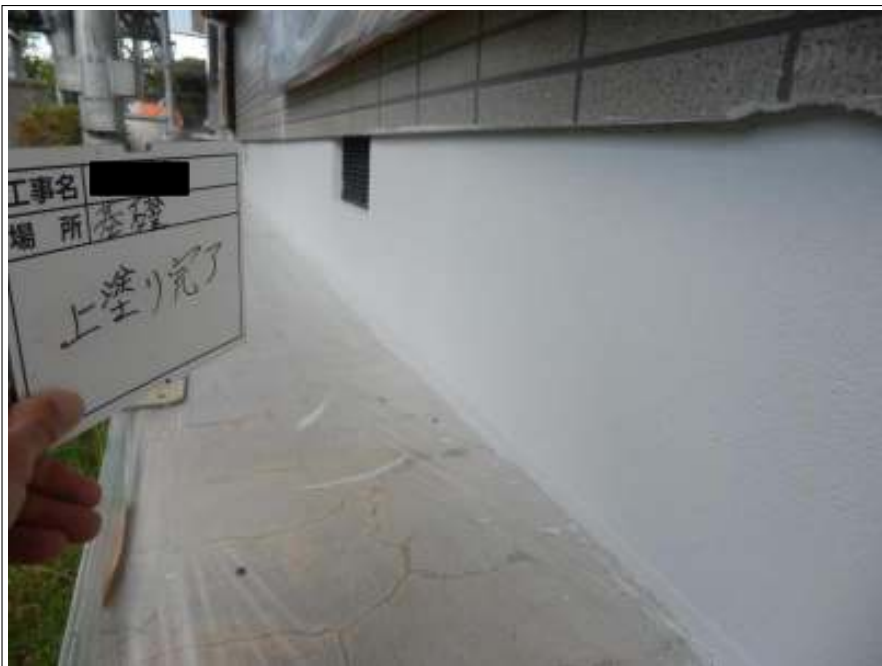
基礎 上塗り施工完了
