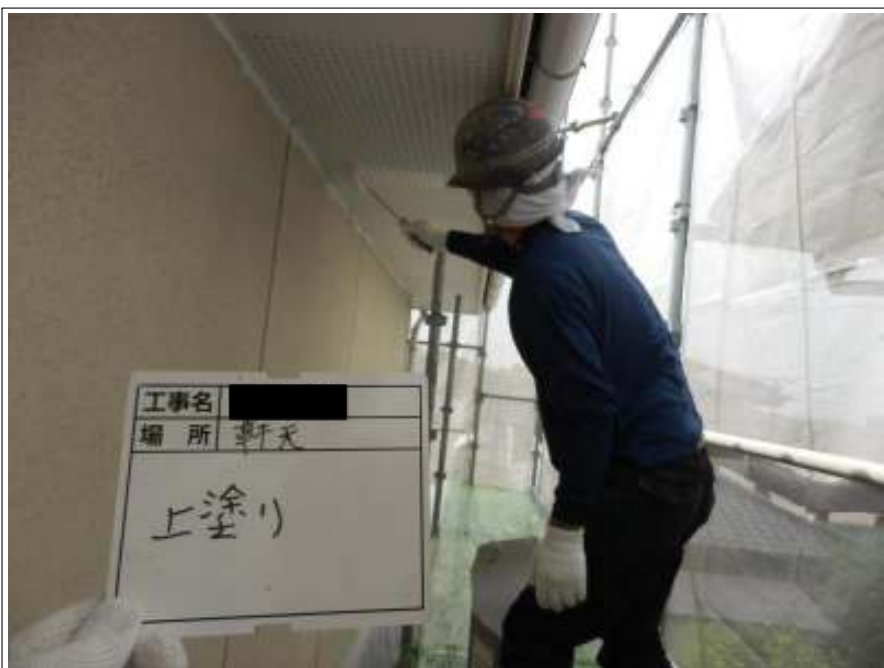
軒天 上塗り施工中
