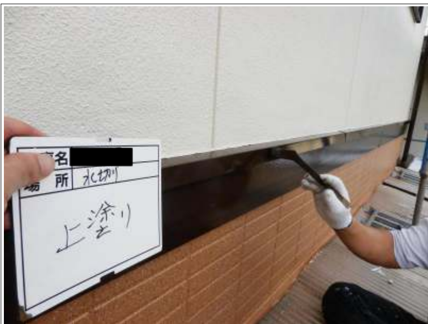
水切り 上塗り施工中
