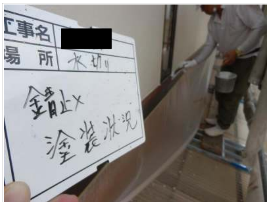
水切り サビ止め施工中
