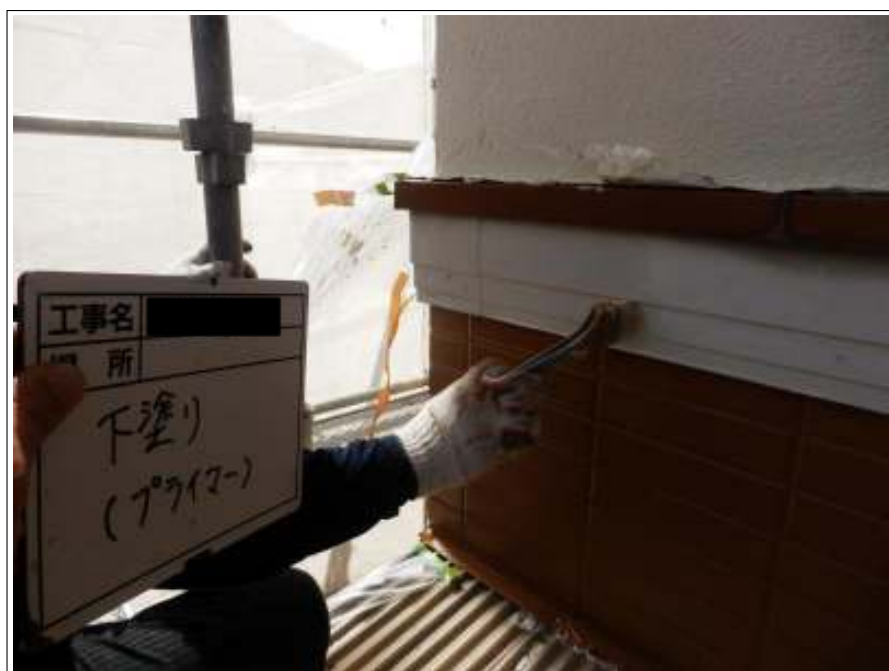
帯 下塗り施工中
