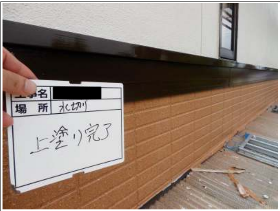
水切り 上塗り施工完了
