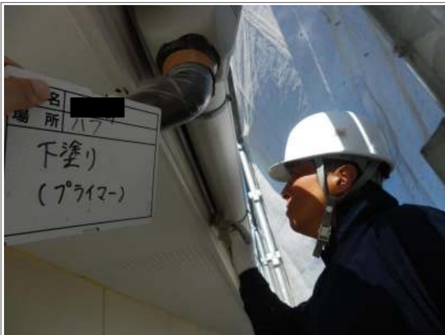
破風板 下塗り施工中
