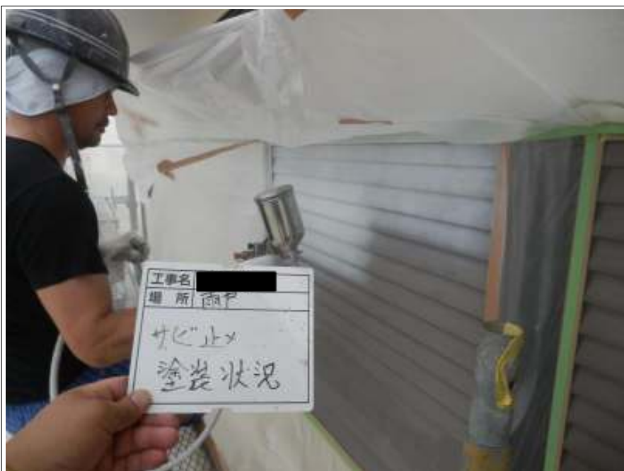
雨戸 サビ止め施工中
