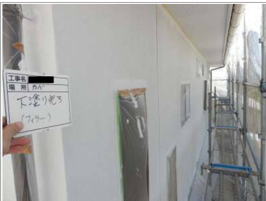
外壁（2階） 下塗り施工完了
