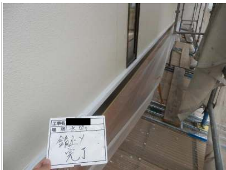
水切り サビ止め施工完了
