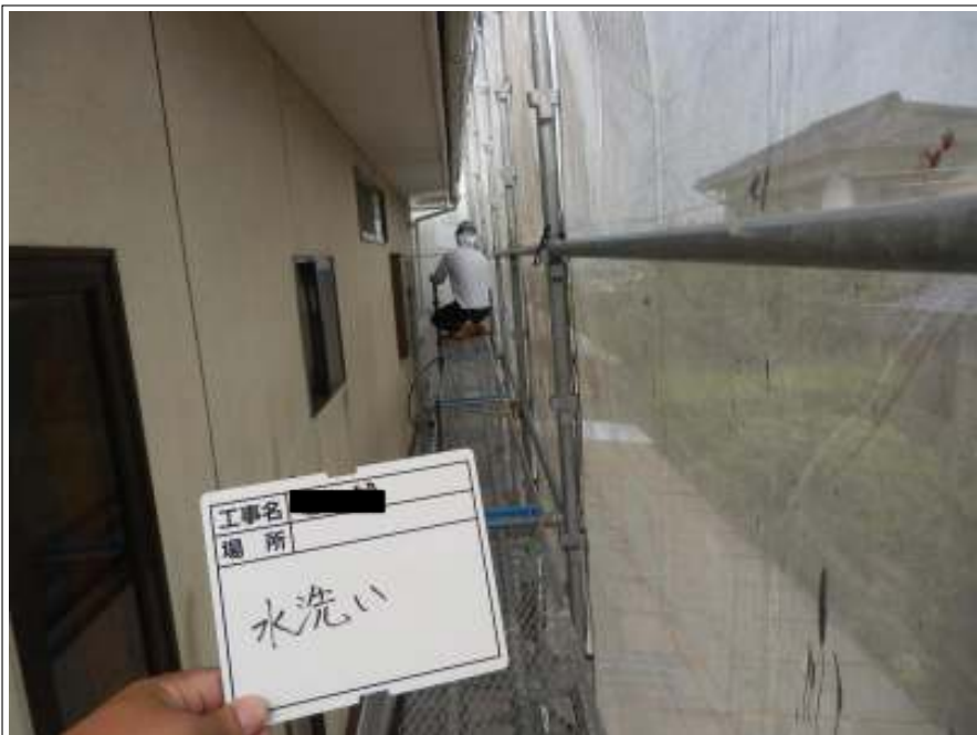
外壁 高圧洗浄中
