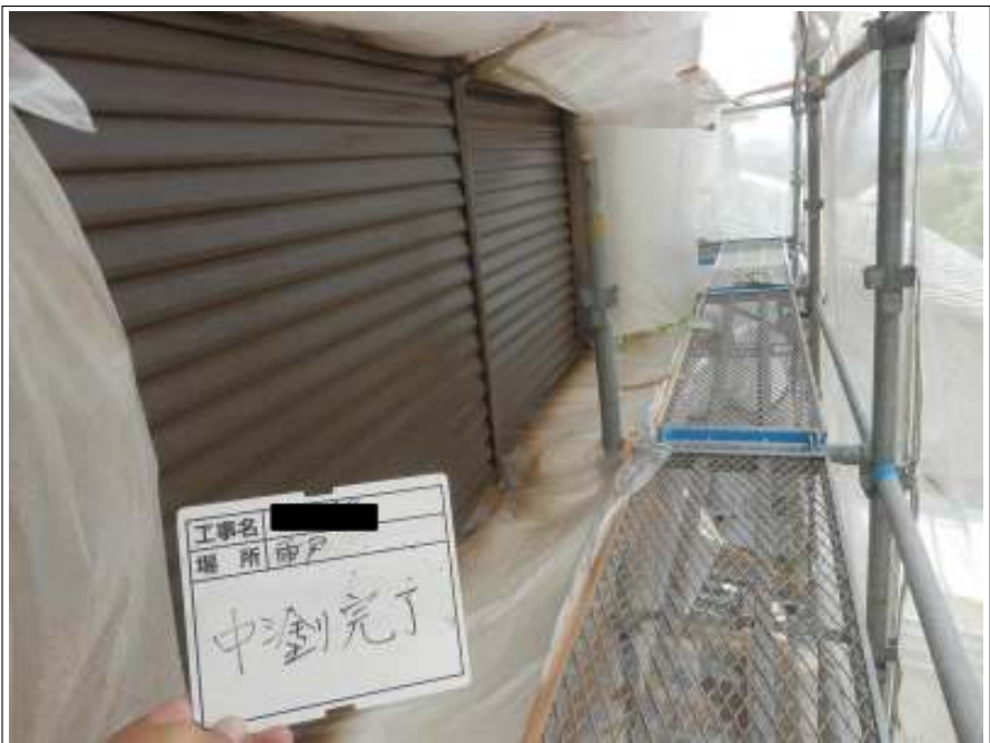
雨戸 中塗り施工完了
