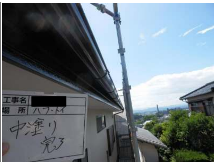
破風板 中塗り施工完了
