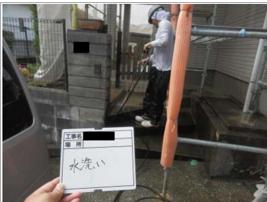
土間 高圧洗浄中
