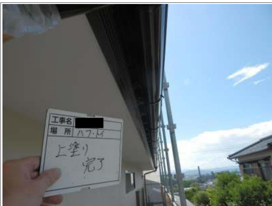
破風板 上塗り施工完了
