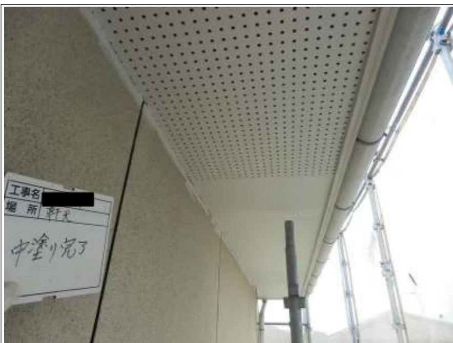
軒天 中塗り施工完了
