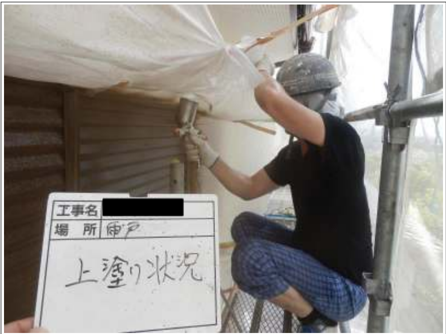
雨戸 上塗り施工中
