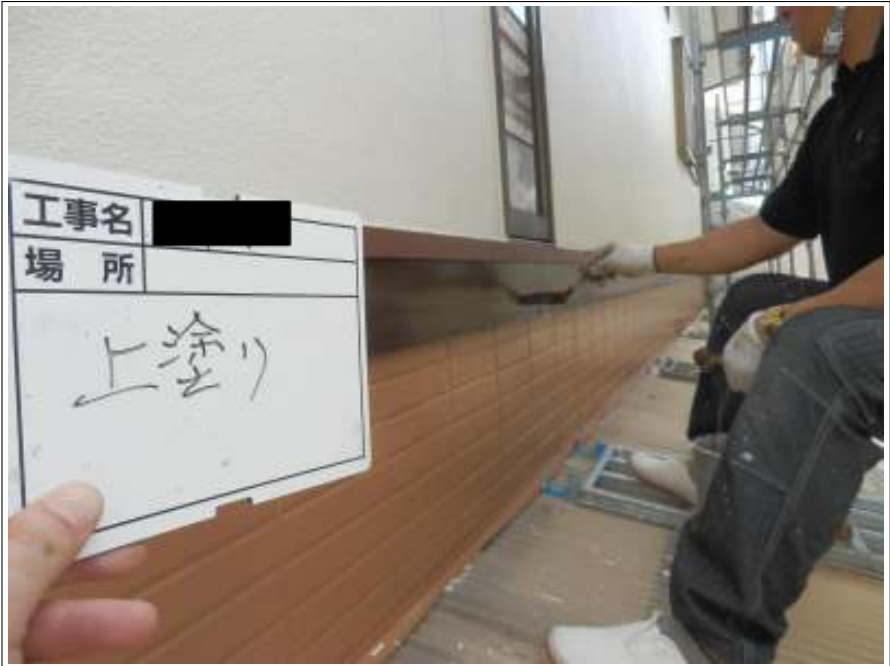
帯 上塗り施工中
