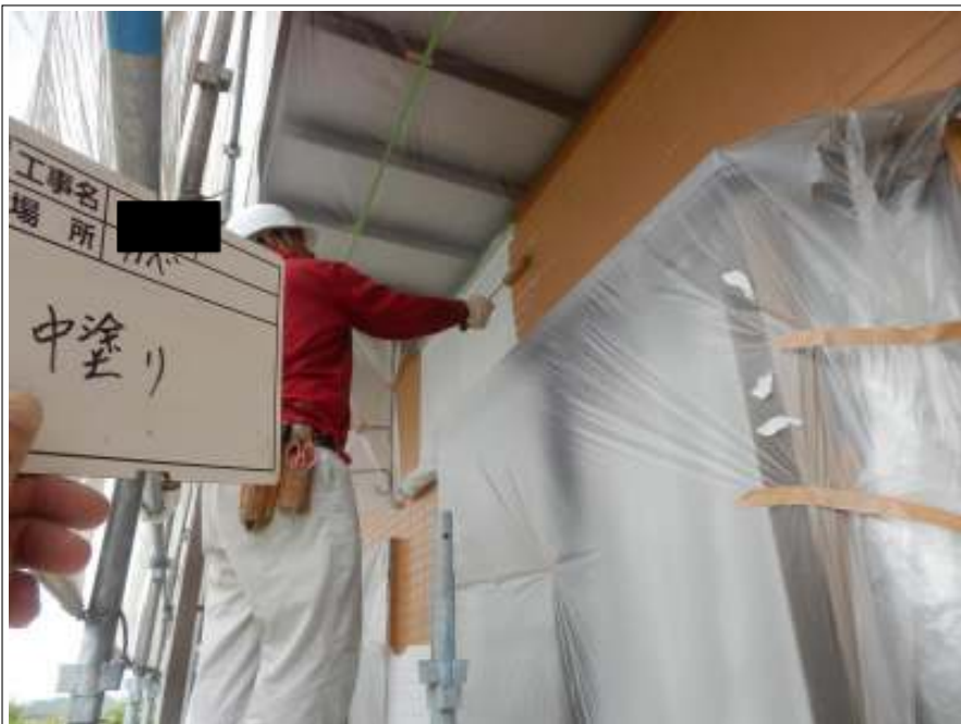
外壁（1階） 中塗り施工中
