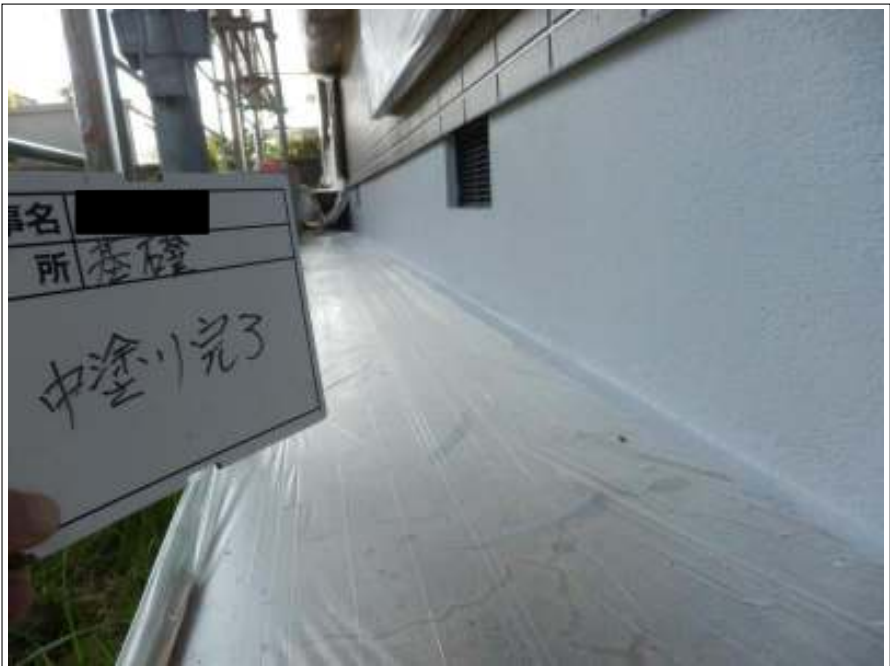
基礎 中塗り施工完了
