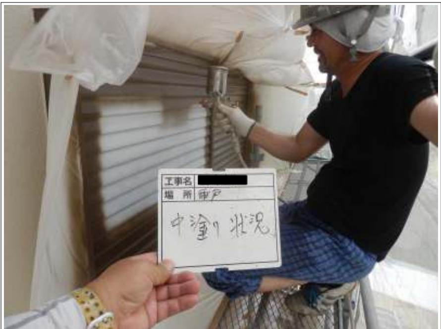
雨戸 中塗り施工中
