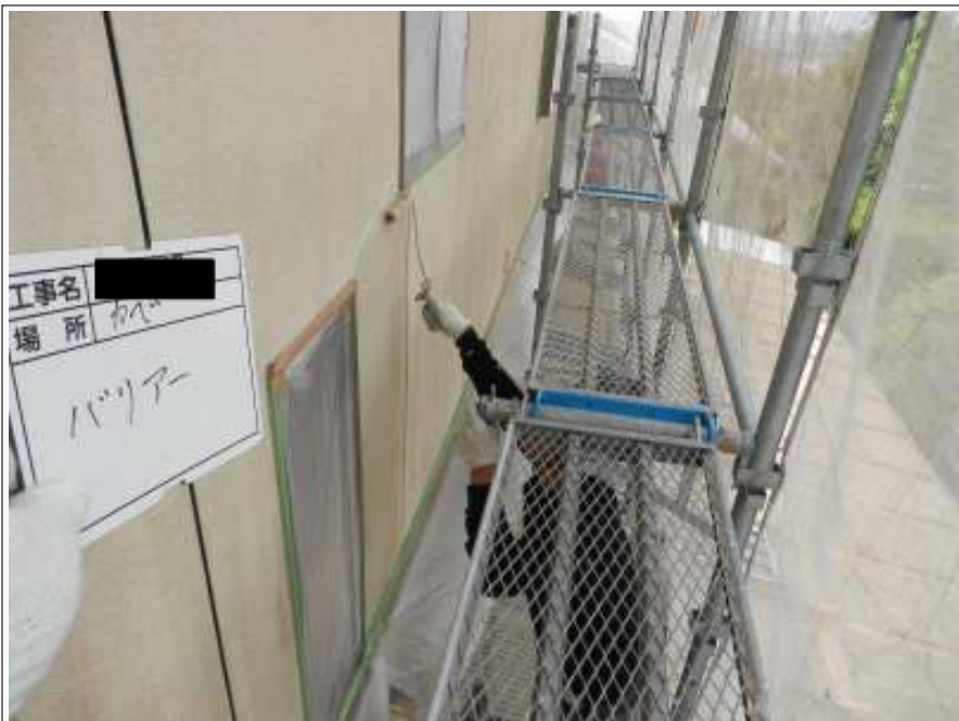
外壁 バリアー塗布
