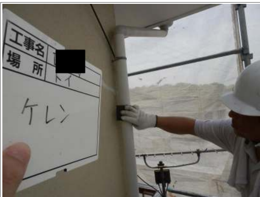
雨樋 ケレン作業
