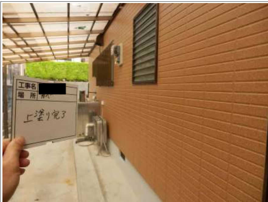
外壁（1階） 上塗り施工完了
