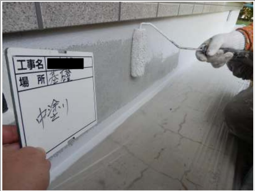
基礎 中塗り施工中
