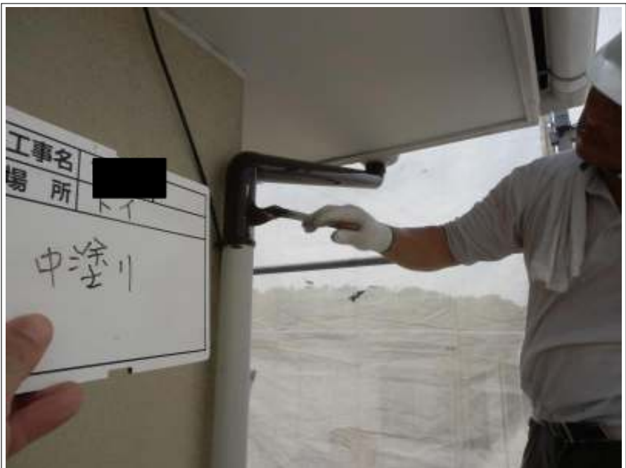
雨樋 中塗り施工中
