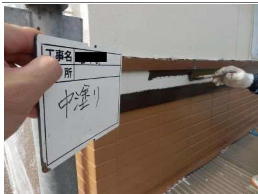
帯 中塗り施工中
