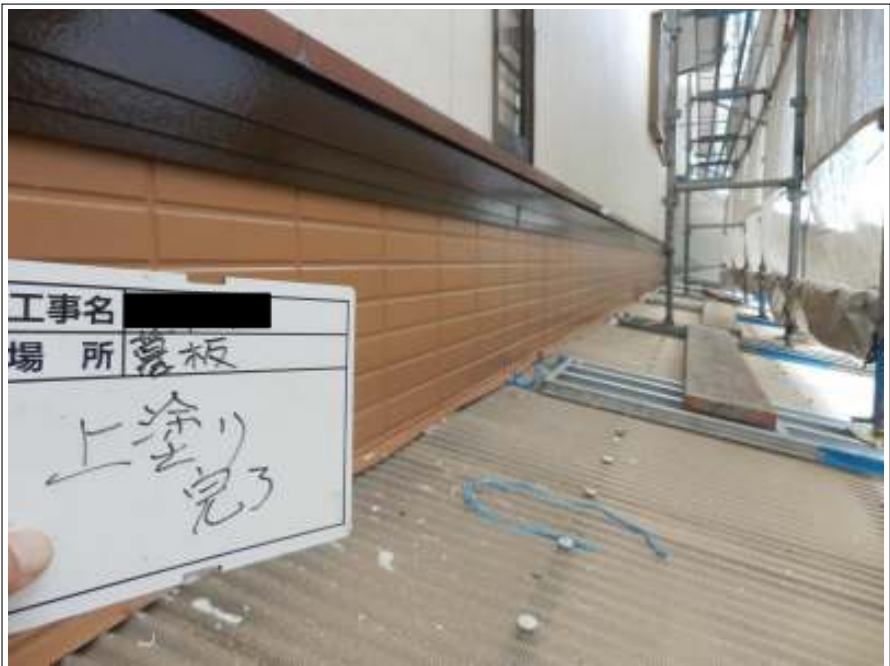
帯 上塗り施工完了
