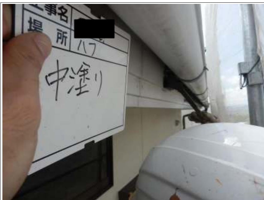
破風板 中塗り施工中
