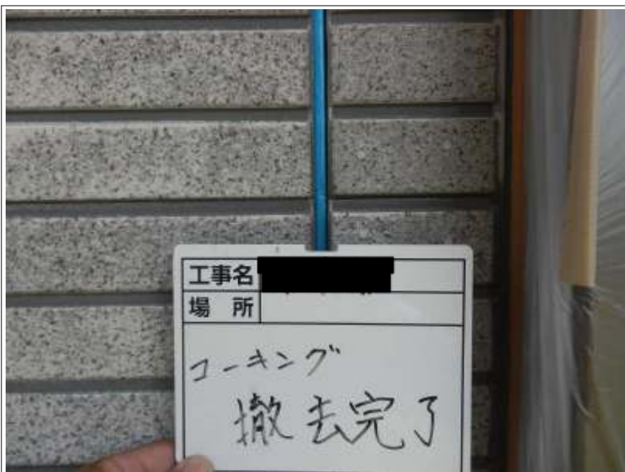
既存シーリング撤去 完了
