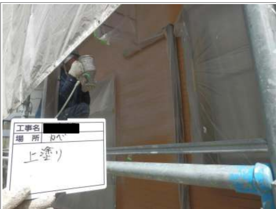
外壁（1階） 上塗り施工中
