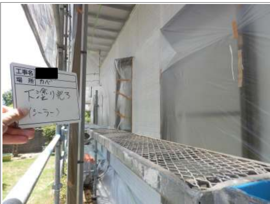
外壁（1階） 下塗り施工完了
