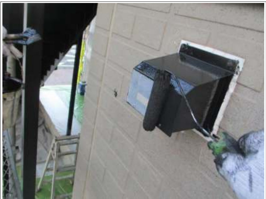
換気フード 上塗り施工中
