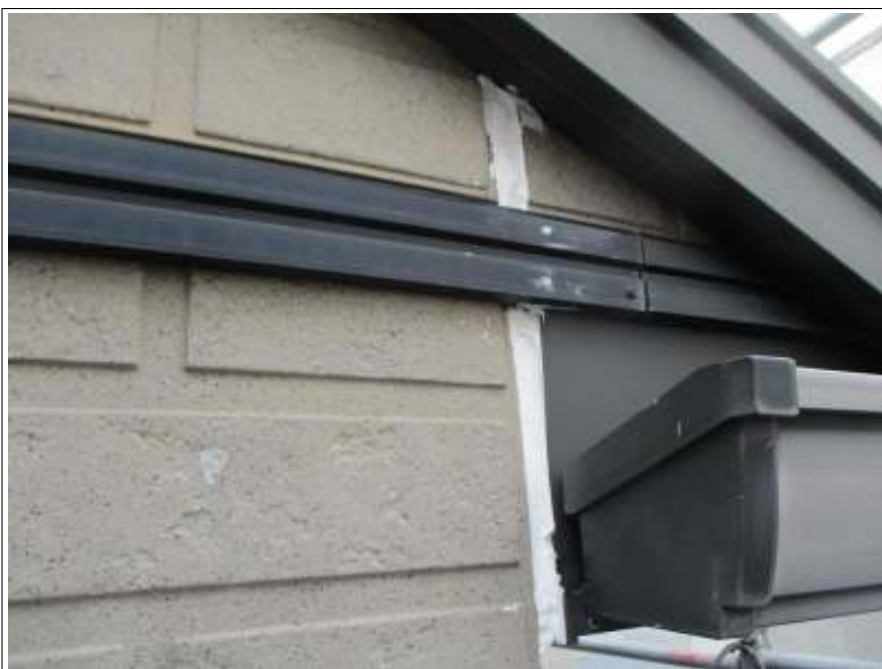
シーリング打ち替え 施工後
