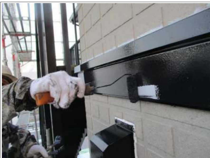
帯 上塗り（2回目）施工中
