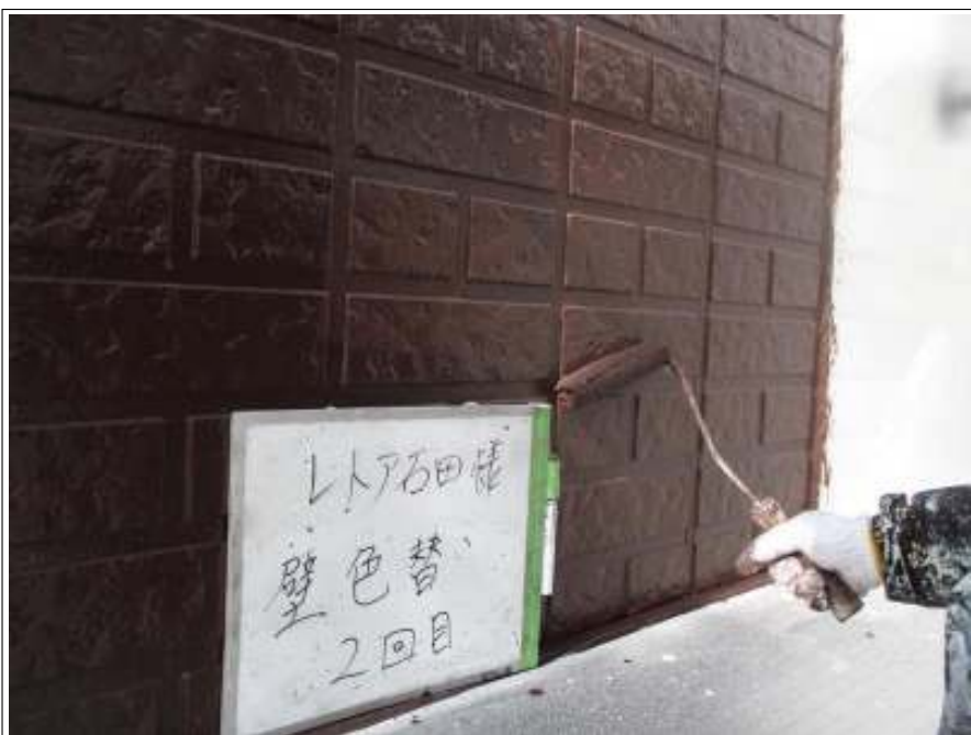
外壁 上塗り施工中
