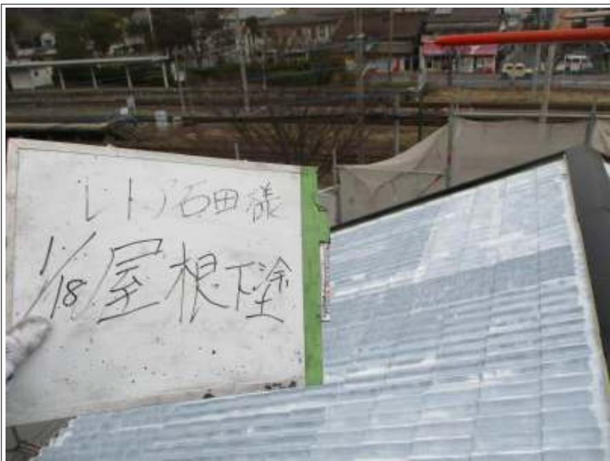
屋根 下塗り施工後
