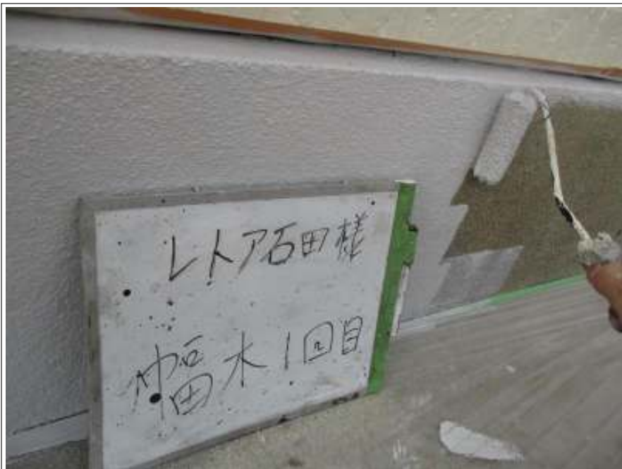
基礎 上塗り（1回目）施工中
