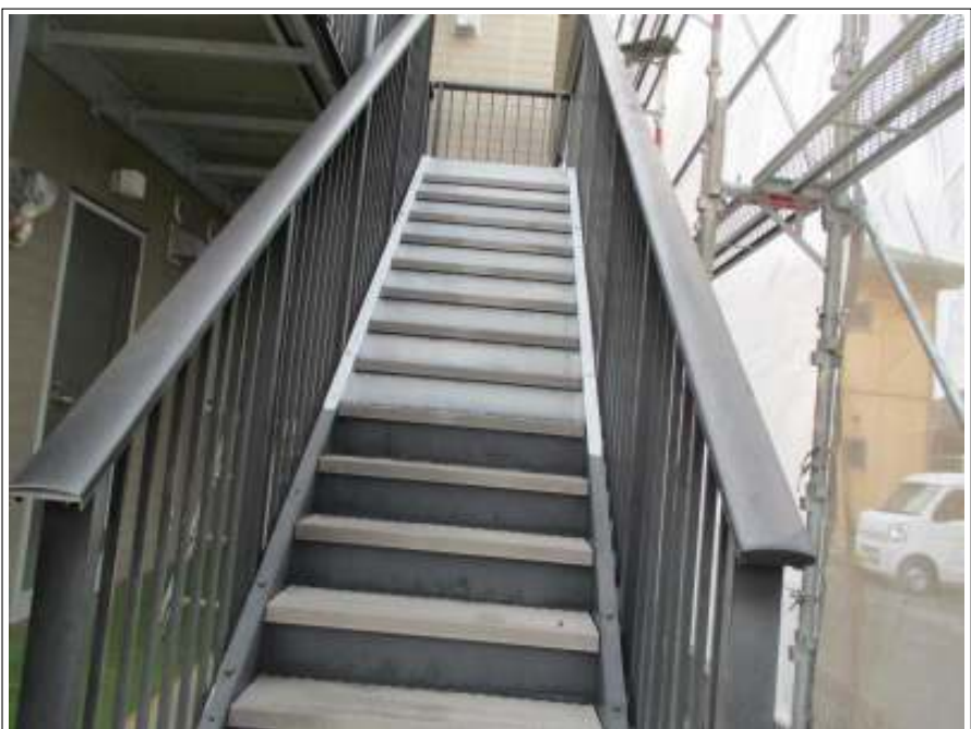
階段 サビ止め塗布施工中
