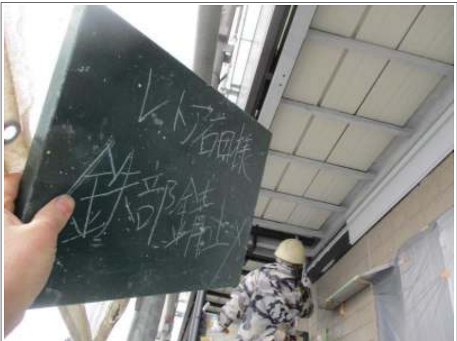
鉄部 サビ止め塗布施工中
