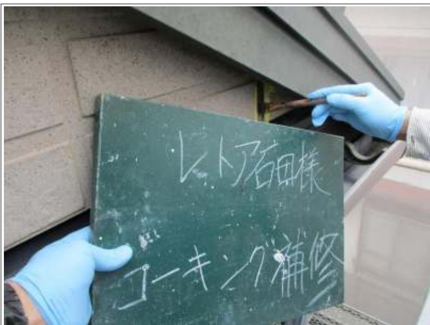
シーリング打ち替え 施工中
