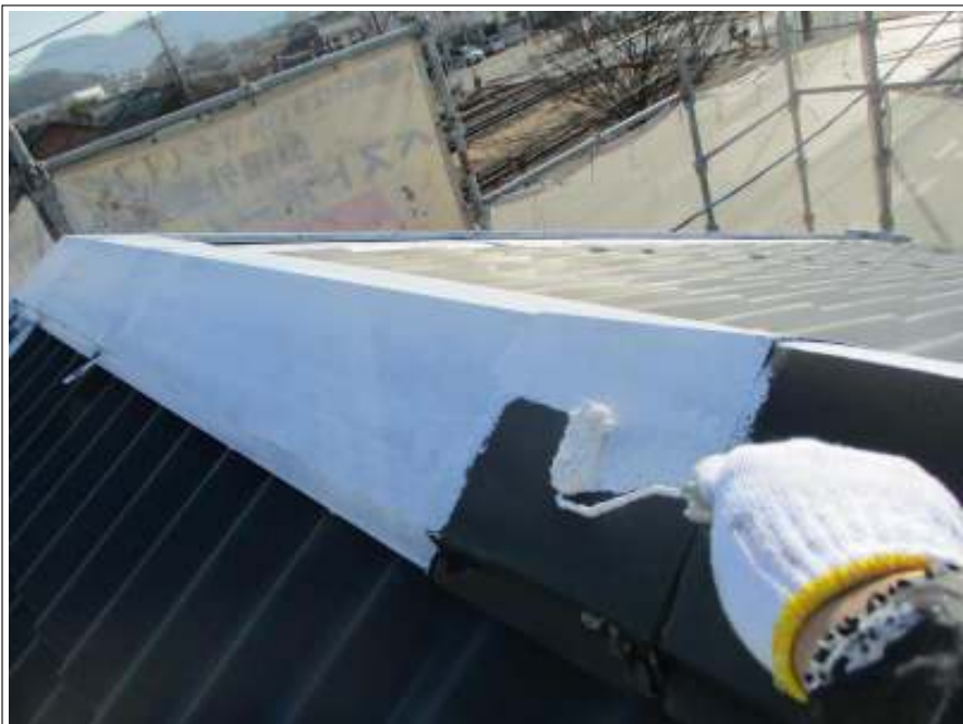
屋根板金部 サビ止め施工中
