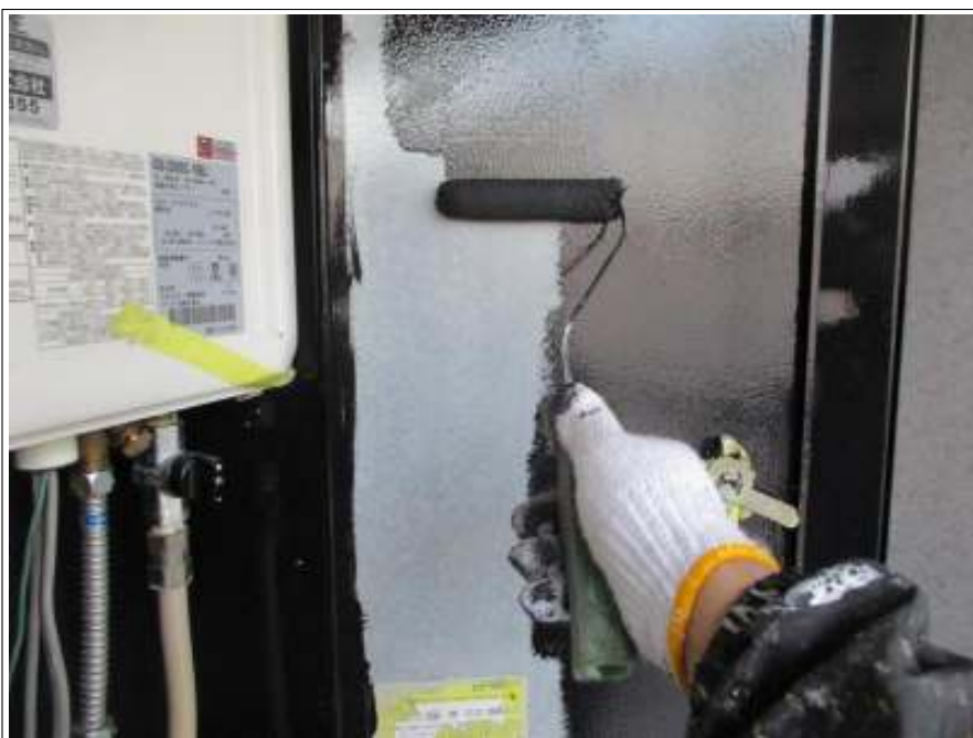
鉄部 上塗り施工中
