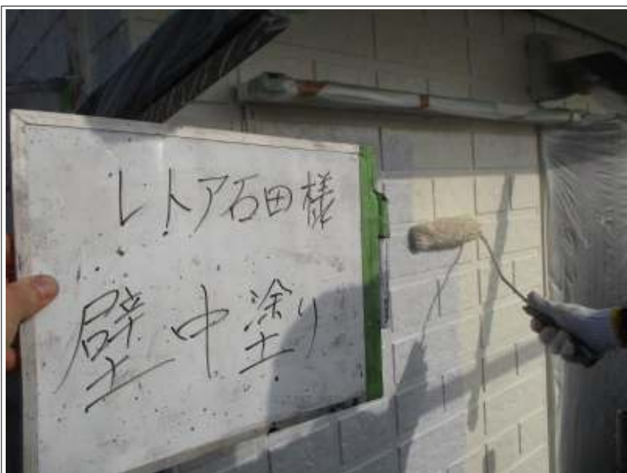
外壁 中塗り施工中
