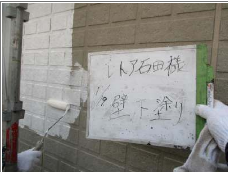
外壁 下塗り施工中
