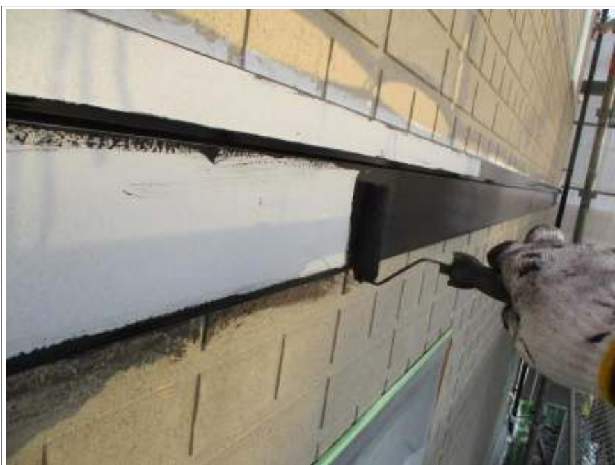
帯 上塗り（1回目）施工中
