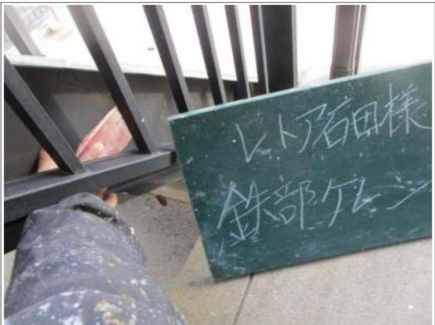
階段 ケレン処理施工中
