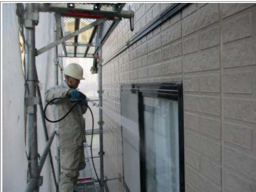
外壁 高圧洗浄中
