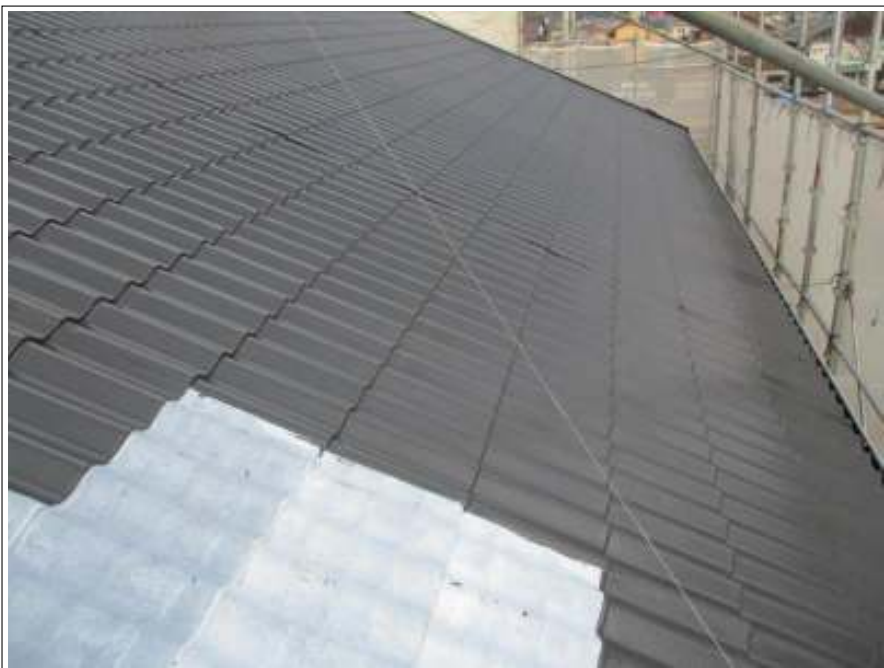
屋根 中塗り施工中
