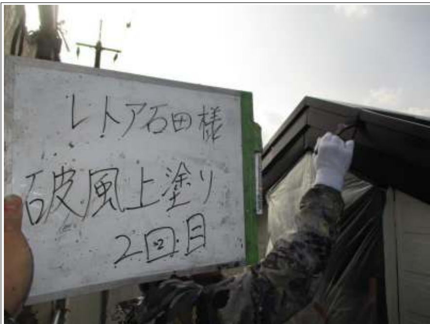
破風板 上塗り施工中
