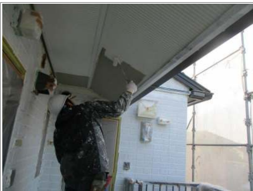
軒天 上塗り施工中
