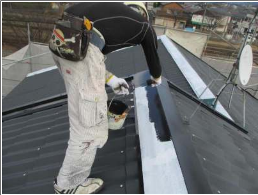
屋根板金部 上塗り(1回目) 施工中
