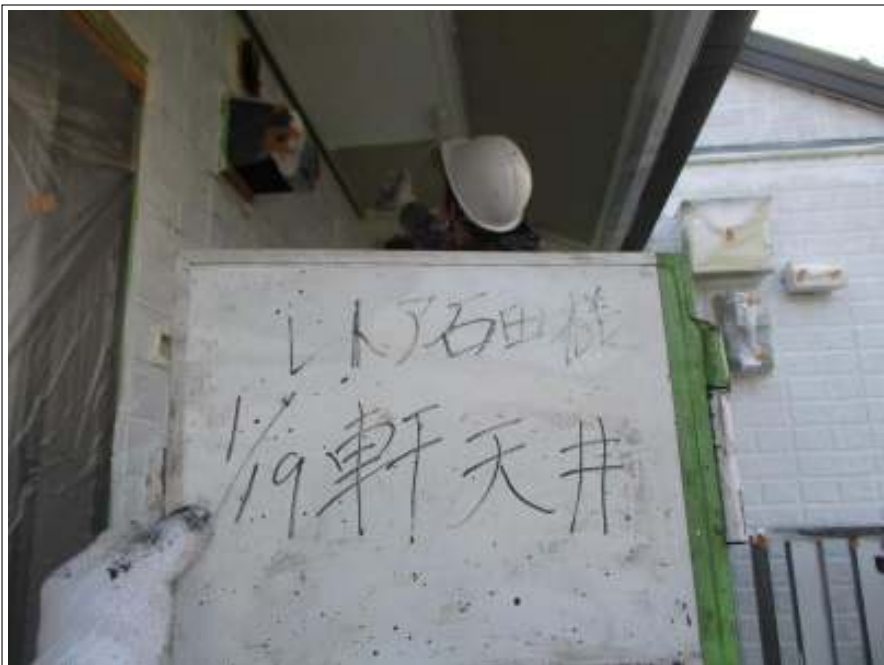
軒天 上塗り施工中
