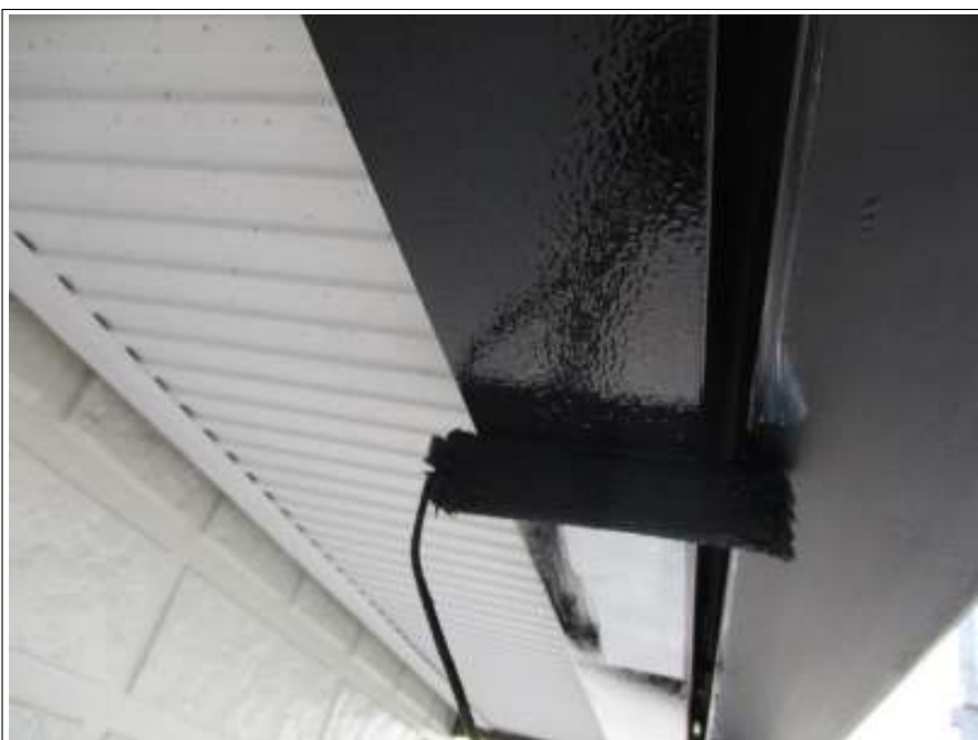
鼻隠し 上塗り施工中
