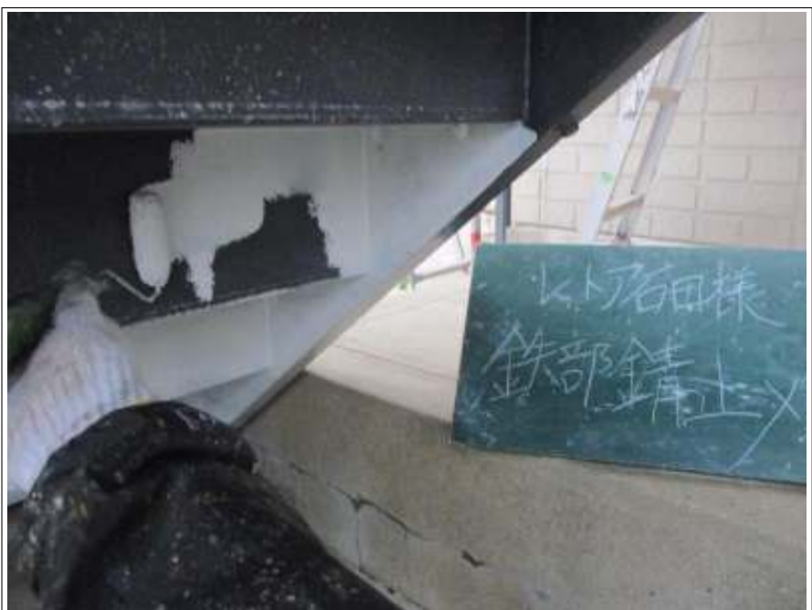
階段 サビ止め塗布施工中
