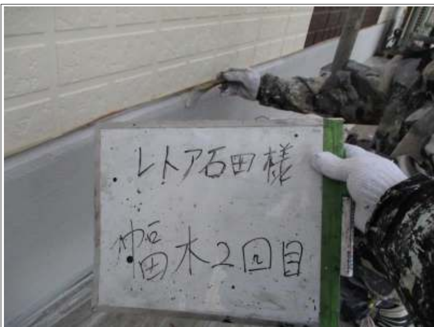
基礎 上塗り（2回目）施工中
