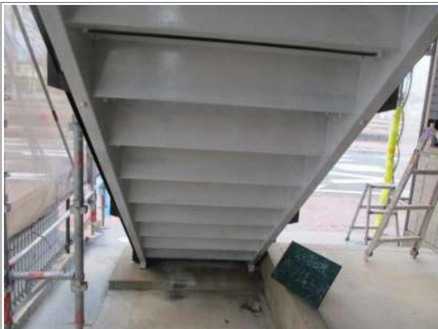
階段 サビ止め塗布施工後
