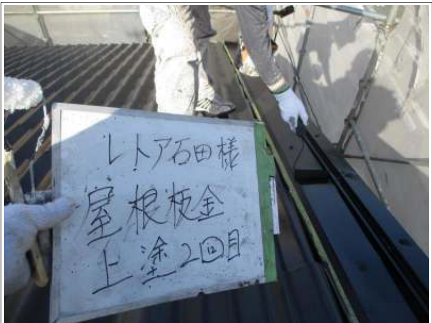
屋根板金部 上塗り(2回目) 施工中
