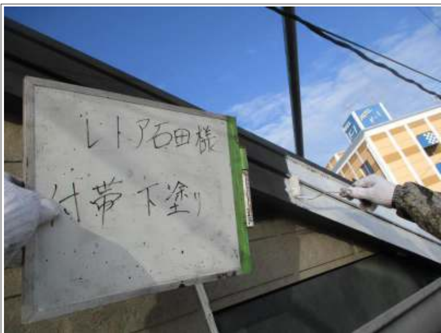
破風板 下塗り施工中
