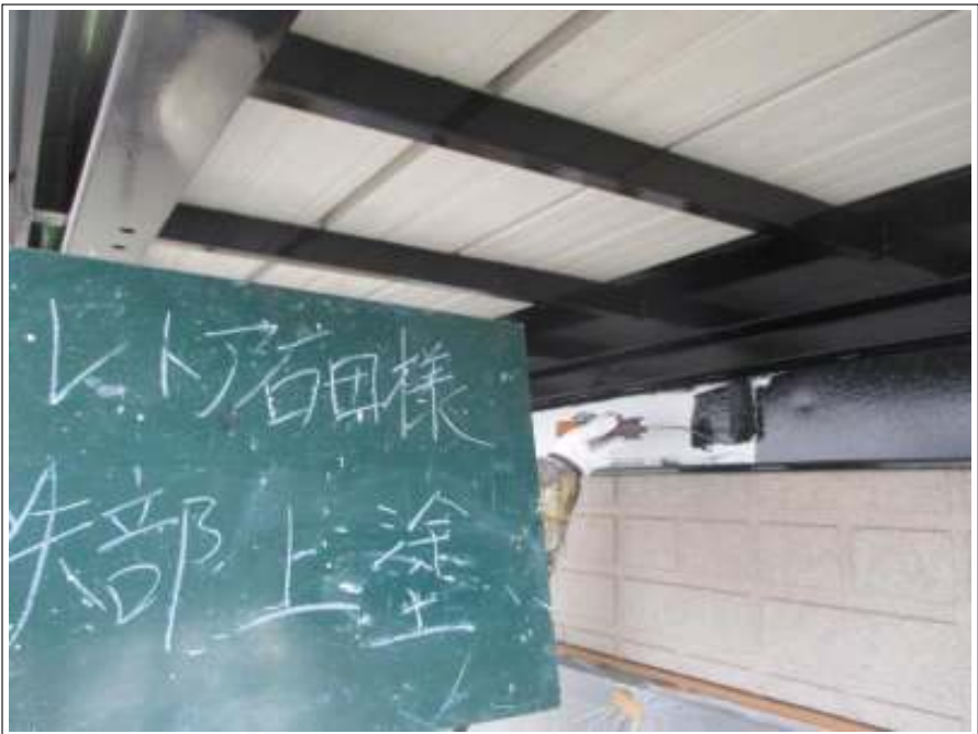
鉄部 上塗り施工中
