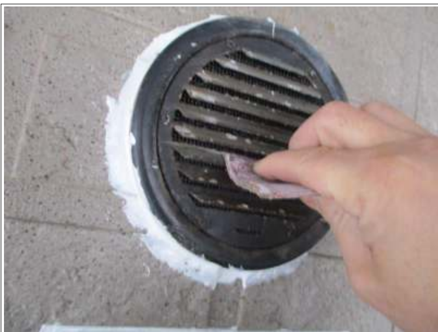
換気フード ケレン処理施工中
