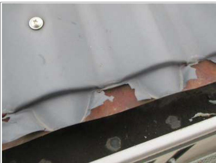
屋根 ケレン処理施工中
