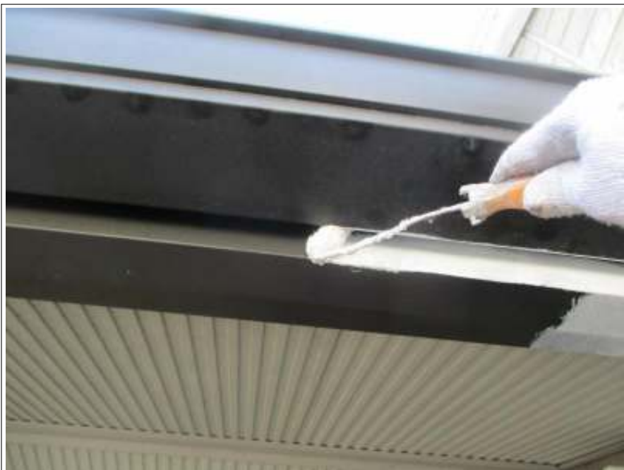
鼻隠し 下塗り施工中
