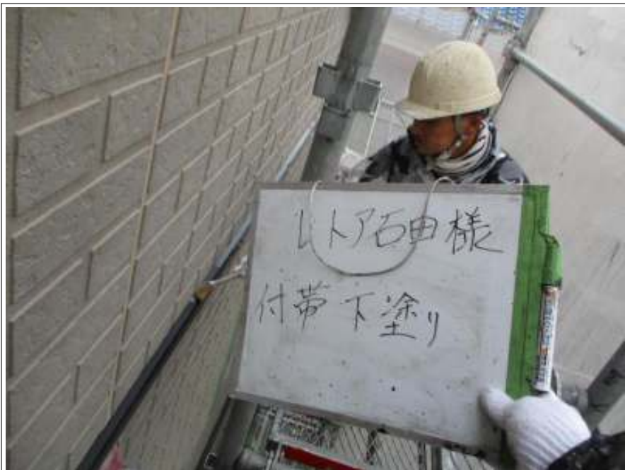
帯 下塗り施工中
