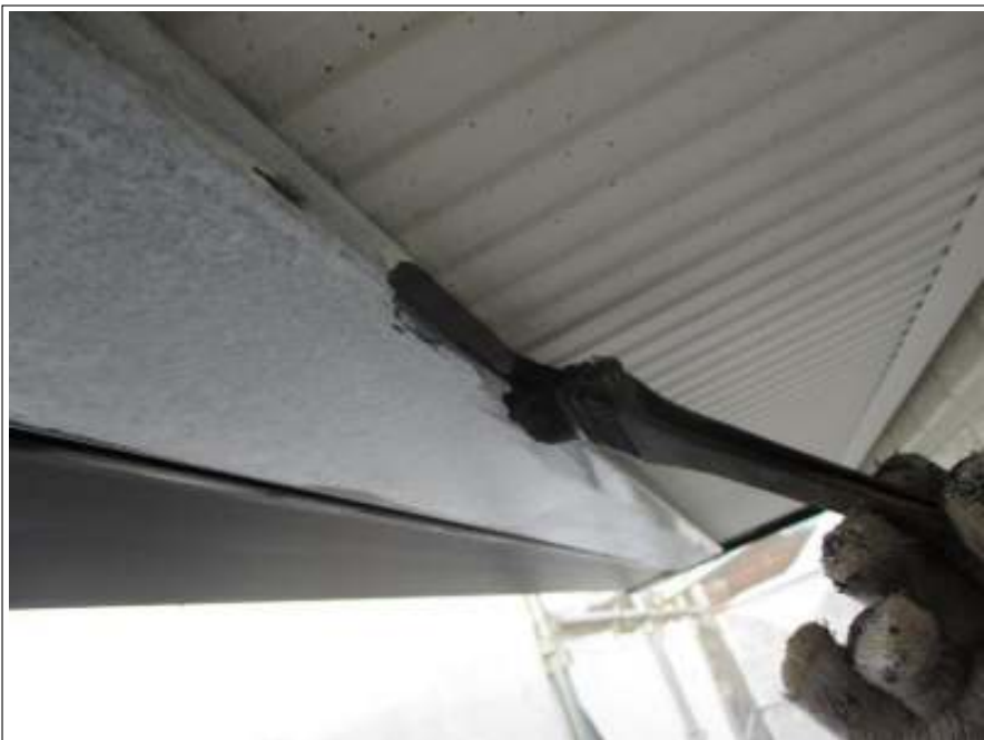
鼻隠し 上塗り施工中
