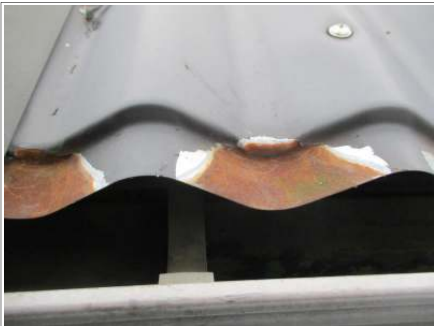
屋根 ケレン処理施工中
