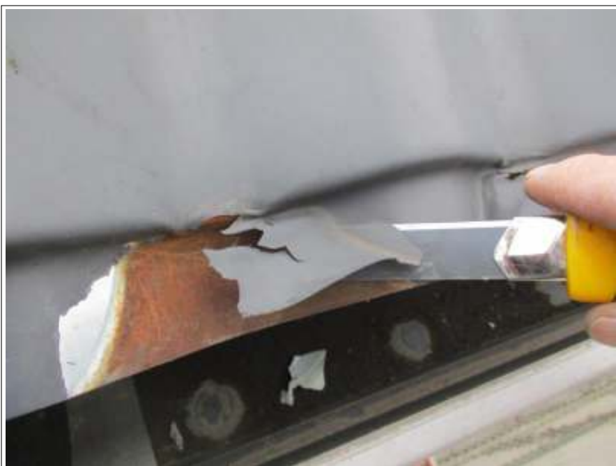
屋根 ケレン処理施工中
