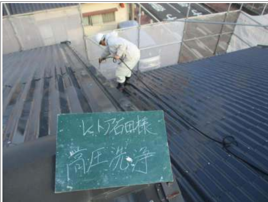
屋根 高圧洗浄中
