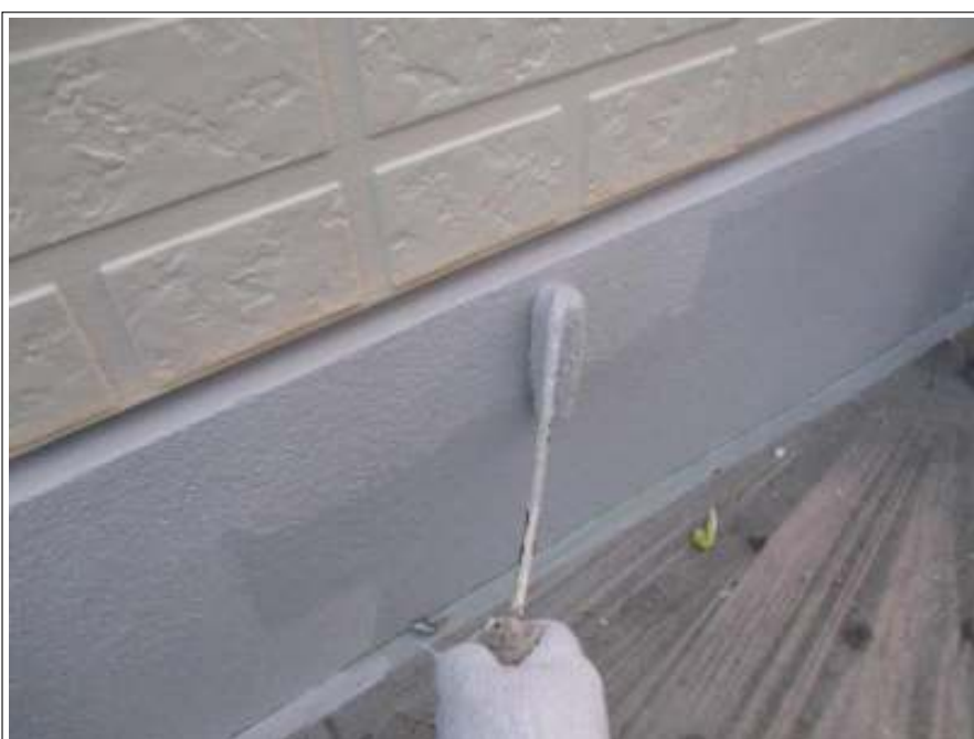
基礎 上塗り（2回目）施工中
