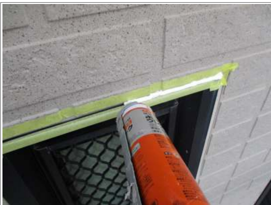
シーリング材充填
