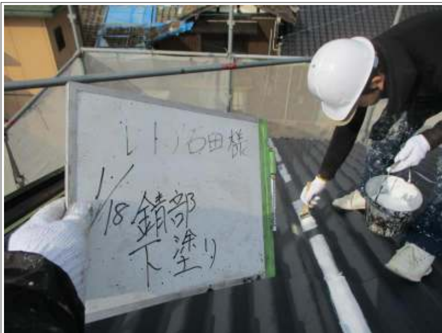
屋根 サビ止め施工中
