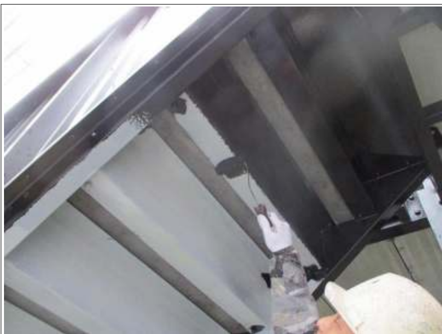
階段部 上塗り施工中
