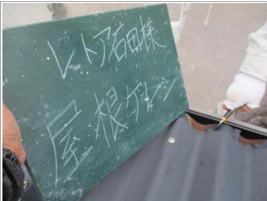
屋根 ケレン処理施工中
