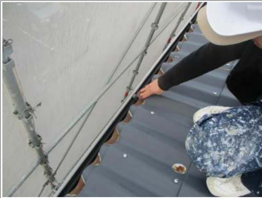
屋根 ケレン処理施工中
