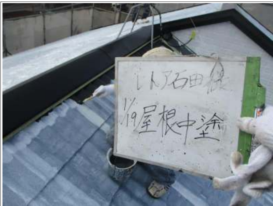
屋根 中塗り施工中
