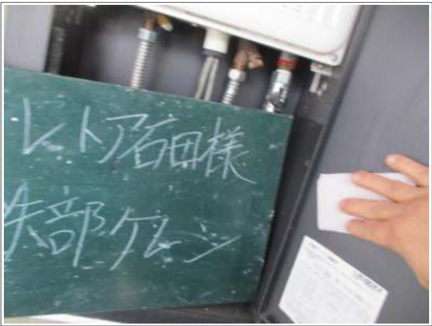
鉄部 ケレン処理施工中
