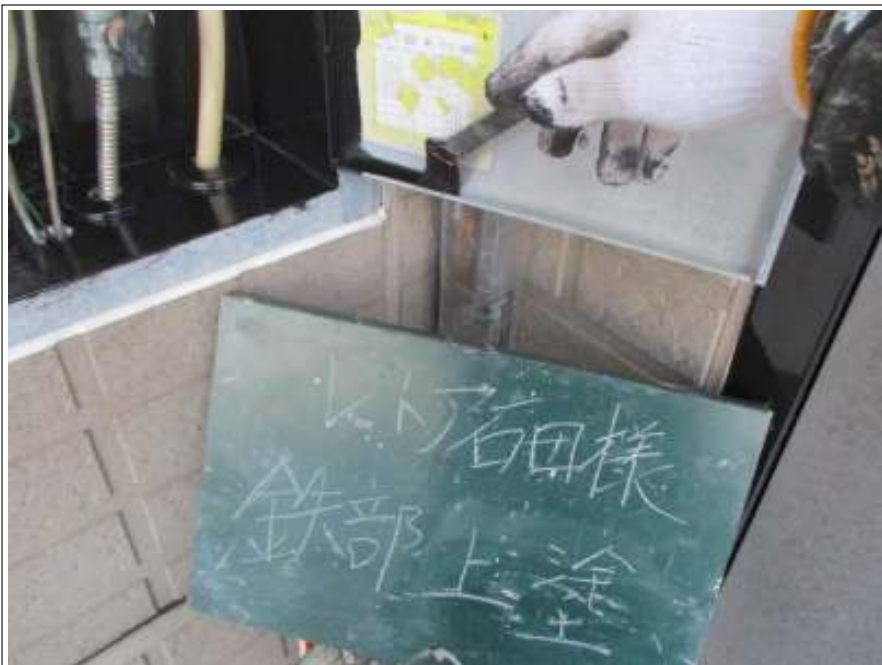
鉄部 上塗り施工中
