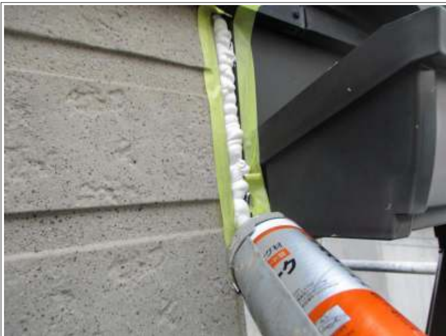
シーリング材充填
