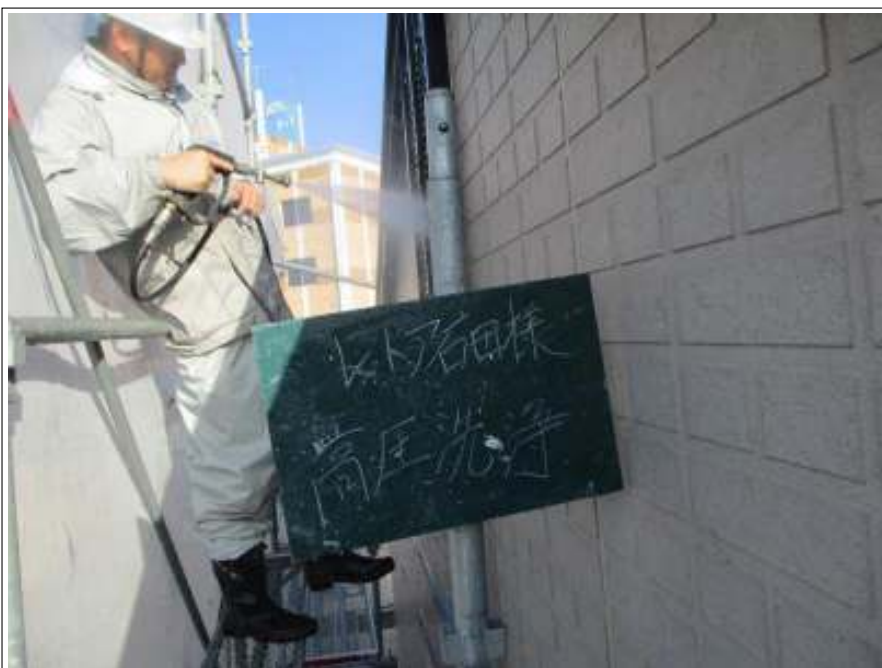
外壁 高圧洗浄中
