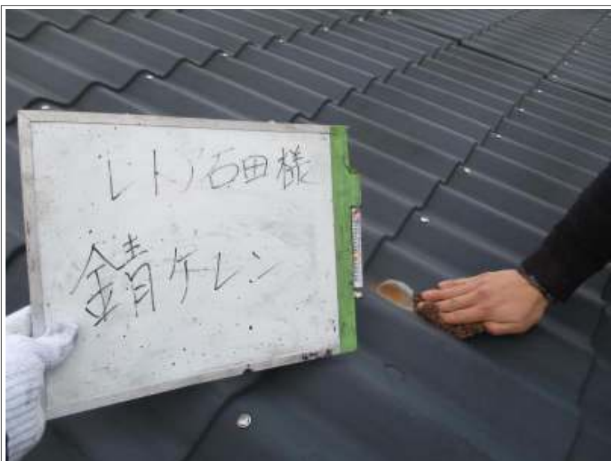
屋根 ケレン処理施工中
