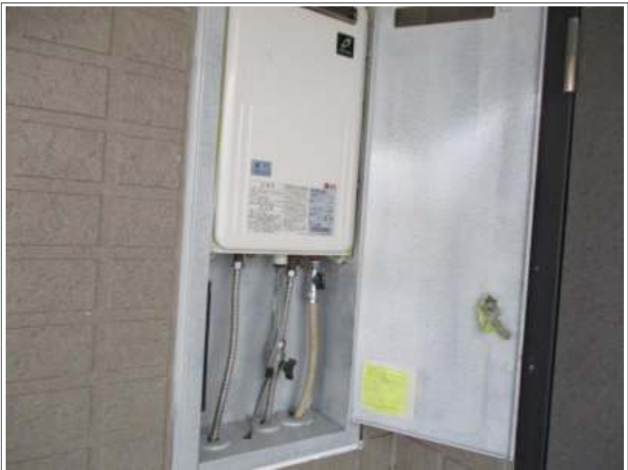
鉄部 サビ止め塗布施工後
