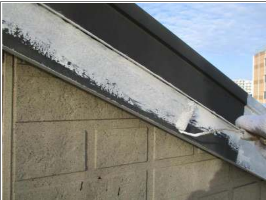
破風板 下塗り施工中
