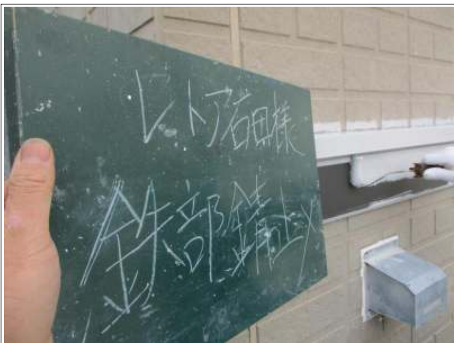
帯 サビ止め施工中
