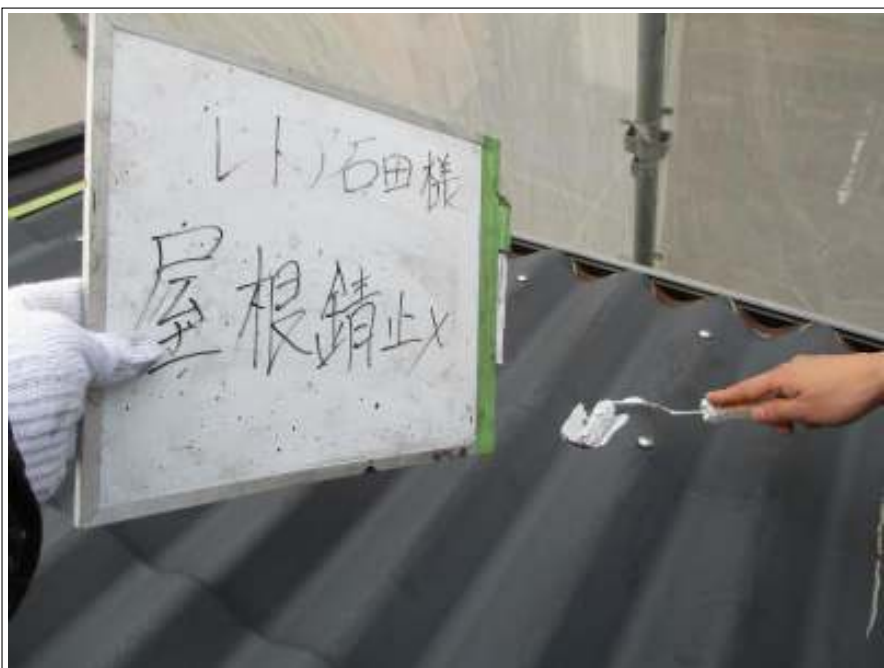
屋根 サビ止め施工中
