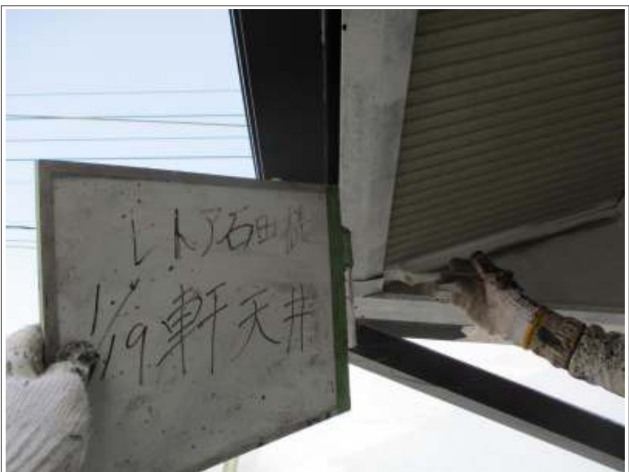
軒天 下塗り施工中
