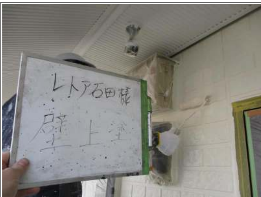
外壁 上塗り施工中
