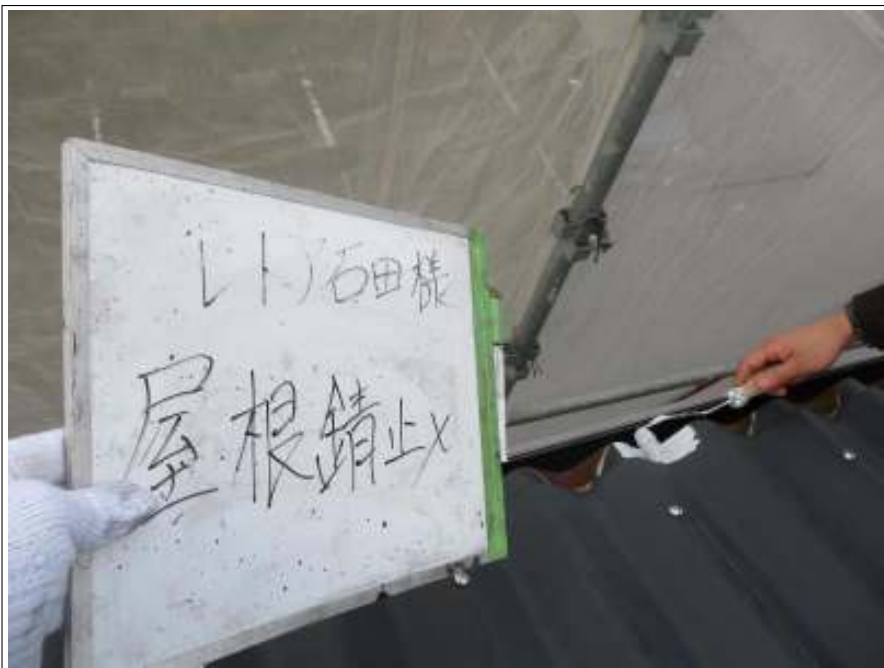
屋根 サビ止め施工中
