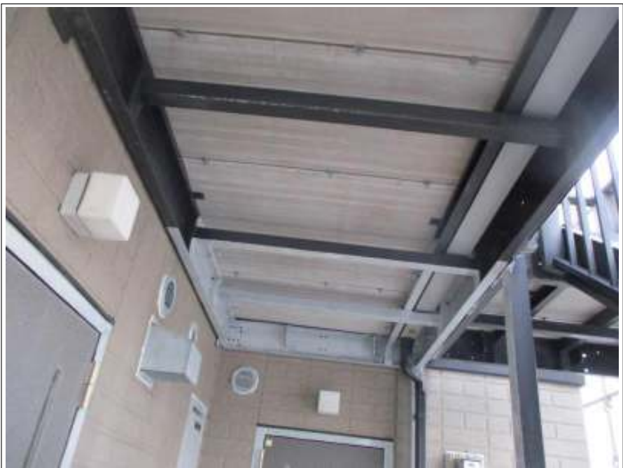
鉄部 上塗り施工中
