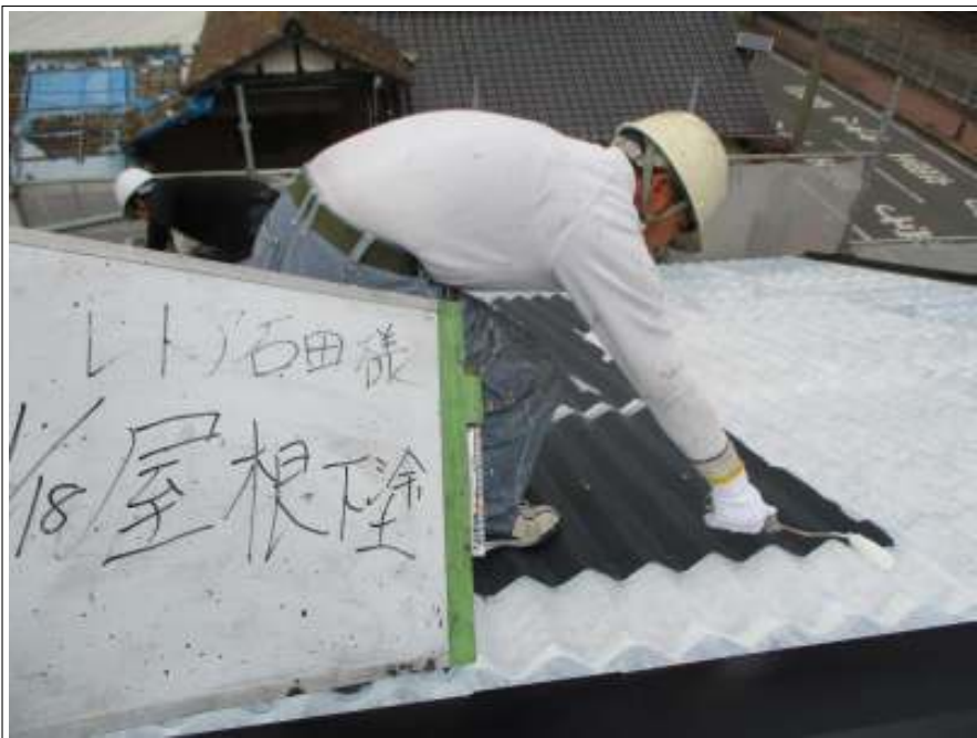
屋根 下塗り施工中
