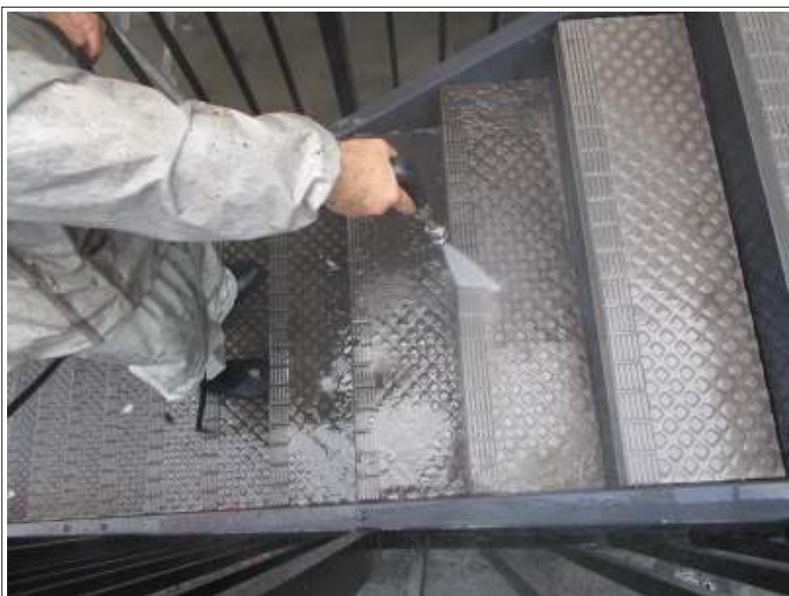
階段 高圧洗浄中
