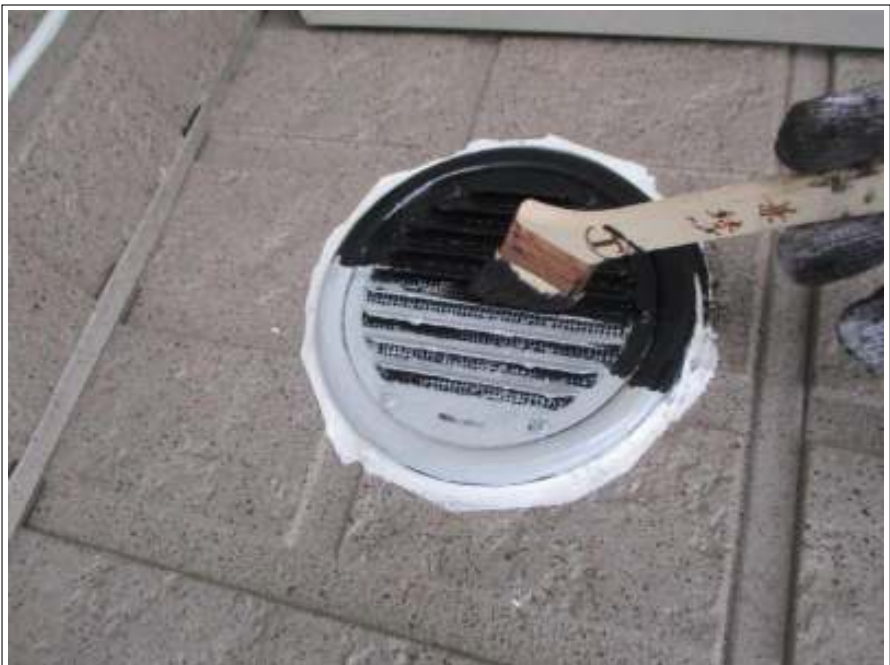
換気フード 上塗り施工中
