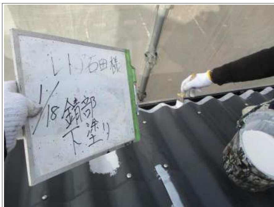
屋根 サビ止め施工中
