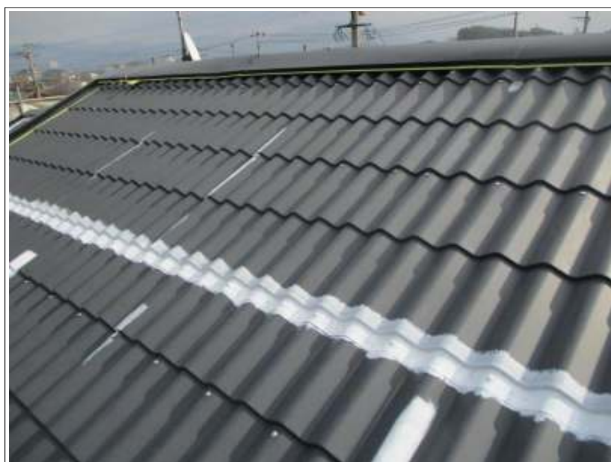
屋根 サビ止め施工中
