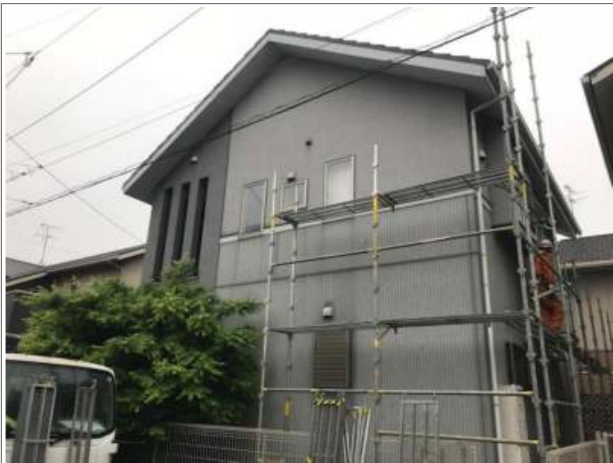
仮設足場組立 施工中
