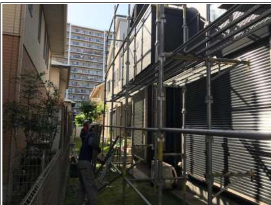
仮設足場解体 施工中
