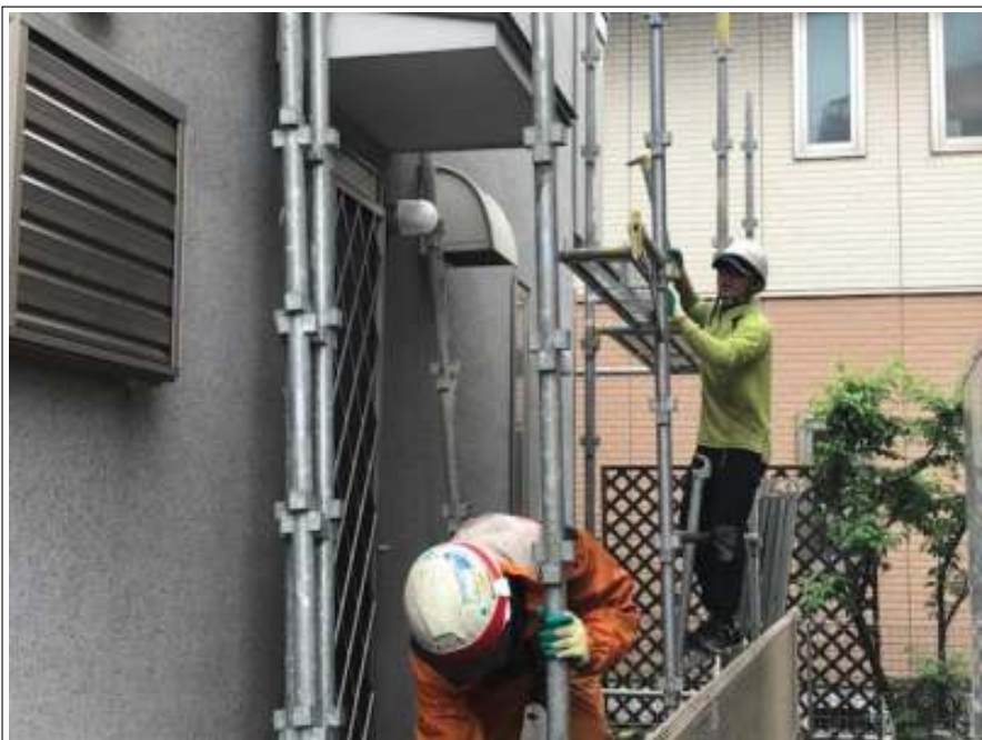
仮設足場組立 施工中
