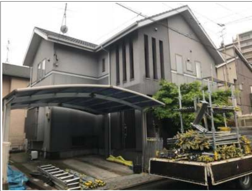
仮設足場組立 施工中
