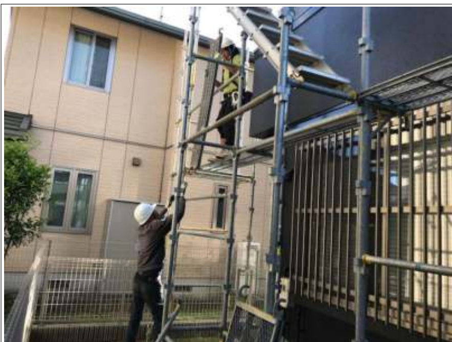
仮設足場解体 施工中
