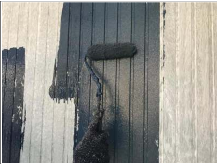
1階外壁部 中塗り 施工中
