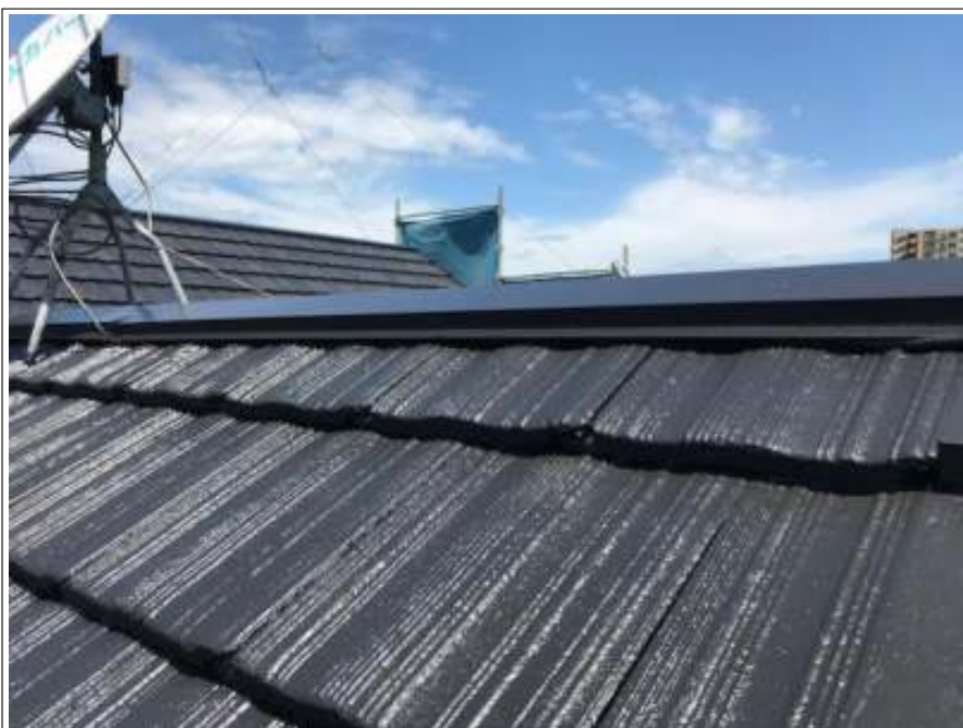
屋根 上塗り 施工完了
