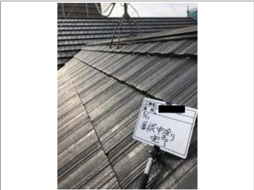
屋根 中塗り 施工完了
