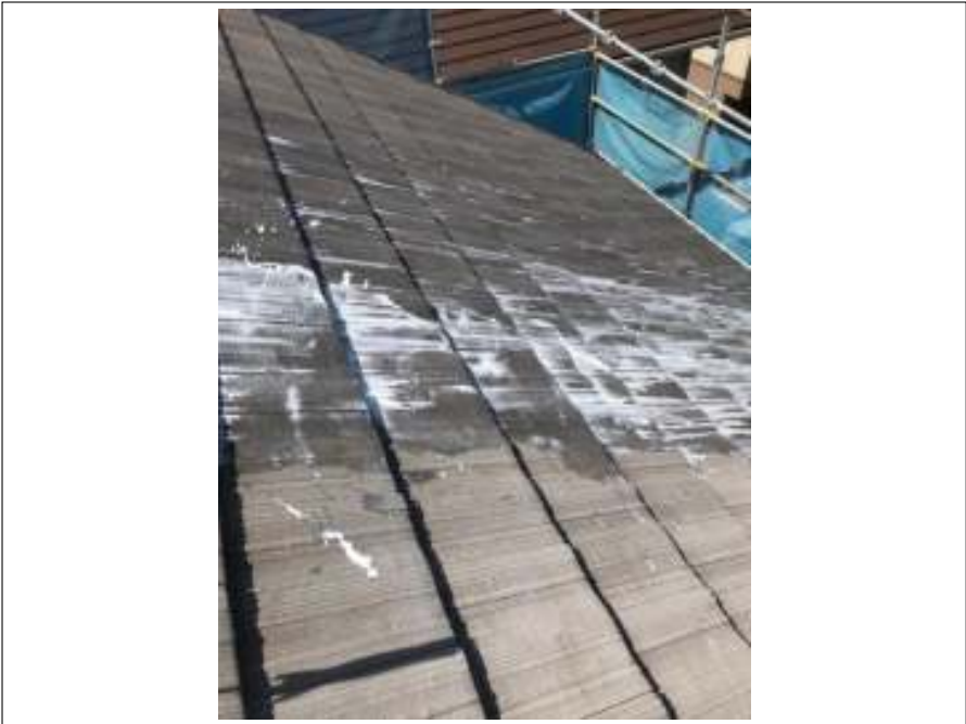
屋根 下塗り 施工中
