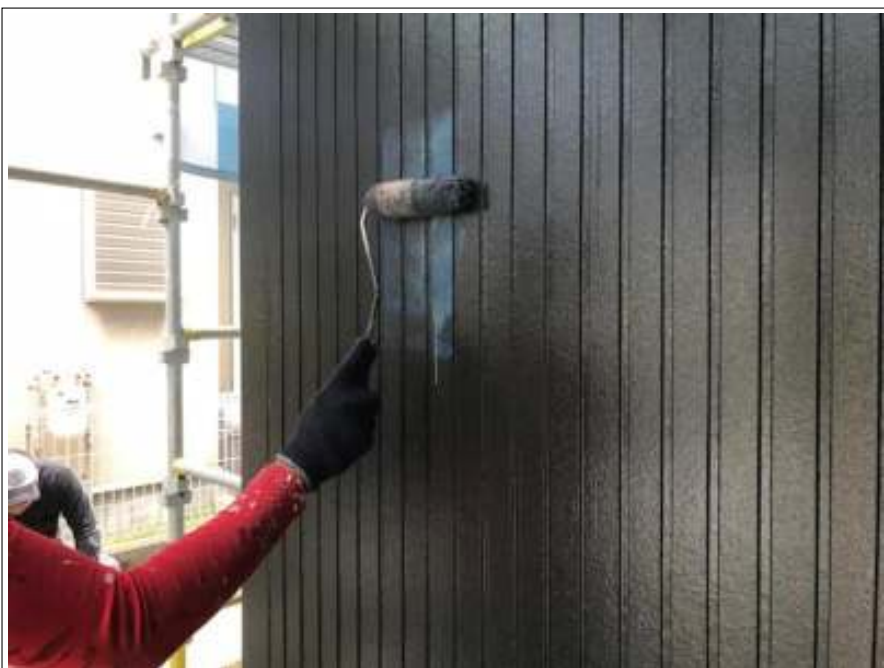
1階外壁部 上塗り 施工中
