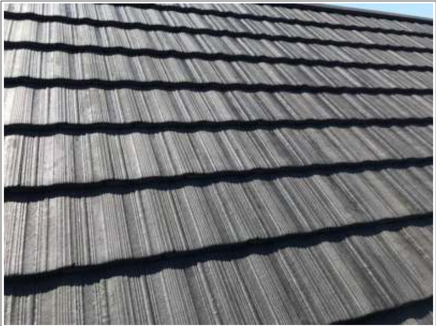
屋根 下塗り 施工完了
