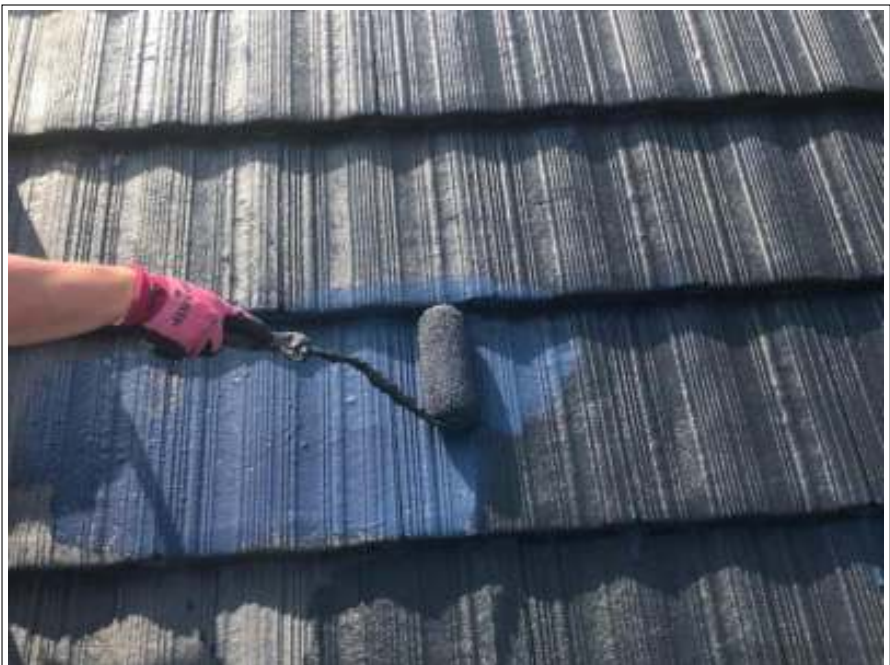
屋根 中塗り 施工中
