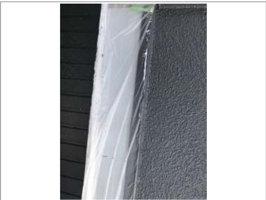
2階外壁部 中塗り 施工後
