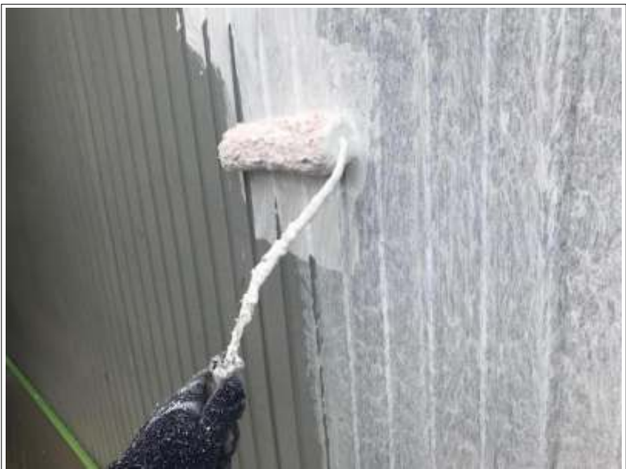
外壁 下塗り 施工中
