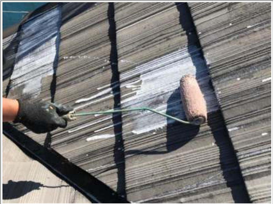
屋根 下塗り 施工中
