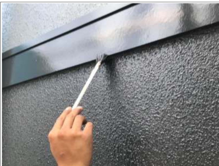
幕板塗装 施工中
