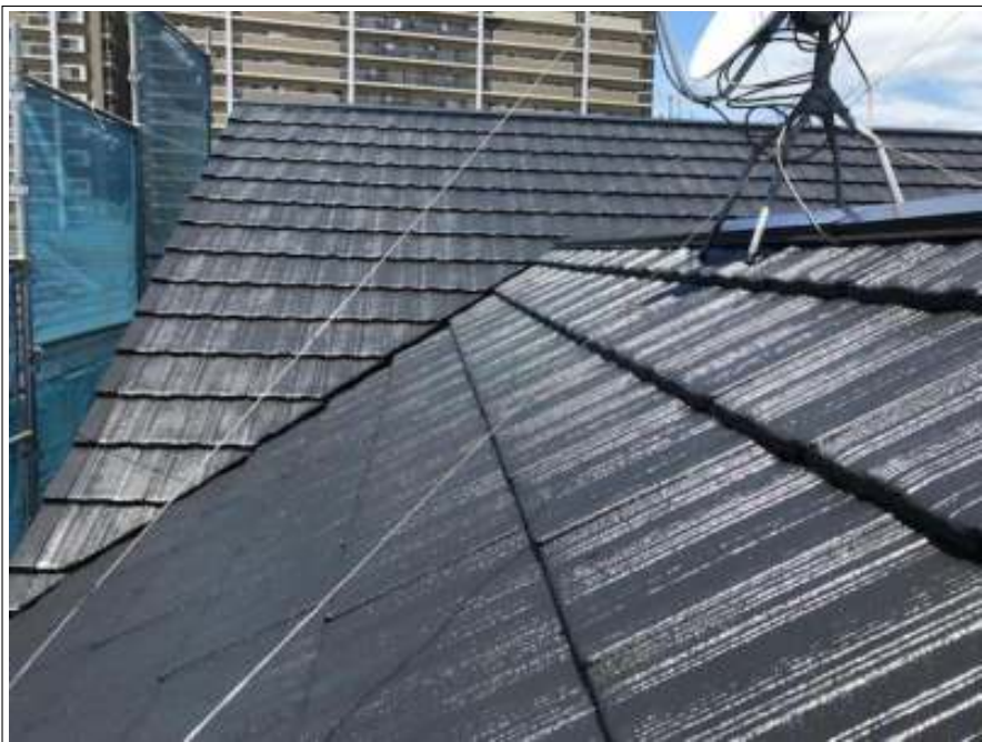
屋根 上塗り 施工完了
