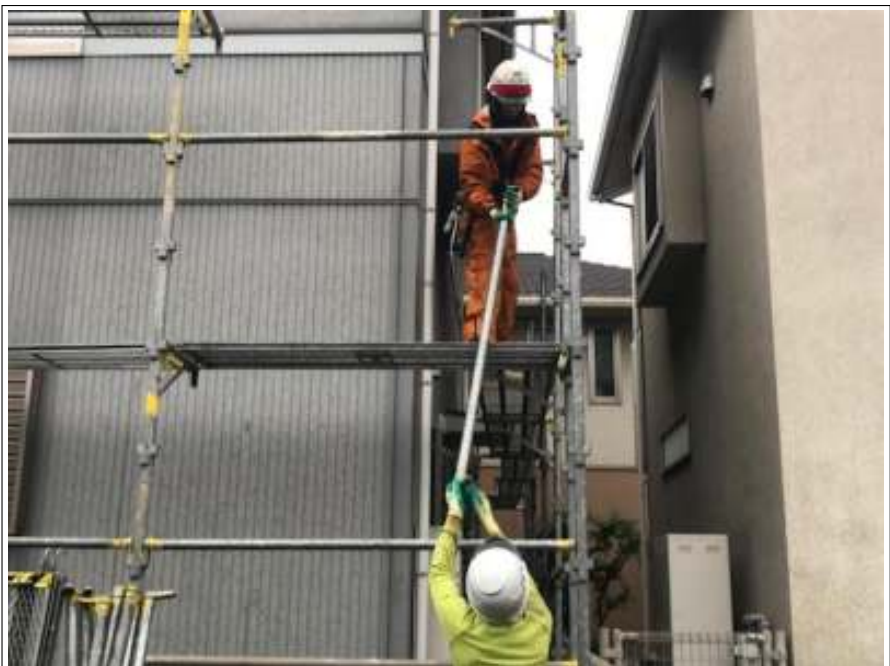
仮設足場組立 施工中
