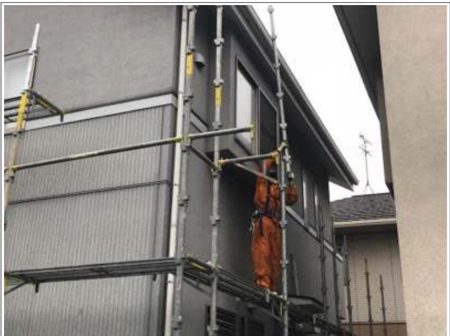
仮設足場組立 施工中
