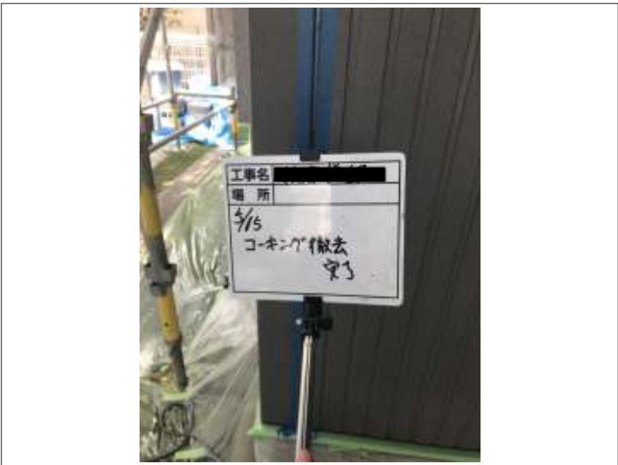
シーリング撤去 完了
