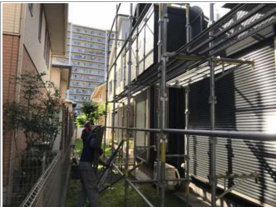
仮設足場解体 施工中
