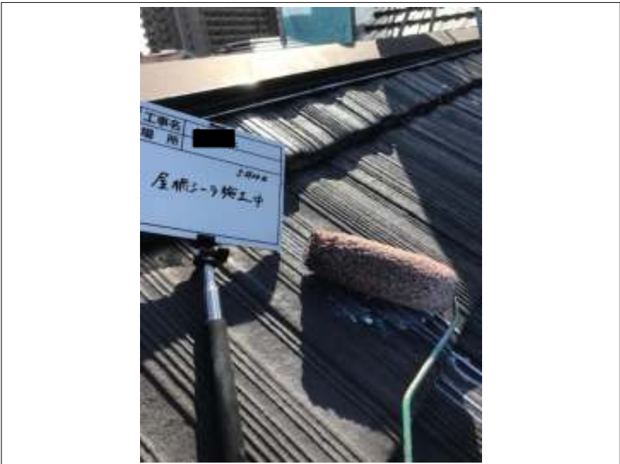
屋根 下塗り 施工中
