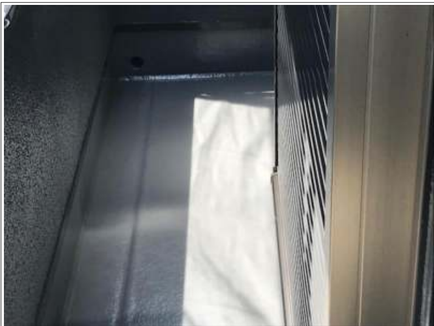
ベランダ床 上塗り 施工完了
