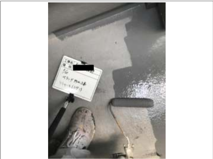
ベランダ床 上塗り 施工中
