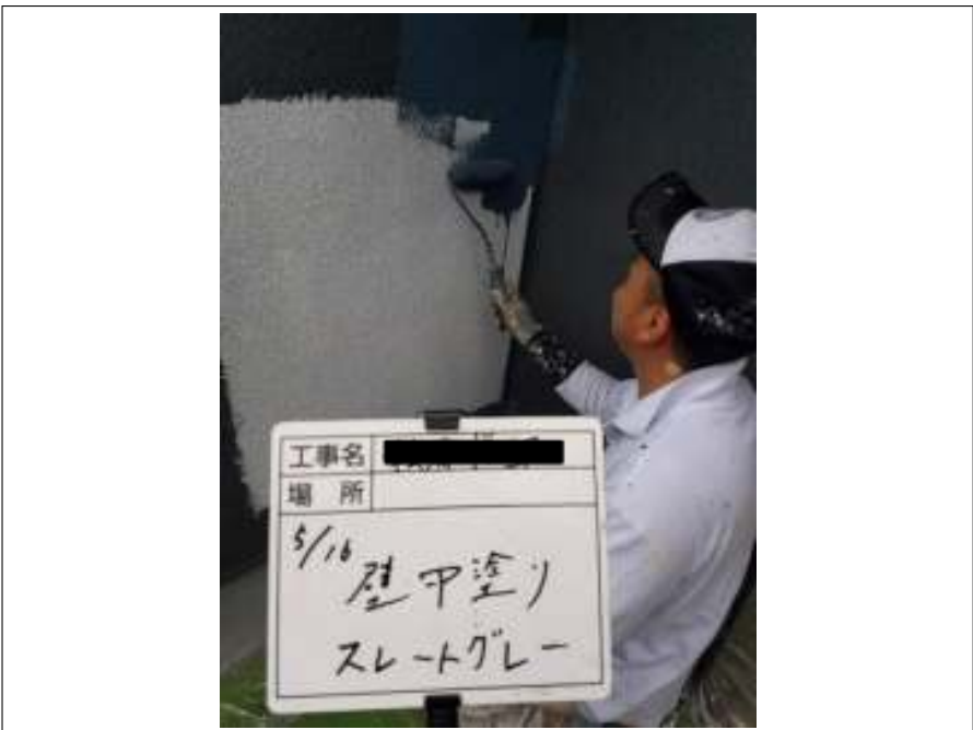
2階外壁部 中塗り 施工中
