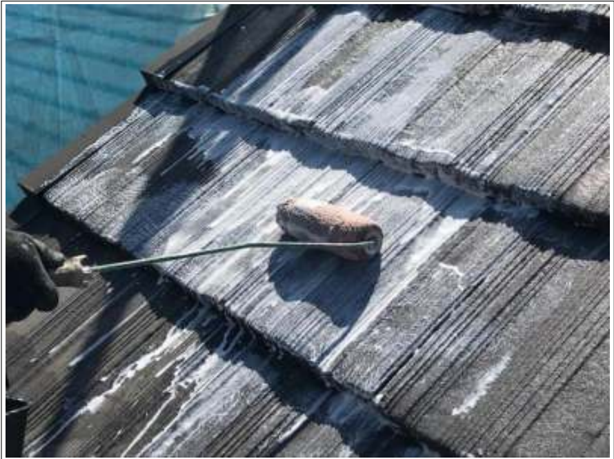
屋根 下塗り 施工中
