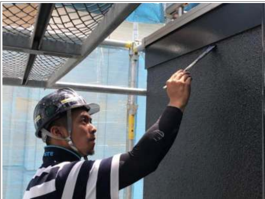
幕板塗装 施工中
