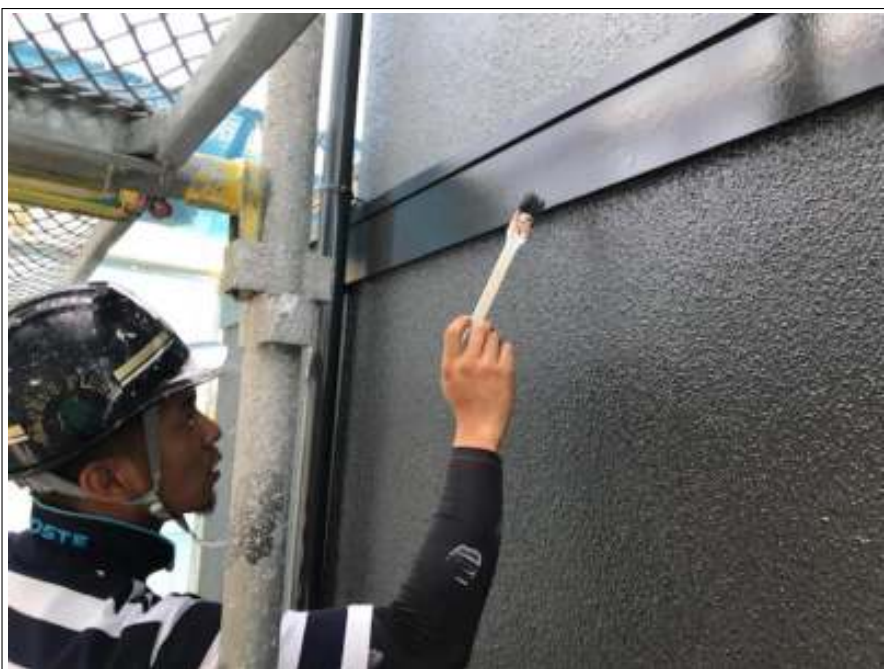
幕板塗装 施工中
