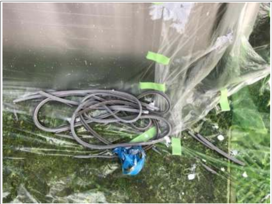
シーリング撤去後
