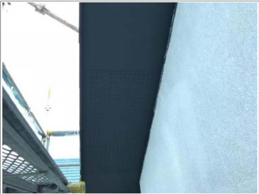
軒天塗装 施工完了
