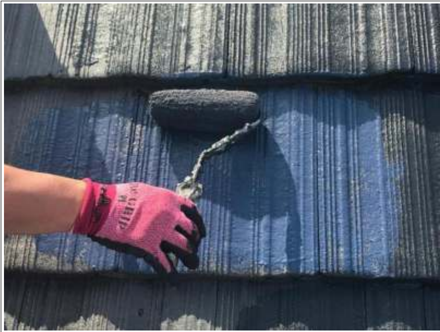
屋根 上塗り 施工中
