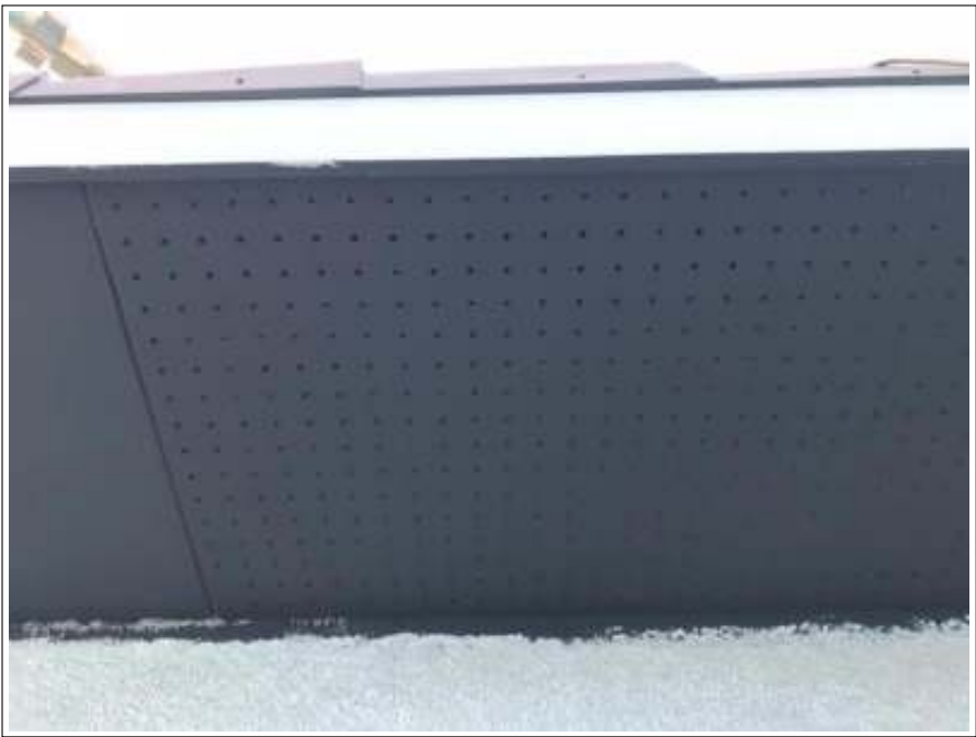
軒天塗装 施工完了
