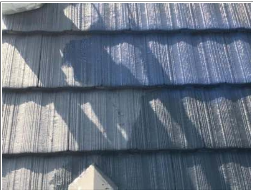
屋根 中塗り 施工中
