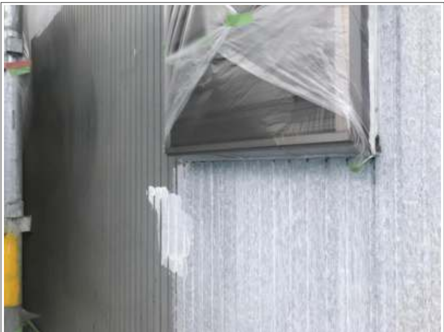
外壁 下塗り 施工中
