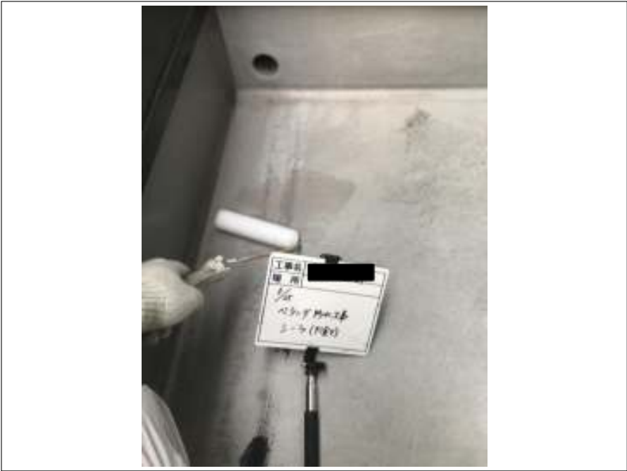
ベランダ床 下塗り 施工中
