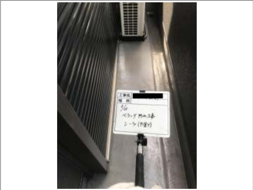
ベランダ床 下塗り 施工中
